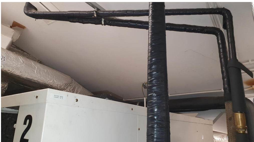
Instalacja freonowa w maszynowni.
