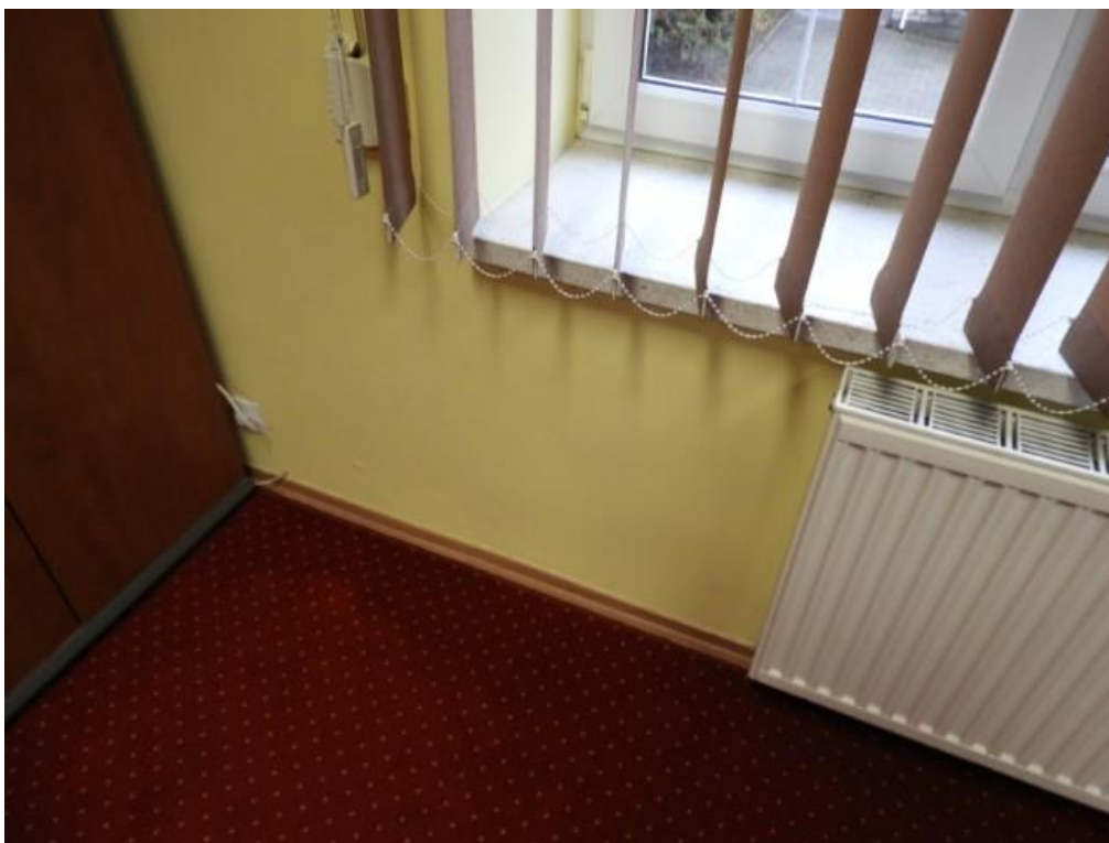
9. Gabinet Dyrekcji. Nowa powłoka malarska na ścianach uprzednio zawilgoconych.
