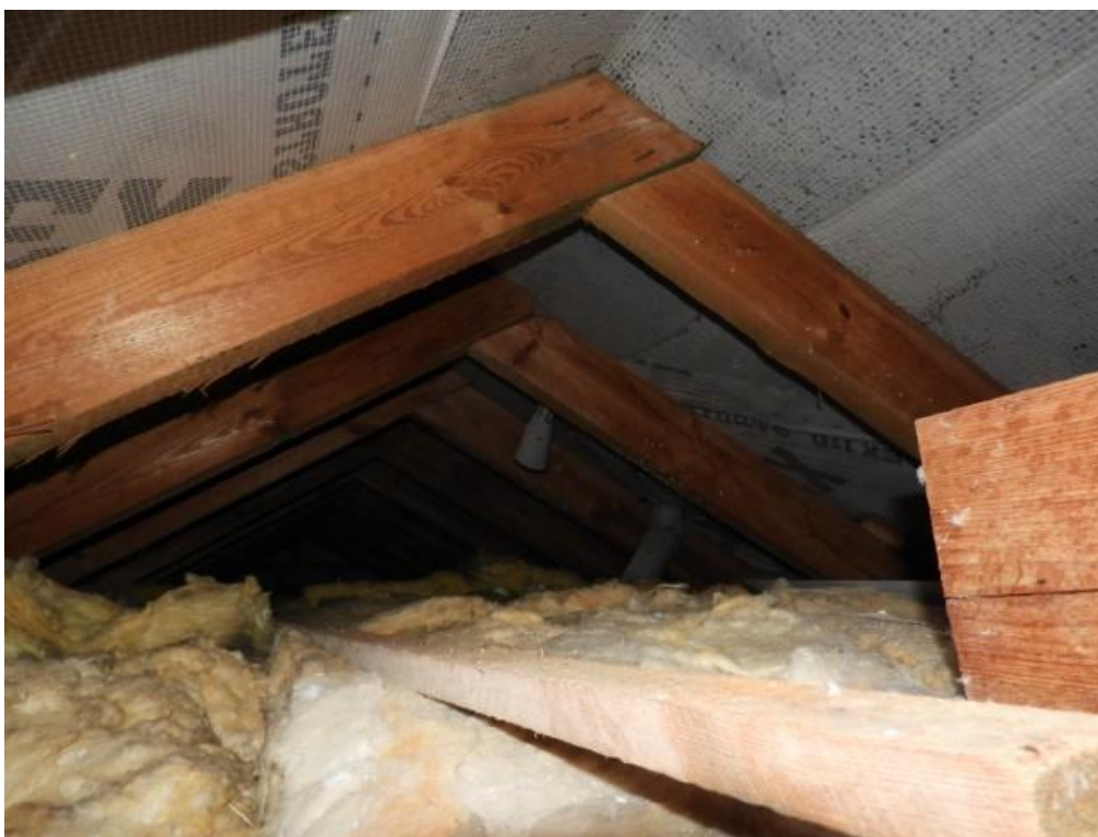
4. Fragment więźby dachowej.
