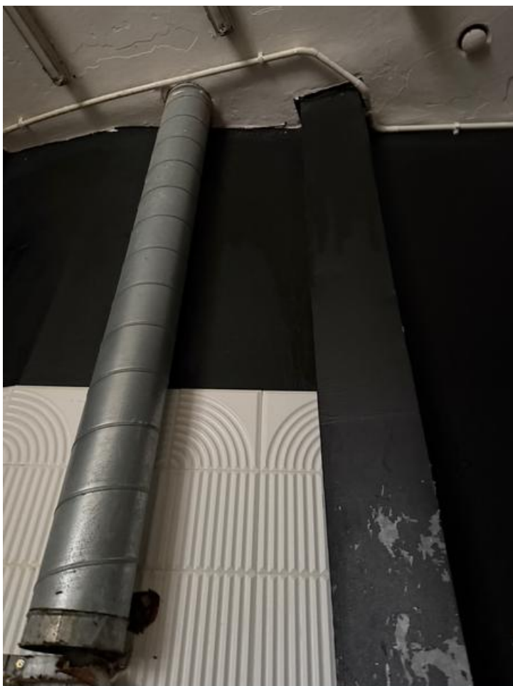
Rys.2. Istniejące kanały wentylacyjne
