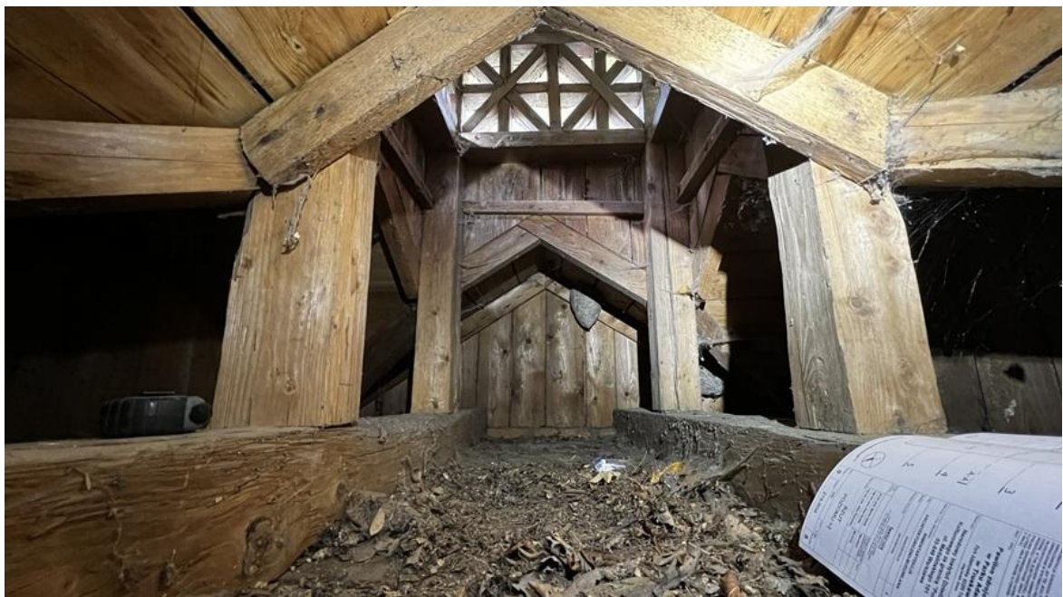
Fot.24. Widok wnętrza poddasza oraz wnętrza sygnaturki (wieżyczki), w pawilonie „Józia”.
