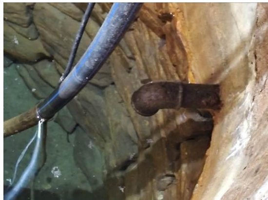
Fot.29-30. Widok wnętrza studni w pawilonie „Józia”. Zachowana kamienna cembrowina studni w dolnym poziomie oraz piaszczyste dno.
