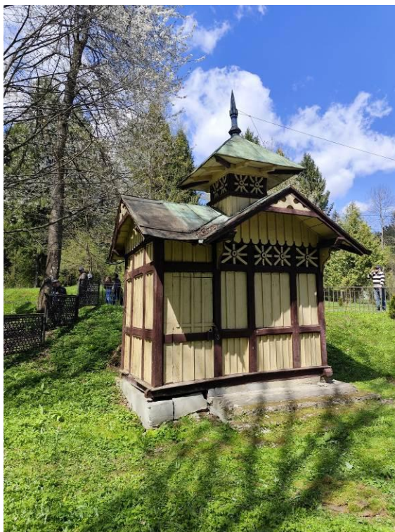
Fot.8. Widok ogólny na pawilon „Józia” od strony południowej. Widok wprost na elewację boczną, południową. Lewa strona tej ściany budynku (skrajne kwatery szkieletu), została wtórnie dobudowana wraz z dachem, i uformowanymi w niej drzwiami zapleczowymi.
