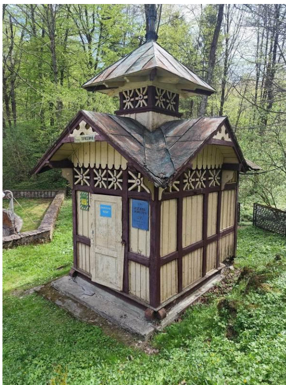
Fot.4. Widok ogólny na pawilon „Józia” od strony północnej. Po lewej stronie elewacja frontowa północno-wschodnia, z drzwiami wtórnie wstawionymi w trakcie współczesnej przebudowy i dobudowy pawilonu.
