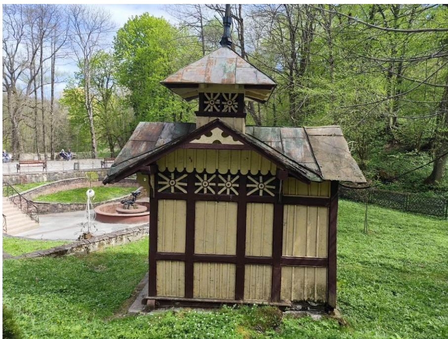
Fot.3. Widok ogólny na pawilon „Józia” od strony północno-zachodniej. Widoczna ściana to elewacja boczna, północna pawilonu „Józia”. Prawa strona budynku (skrajne kwatery szkieletu), została wtórnie dobudowana wraz z dachem.
