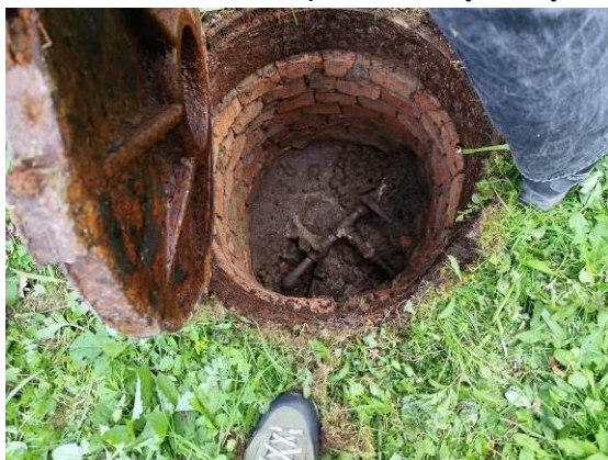
Fot.33. Studzienka podziemna na południe od pawilonu „Józia”. Widoczne niezidentyfikowane rury i zawory odcinające, zapewne połączone z instalacją wody ze studni zaopatrującą kraniki w sąsiednim półkolistym murze oporowym. Fot.34-35. Tabliczki informujące od zabytkowym pawilonie „Józia”.
