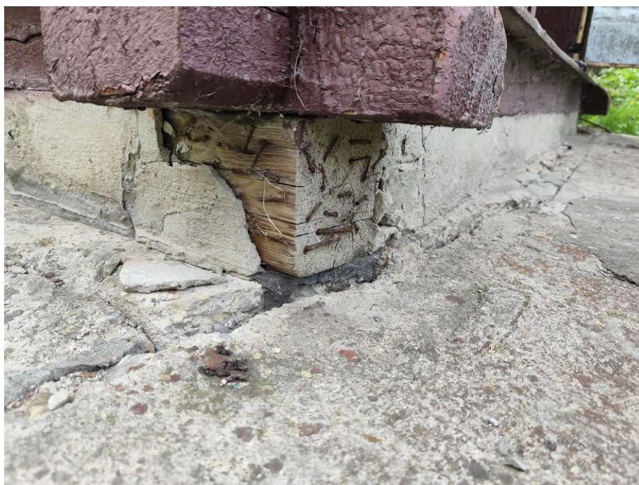
Fot.11. Widok ogólny na wschodni narożnik z podwaliną pawilonu „Józia”. Podmurówka pod podwalinami częściowo wykonana z drewnianych i otynkowanych kantówek.
