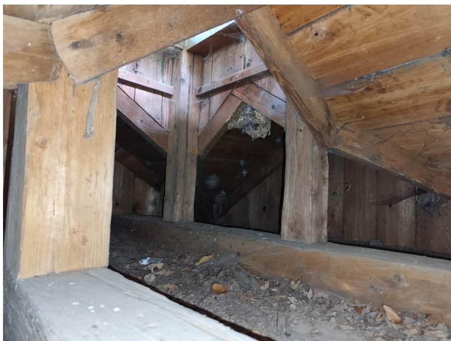
Fot.14. Widok wnętrza poddasza w pawilonie „Józia”. Widok od strony przybudówki.
