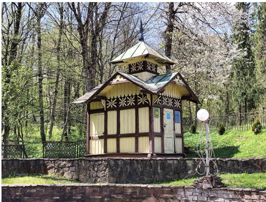
Fot.2. Widok ogólny na pawilon „Józia” od strony wschodniej, z poziomu podwalin. Widoczna lewa ściana to elewacja boczna, południowa pawilonu „Józia”. Lewa strona tej ściany budynku (skrajne kwatery szkieletu), została wtórnie dobudowana wraz z dachem, i uformowanymi w niej drzwiami zapleczowymi.
