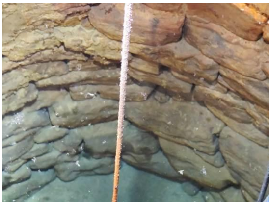
Fot.29-30. Widok wnętrza studni w pawilonie „Józia”. Zachowana kamienna cembrowina studni w dolnym poziomie oraz piaszczyste dno.
