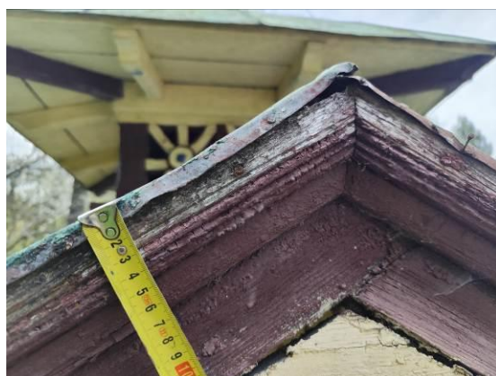
Fot.31. Zbliżenie na detal promienistego słoneczka z rozetką na elewacji pawilonu „Józia”. Fot.32. Zbliżenie na profilowaną listwę wiatrową na skrajnej krokwi od frontu.
