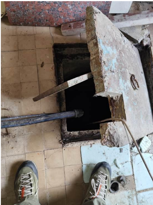
Fot.25-28. Widok wnętrza pawilonu „Józia”. Widoczne współczesne, wtórne obudowy ścian, wtórne posadzki, co istotne nieszczelny wyłaz zamykający dostęp do studni. Stan techniczny tego całego wyposażenia bardzo zły.
