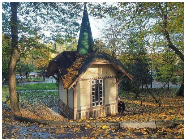
Fot. 9. Usytuowanie obiektu, widok od strony południowej.
