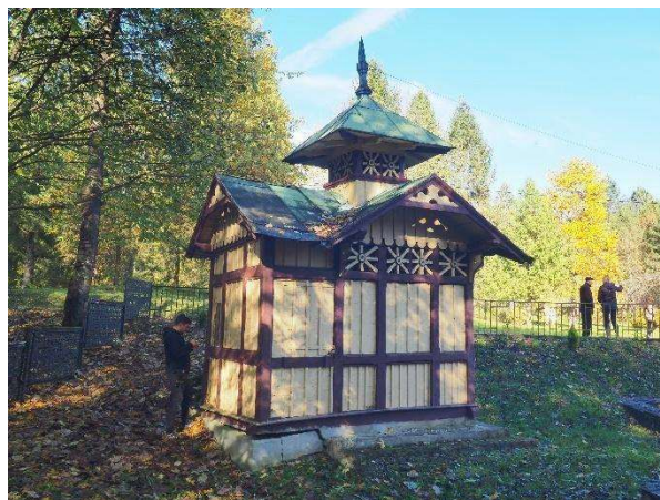
Fot. 55. Usytuowanie obiektu, widok od strony południowej.
