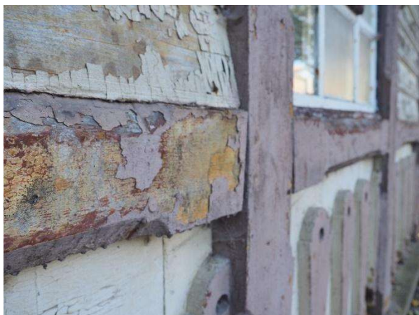
Fot. 18. Spękania i ubytki warstw malarskich. Szary rozkład drewna na powierzchni ramiaka poziomego.
