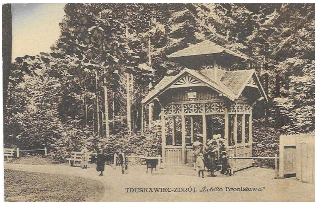
Fot.2 Budynek kiosku nad źródłem "Bronisława". Pierwotna forma budynku przed remontem i oszalowaniem ścian.
