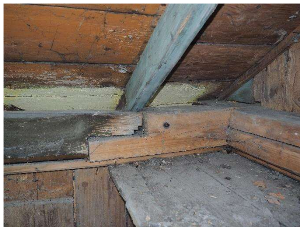
Fot. 107. Łączenie przybudówki z pierwotną bryłą budynku na poziomie belek stropowych.
