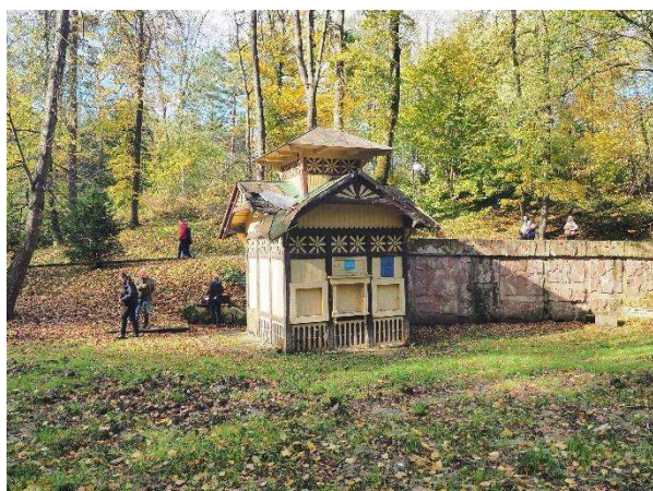
Fot. 28. Usytuowanie obiektu, widok od strony południowej.
