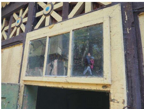
Fot. 44. Stolarka okienka nad drzwiami.
