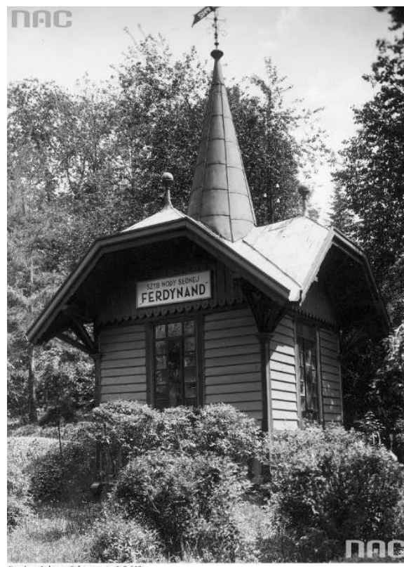
Fot.6. Budynek kiosku nad źródłem „Ferdynand”. Stan po zmianie poszycia dachowego.
