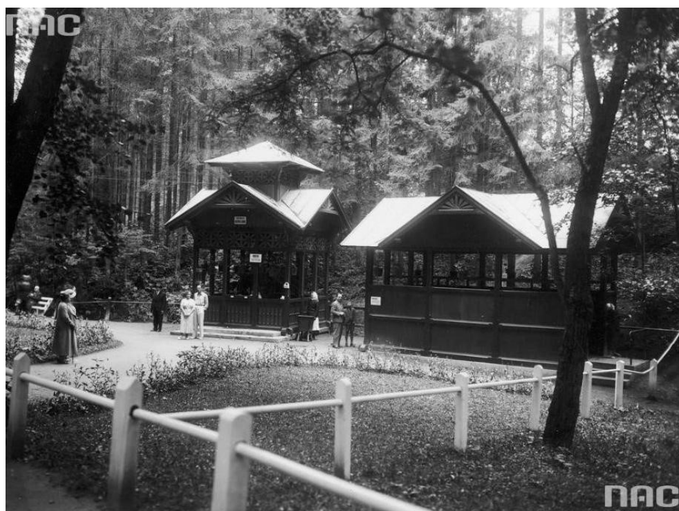
Fot.7. Budynek kiosku nad źródłem „Bronisława”. Pierwotna forma budynku przed rozbudową i oszalowaniem ścian.
