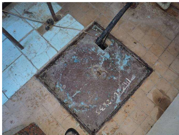
Fot. 101. Właz do studni źródła.
