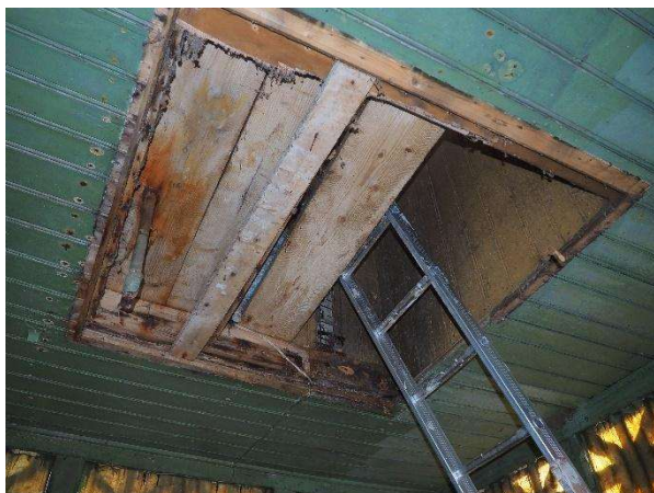
Fot. 98. Wejście na poddasze ze zbiornikiem na wodę.
