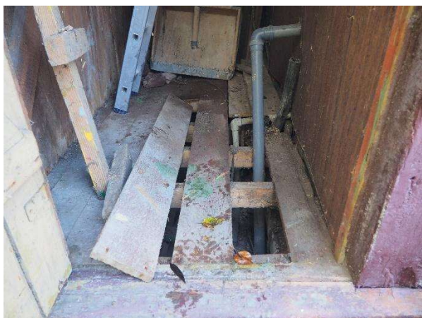
Fot. 104. Podłoga w tylnej części kiosku.
