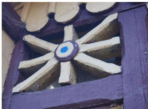
Fot. 67. Wtórnie wykonany detal architektoniczny.
