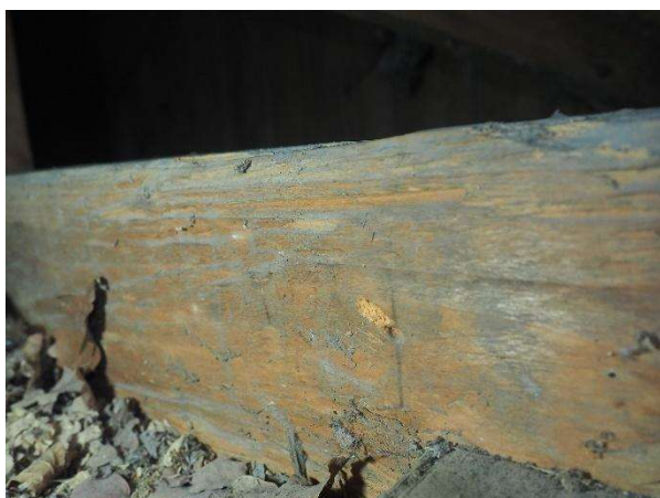
Fot. 108. Otwory wylotowe owadów ksylofagicznych.
