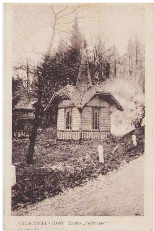
Fot.5. Budynek kiosku nad źródłem „Ferdynand”. Pierwotna forma budynku przed remontem i wymiana poszycia dachowego.
