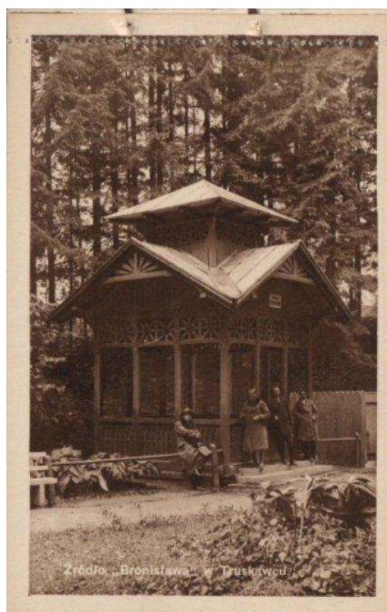
Fot.4 Budynek kiosku nad źródłem "Bronisława". Pierwotna forma budynku przed rozbudową i oszalowaniem ścian.
