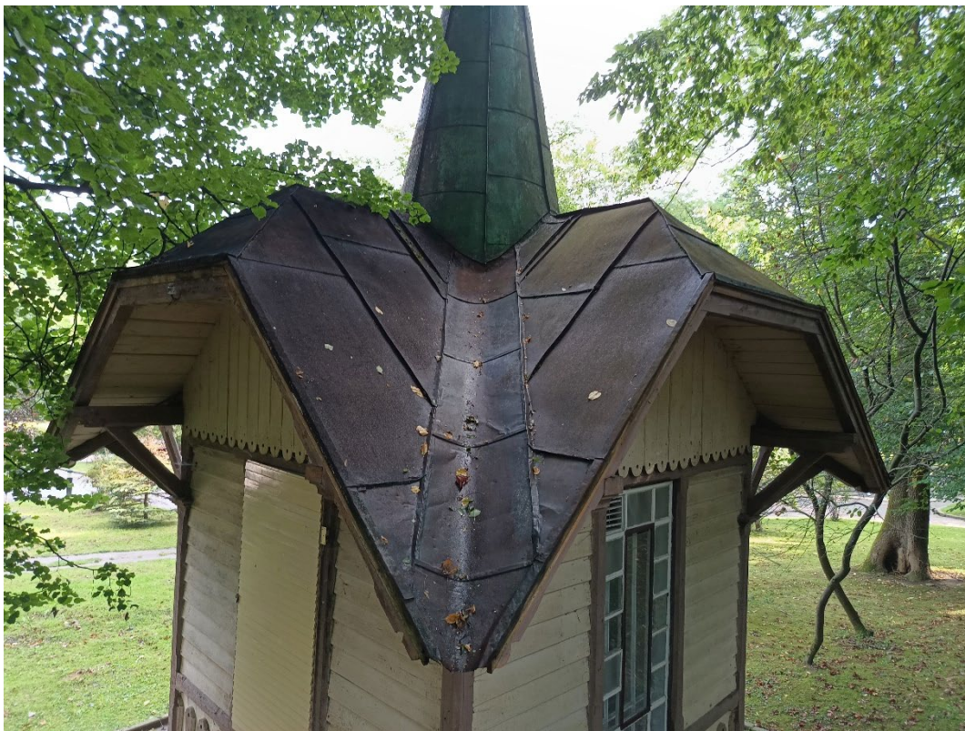
Fot 7. Szczelna połać dachu. fot. E. Wilbik 2023
