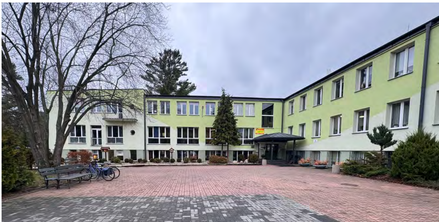
Fot. nr 17. Elewacja południowa - widoczne okna przyziemia.
