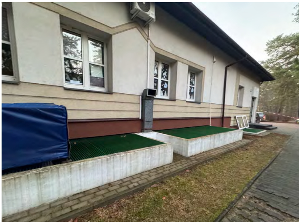
Fot. nr 11. Fragment elewacji północnej (od strony ul. Literackiej)
