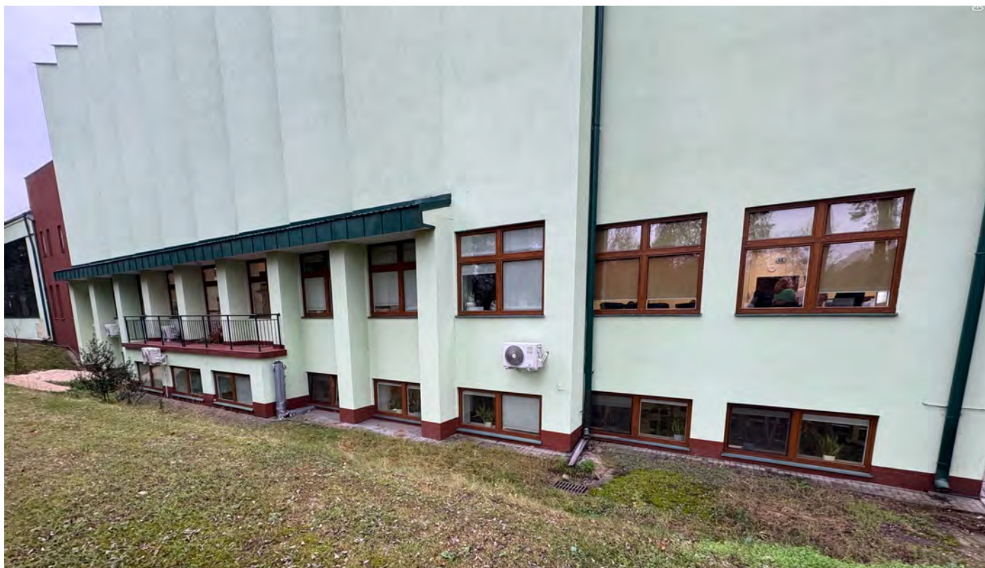
Fot. nr 20. Elewacja wschodnia widoczne okna piwnic ponad pow. terenu
