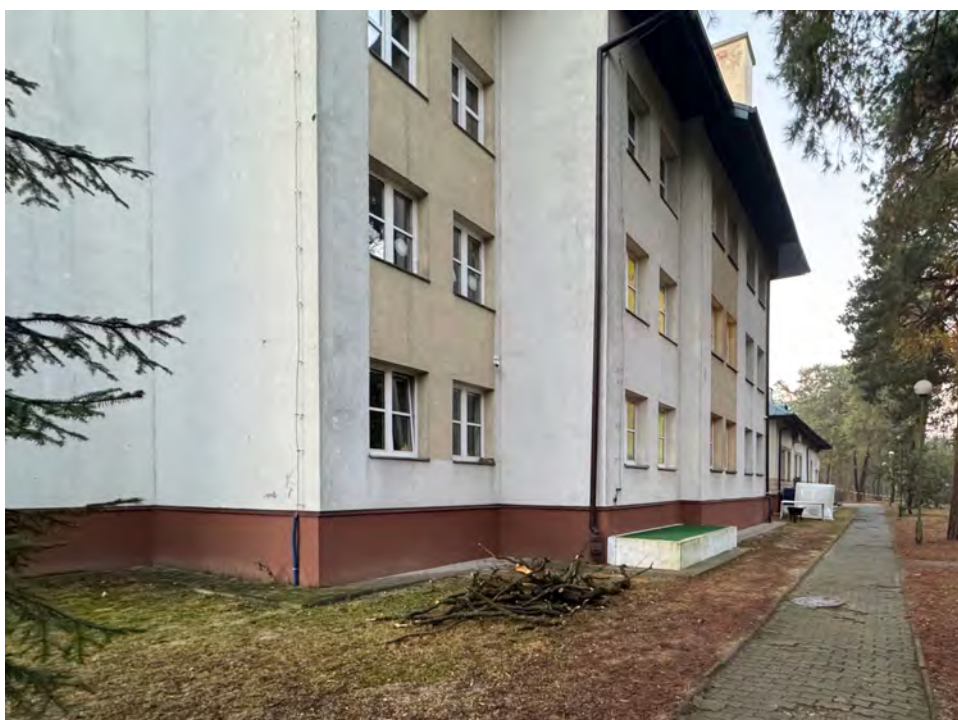
Fot. nr 12. Fragment elewacji wschodniej (od strony ul. Górnośląskiej)
