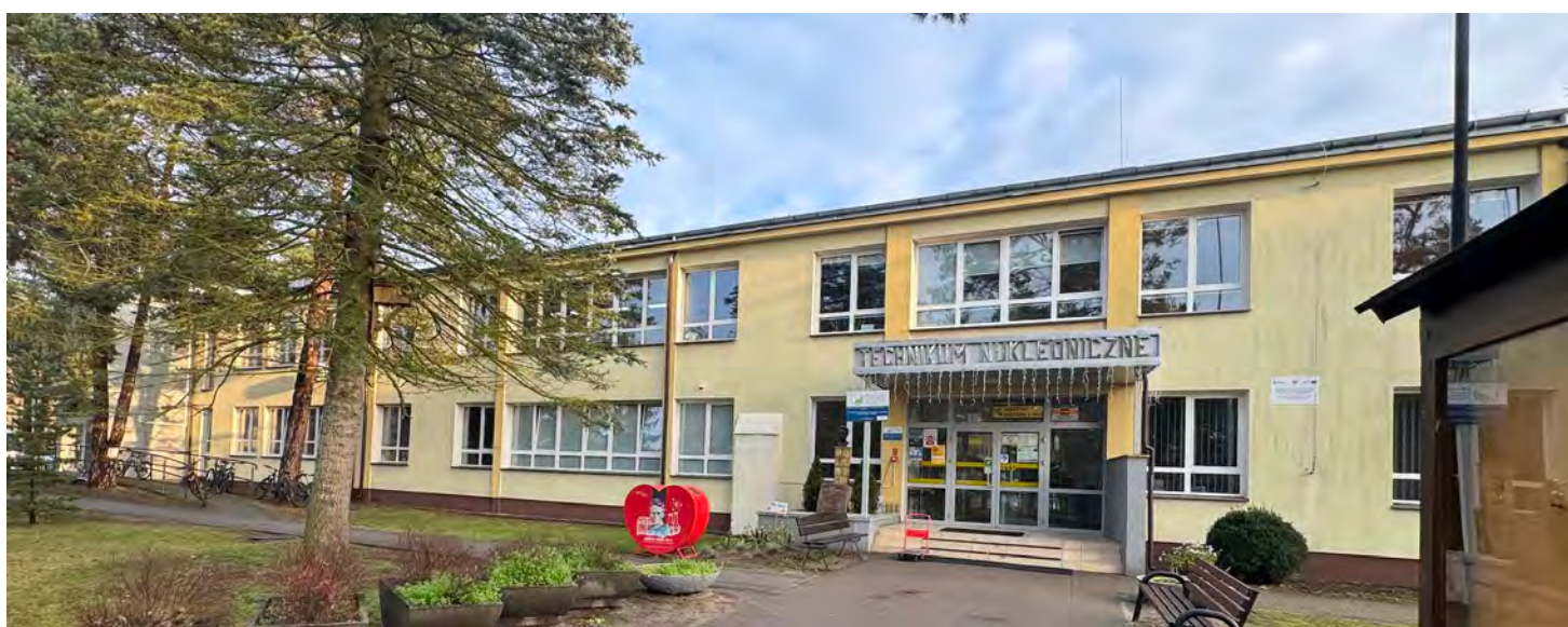
Fot. nr 7 Elewacja frontowa (zachodnia)
