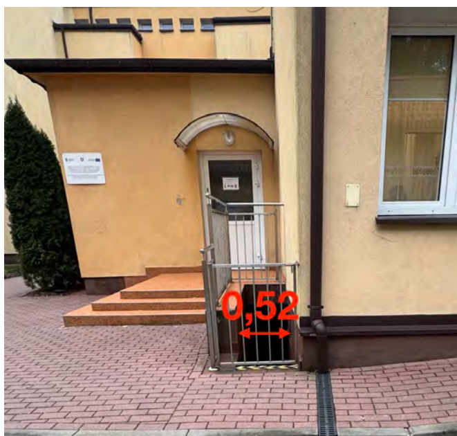
Fot. nr 16. Elewacja zachodnia - wejście do piwnicy "1"
