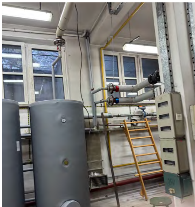
Fot. nr 14. Okna ze studzienkami w pom. technicznym
