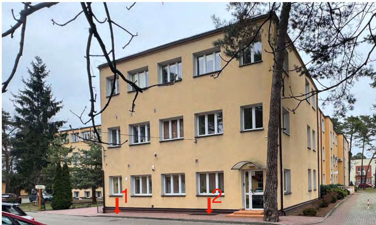
Fot. nr 16. Elewacja zachodnia z oznaczonymi lokalizacjami piwnic "1" i "2"
