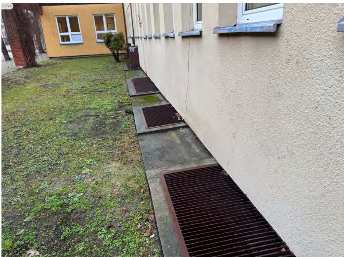
Fot. nr 5. Studzienki z oknami w piwnicy budynku C
