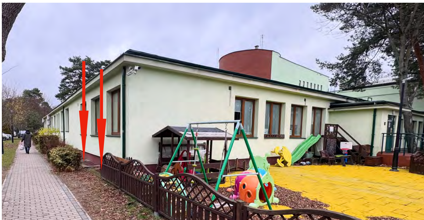
Fot. nr 21. Elewacje południowa i zachodnia bud. oznacz.nr 10 (na szkicu nr 9) - widoczne okna piwnic w studzienkach okiennych (ozn. strzałkami)
