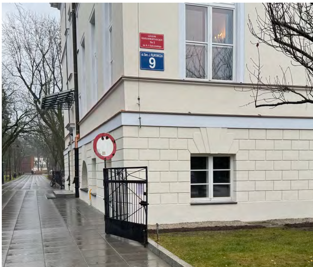
Fot. nr 2. Posadzka na niskim parterze znajduje się ok. 70 cm poniżej poziomu terenu
