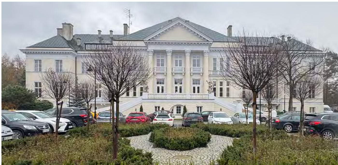
Fot. nr 1 Elewacja frontowa (zachodnia)
