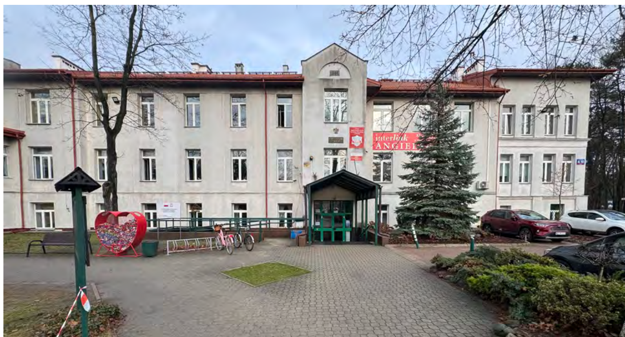
Fot. nr 7 Elewacja frontowa (zachodnia)
