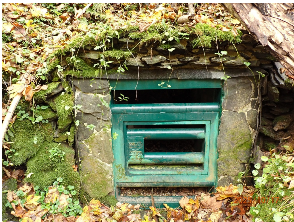
Fot. 7 Krata przy Sztolni nad Bystrym Potokiem
