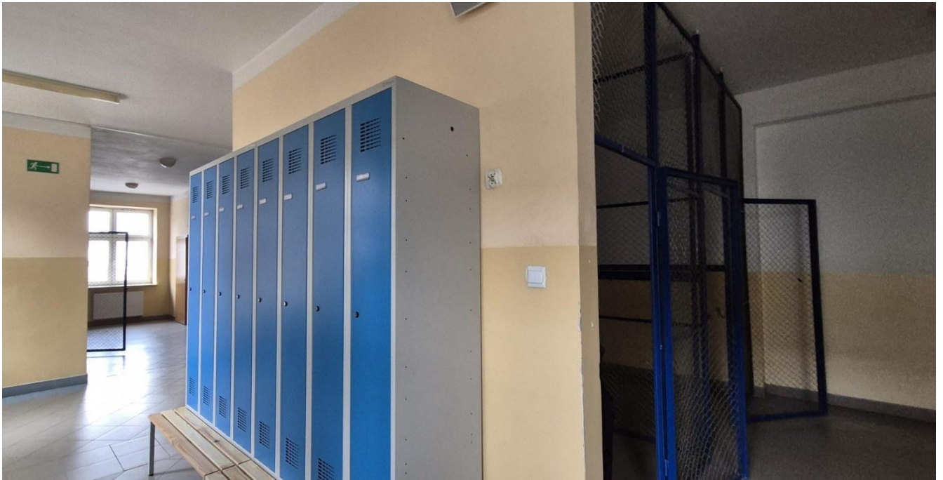
Foto 14 – widok przestrzeni objętej pracami, ściana działowa do rozbiórki
