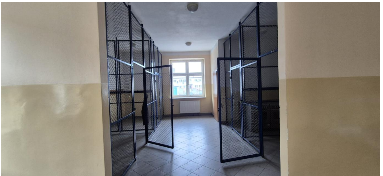
Foto 17 – widok przestrzeni objętej pracami, ściana działowa do rozbiórki
