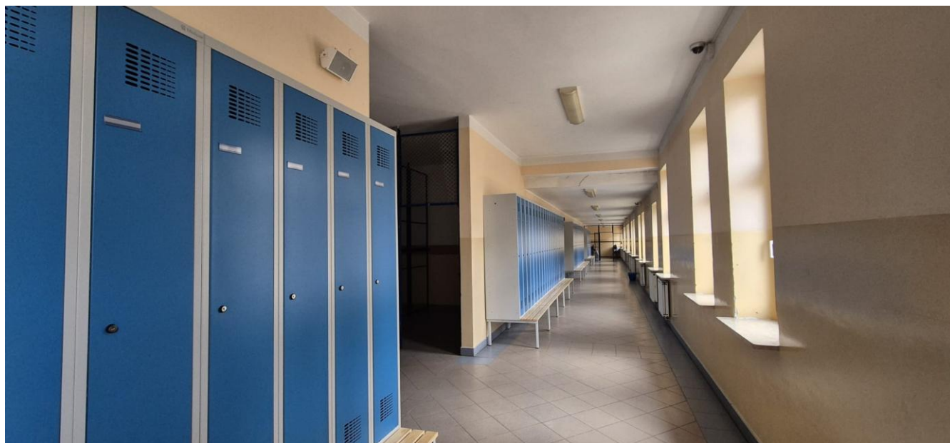
Foto 11 – widok przestrzeni objętej pracami, przejście do zamurowania
