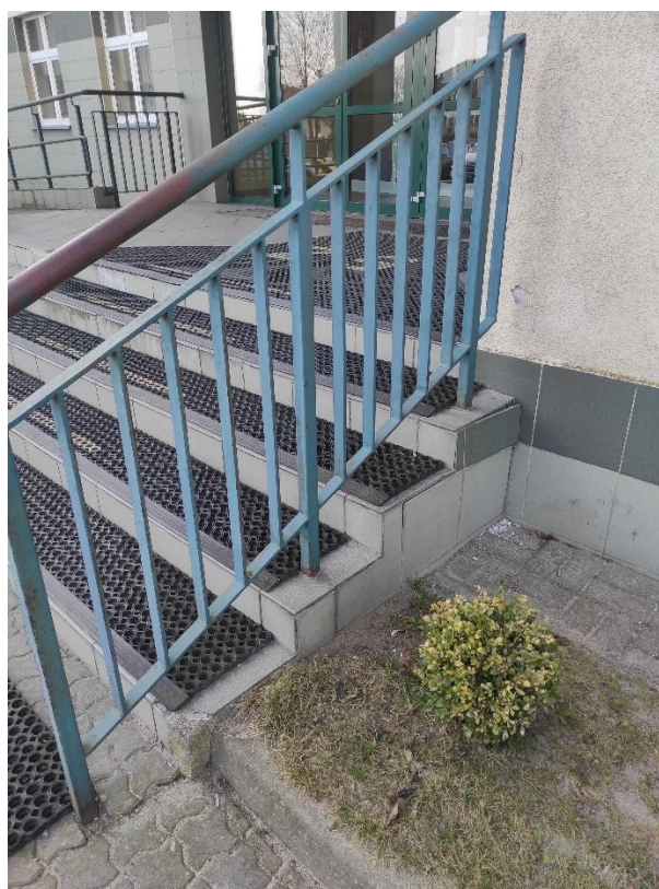
Foto. 4, 5, 6 – Widok istniejących schodów
