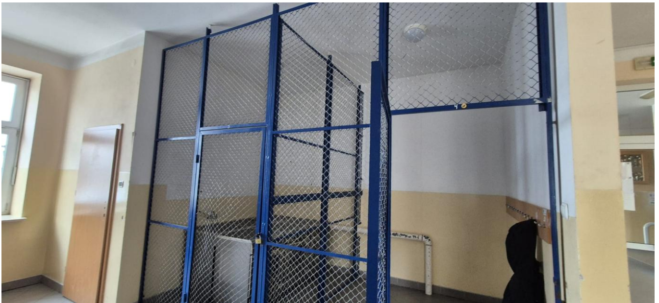
Foto 15 – widok przestrzeni objętej pracami, ściana działowa do rozbiórki
