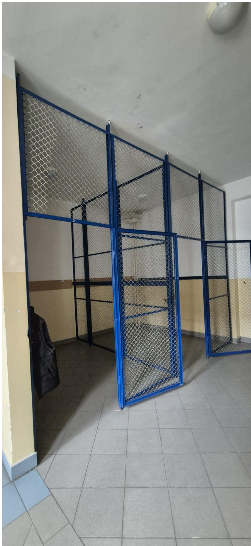
Foto 13 – widok przestrzeni objętej pracami, ściana działowa do rozbiórki
