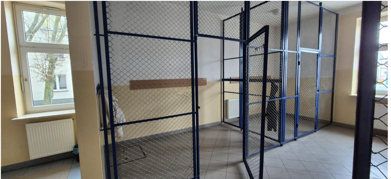
Foto 16 – widok przestrzeni objętej pracami, ściana działowa do rozbiórki
