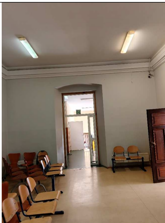
Fot 18. Oświetlenie wtórne w pom. 0.10 Komunkacja
