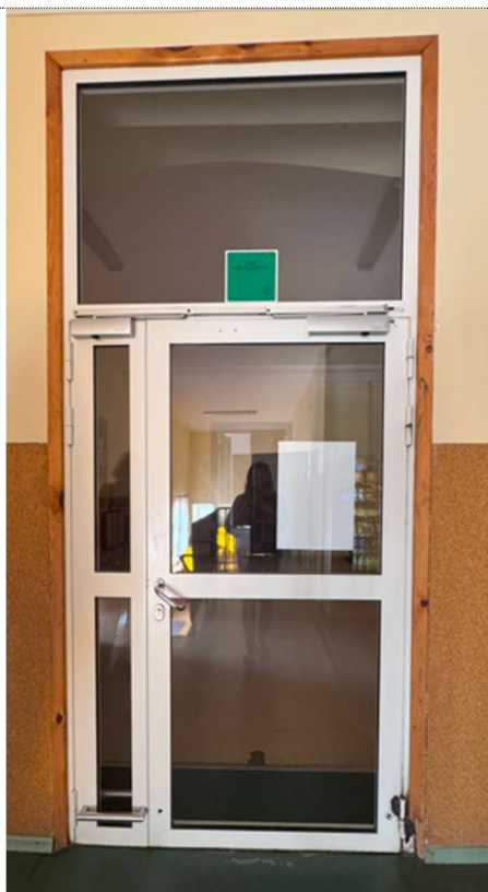
Fot. 90. Poziom wysokiego parteru, stolarka drzwiowa pomiędzy szkołą częścią zabytkową i pozostałą częścią. Aluminiowe białe z nadświetleniem.
