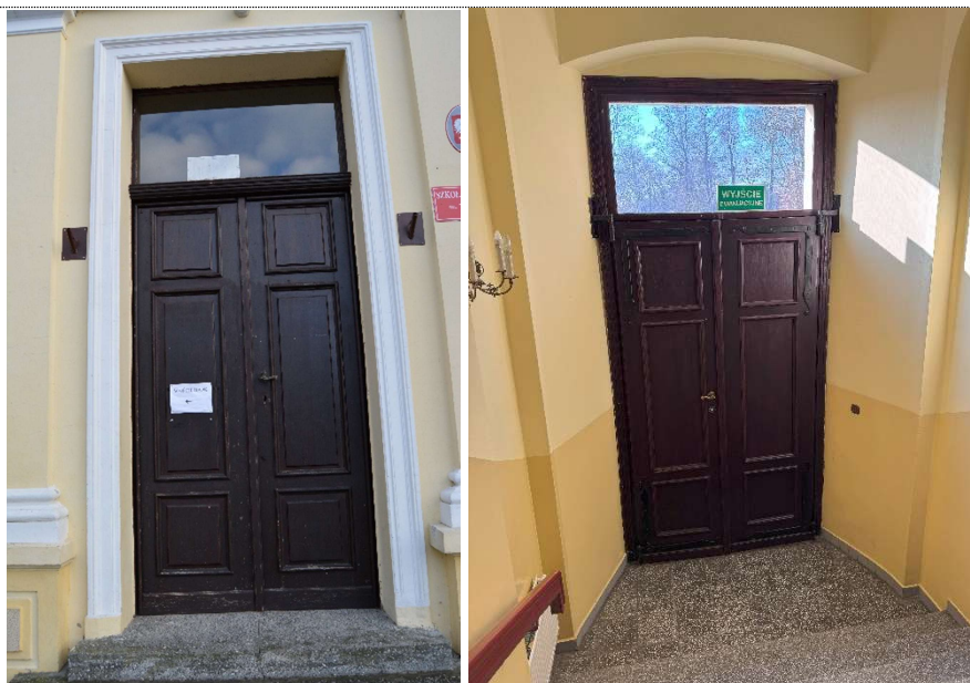
Fot. 55. Widok na zabytkową część szkoły. Główne wejście. Drzwi drewniane połaciowo – ramowe z nadświetleniem. Zdobiona klamka oraz od wewnątrz zachowane okucia wraz z zdobionym szyldem zamkowym. Brak szyldu zamkowego z zewnętrznej strony.
