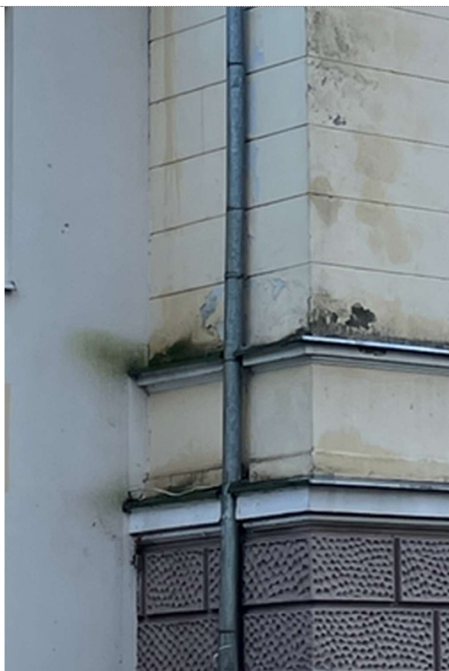
Fot. 29. Elewacja północno zachodnia – widoczne spękanie tynku, odpryśnięcie. Porażenie biologiczne.
