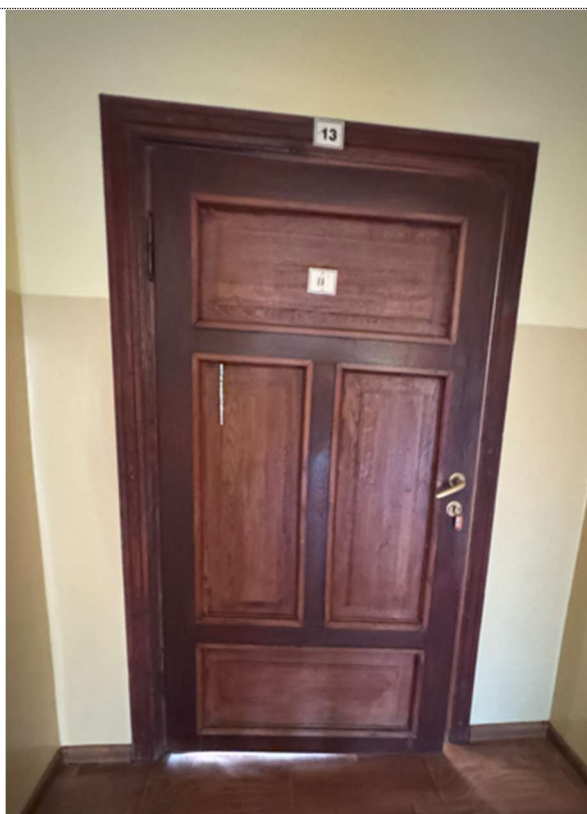
Fot. 95. Poziom wysokiego parteru DR5 – drzwi drewniane renowacja lub rekonstrukcja.
