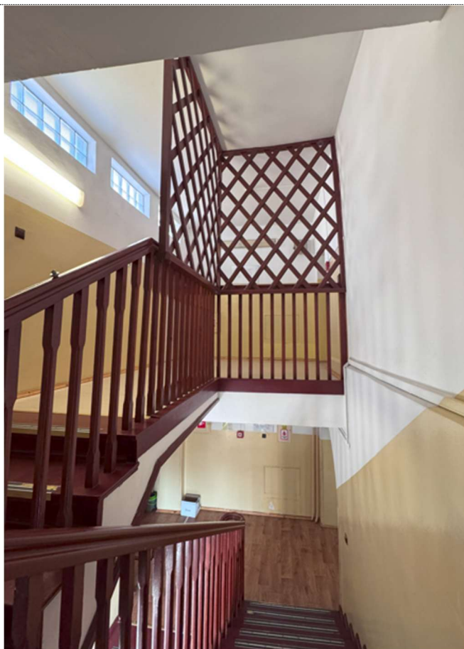
Fot. 69. Klatka schodowa A poziom „+1” na poziom „+2”. Balustrada ażurowa do sufitu. Widoczne luksfery.
