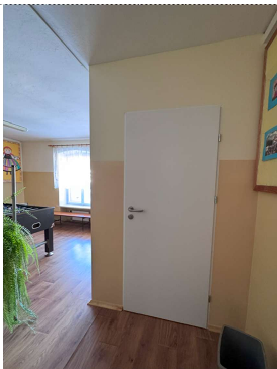
Fot. 108. Poziom „+1” zabytkowej części – pom. ozn. 1.11– wymiana drzwi na stylizowane, wzorowane drzwiami istniejącymi w obiekcie.
