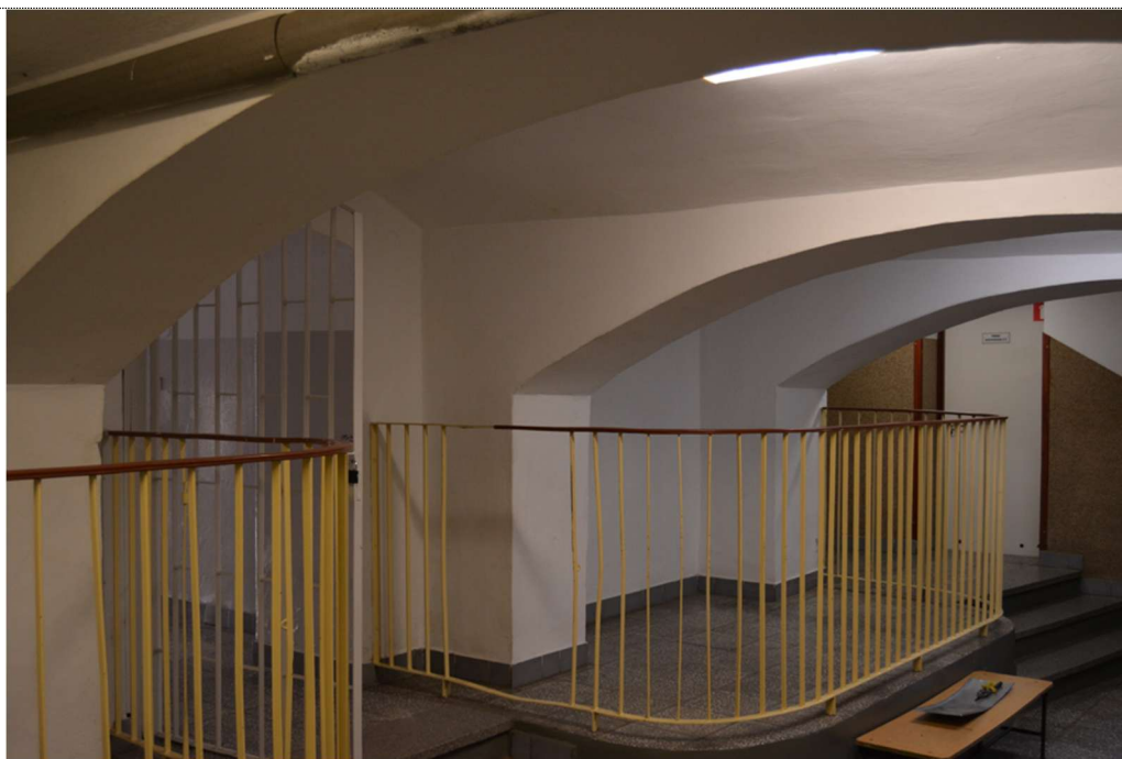
Fot. 58. Poziom niskiego parteru. Widok na szatnię. Wykończenie podłogi płytkami lastryko. Widoczne liczne zmiany poziomów posadzki.
