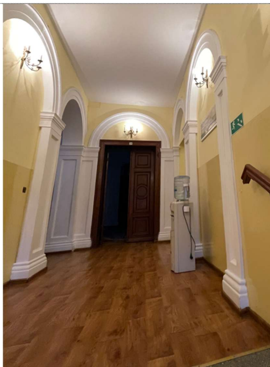
Fot. 70. Widok na drzwi dekoracyjne, łuki w postaci arkad. Wykończenie podłogi wykładziną PCV imitującą podłogę drewnianą.
