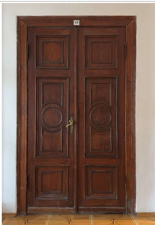
Fot. 77. Drzwi drewniane wewnętrzne, dwuskrzydłowe, połaciowo – ramowe dekoracyjne z klamką dekoracyjną. Znajdują się w pom. 0.7 (do pom. 0.11) na poziomie wysoki parter. Widoczne liczne zarysowania połaci drzwi, pęknięcia spowodowane użytkowaniem. Poddane pracom konserwatorskim- renowacji.
