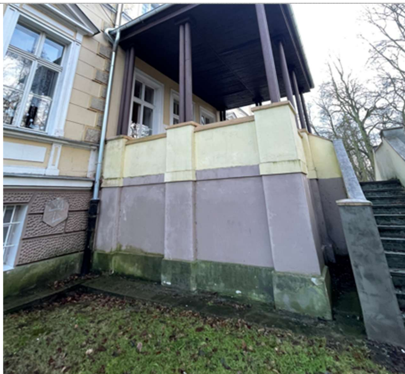
Fot. 29. Elewacja północno zachodnia – widoczne spękanie tynku, odpryśnięcie. Porażenie biologiczne.
