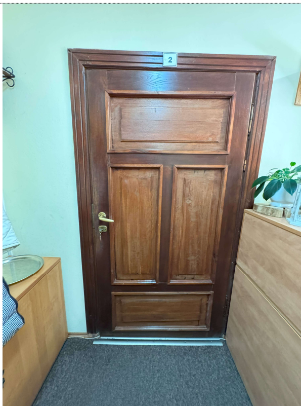
Fot. 107. Poziom „+1” zabytkowej części DR11 – drzwi drewniane renowacja lub rekonstrukcja.
