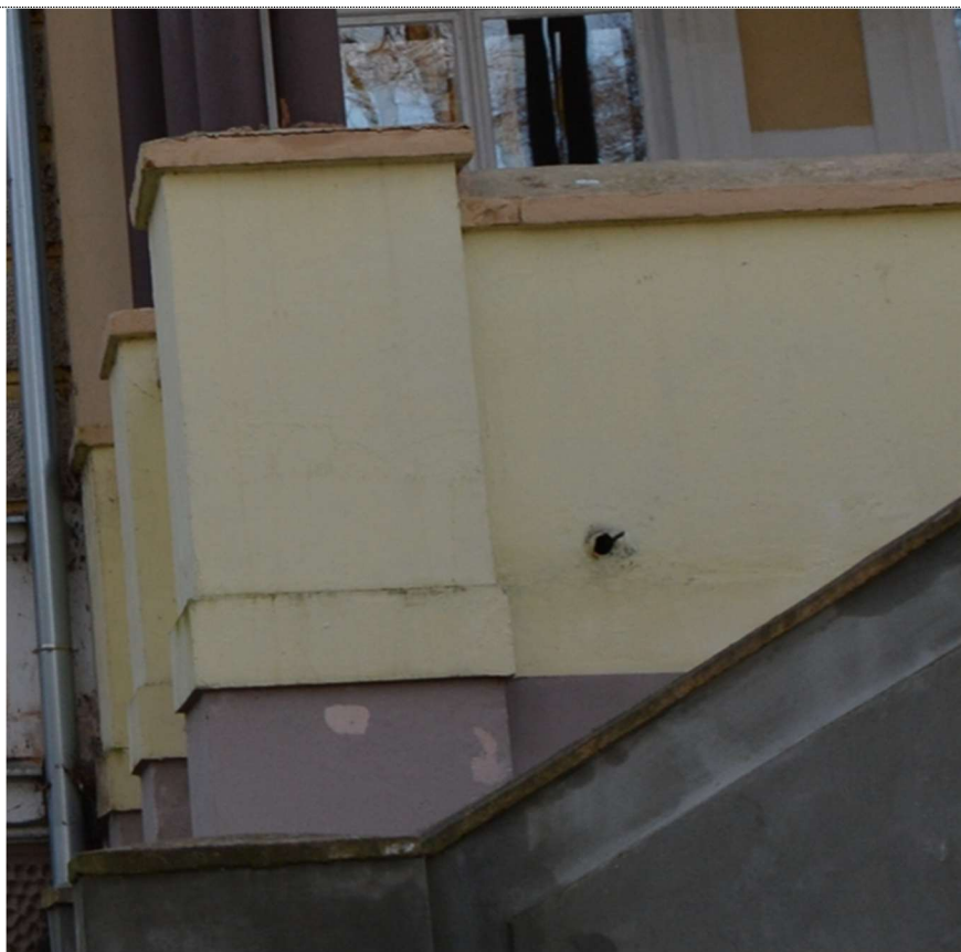
Fot. 27. Elewacja północno zachodnia – weranda – widoczne spękanie tynku.
