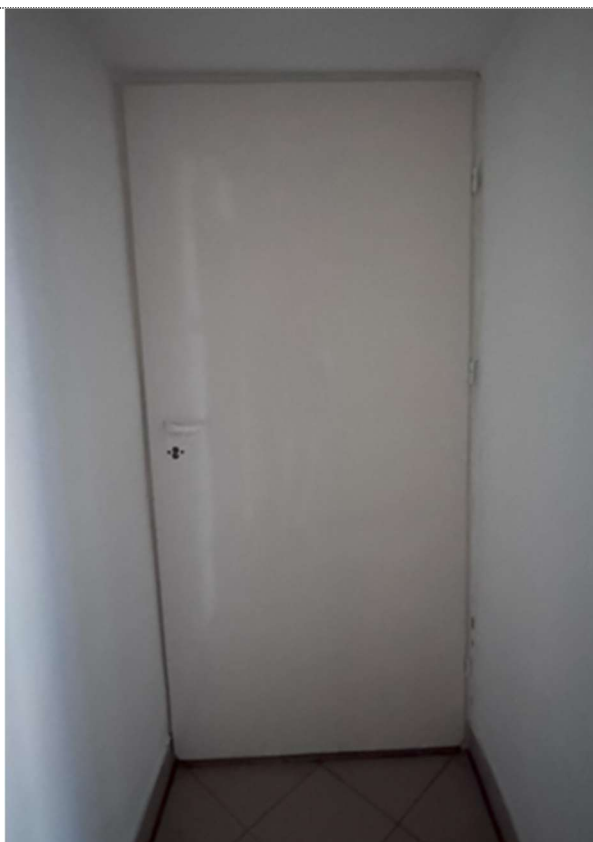
Fot. 98. Drzwi z pom. 0.15 do klatki schodowej D.
