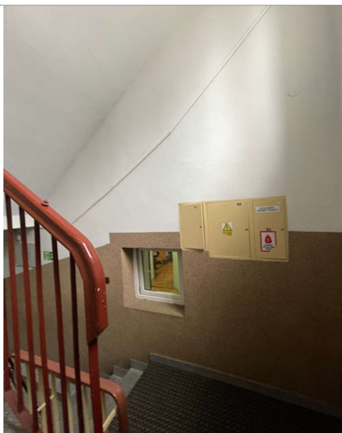
Fot. 64. Klatka schodowa A. Strefa wejścia do obiektu. Widoczna stolarka okienna z pomieszczenia -1.2 Dyżurka.
