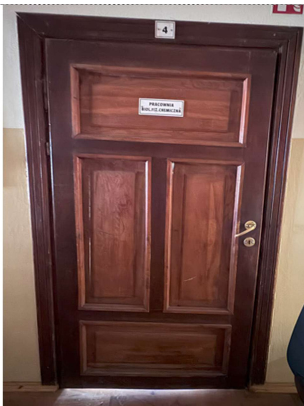
Fot. 112. Poziom „+1” zabytkowej części DR13 – drzwi drewniane renowacja lub rekonstrukcja.
