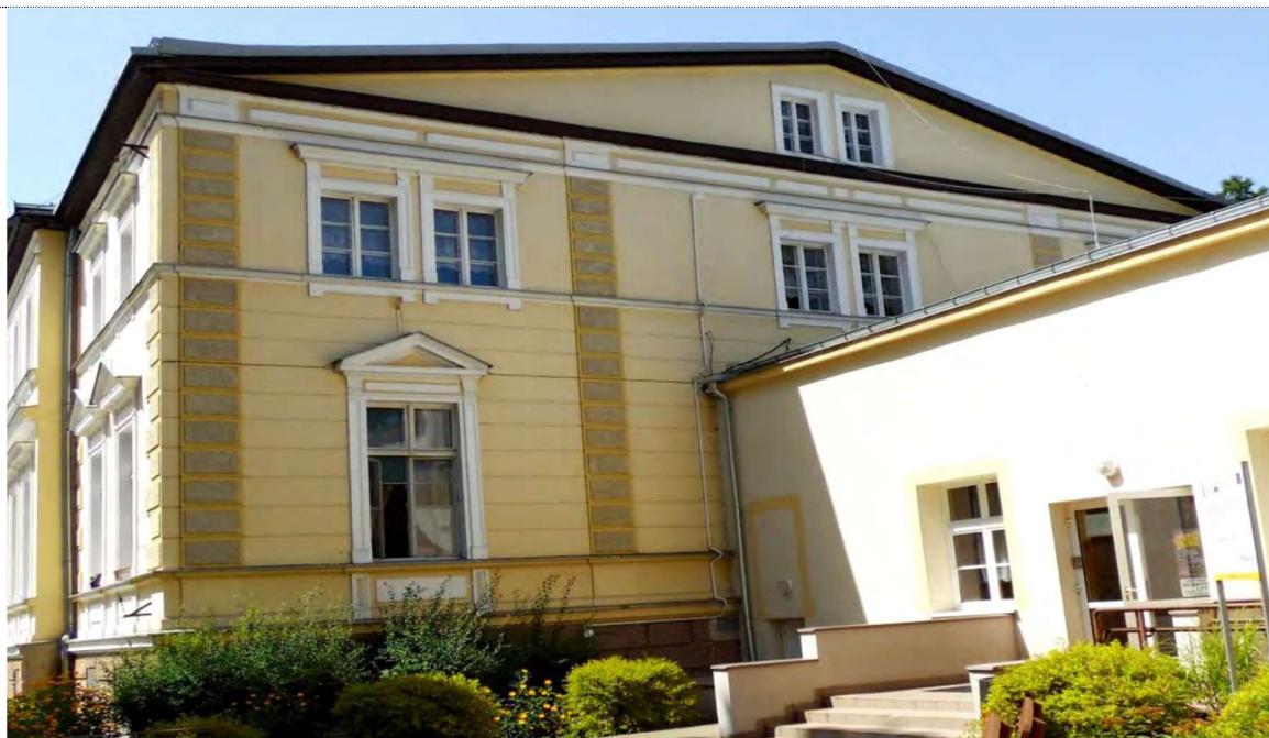
Fot. 5. Widok na elewację północno - wschodnią zabytkowej części szkoły oraz część dobudowaną. Wysoki cokół boniowany z rustykalną fakturą oraz boniowany wysoki parter – boniowanie pasowe. Pionowe partie boń tzw. Lizeny. Stolarka okienna w kolorze bieli. Bogate zdobienie obramowań okiennych. W parterze płycinowe podokienniki, opaski okienne, trójkątne naczółki. Okna na poziomie wysokiego parteru z prostymi naczółkami i parapetami wspartymi na konsolkach. Gzymsy podokienne na wysokim parterze oraz na poziomie +1. Gzyms kordonowy oraz gzyms okalający trójkątnie zakończony szczyt. Na poziomie +2 widoczna stolarka okienna ze zdobioną opaską okienną. Część niezabytkowa, wejście główne.
