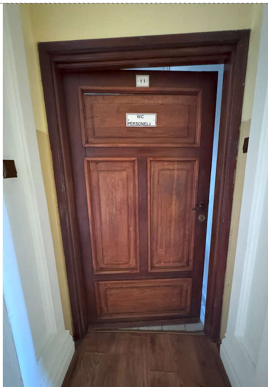
Fot. 92. Poziom wysokiego parteru DR3– drzwi drewniane renowacja lub rekonstrukcja.
