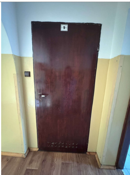
Fot. 105. Poziom +1 zabytkowej części – drzwi pomieszczenia gospodarczego – wymiana drzwi na stylizowane, wzorowane drzwiami istniejącymi w obiekcie.
