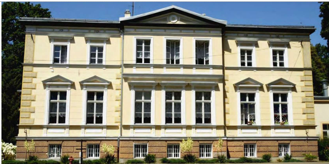
Fot. 1. Widok na elewację południowo – wschodnią w zabytkowej części szkoły. Elewacja wzdłużna 7 osiowa z 3 osiowym ryzalitem, umieszczonym centralnie, zwieńczonym trójkątnym szczytem tympanonem. Wysoki cokół boniowany z rustykalną fakturą oraz boniowany wysoki parter – boniowanie pasowe. Narożne boniowania. W poziomie niskiego parteru stolarka okienna za kratami zewnętrznymi. Stolarka okienna w kolorze bieli. Bogate zdobienie obramowań okiennych. W parterze płycinowe podokienniki, opaski okienne, trójkątne naczółki. Okna na poziomie wysokiego parteru wraz z oknami ryzalitu z prostymi naczółkami i parapetami wspartymi na konsolkach. Gzymsy podokienne na wysokim parterze oraz na poziomie +1. Pod gzymsem kordonowym – znacznie ciemniejszy pojawiają się okienka okullusowe oraz kroksztyny dźwigające okap.
