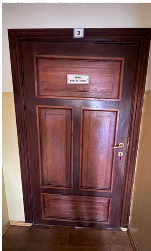
Fot. 110. Poziom „+1” zabytkowej części DR12 – drzwi drewniane renowacja lub rekonstrukcja. Widoczne pęknięcia i uszkodzenia.
