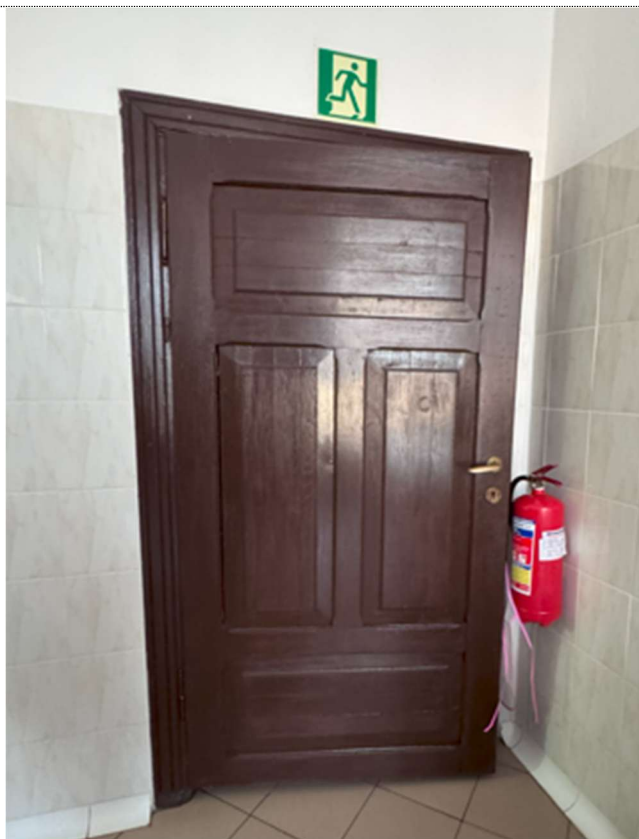
Fot. 97. Poziom wysokiego parteru DR7 – drzwi drewniane renowacja lub rekonstrukcja.
