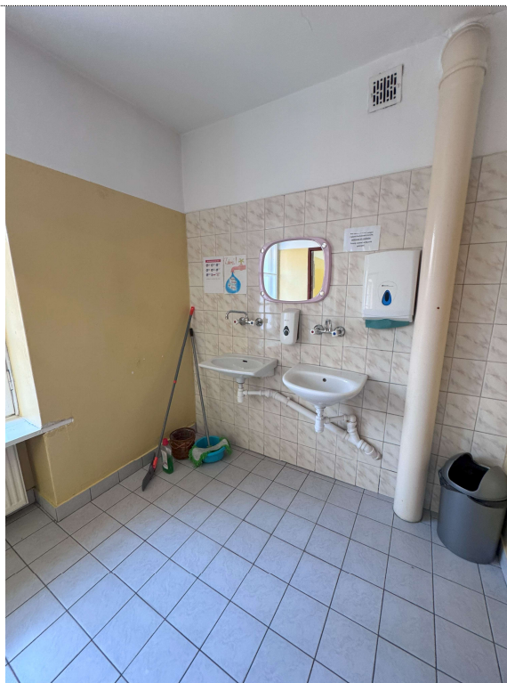
Fot. 101. Poziom +1 zabytkowej części – Toaleta – remont.
