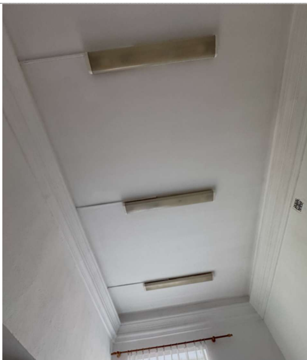
Fot. 89. Pom. 0.15 na wysokim parterze. Widoczny detal –gzyms podsufitowy.
