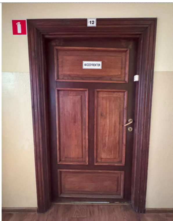
Fot. 94. Poziom wysokiego parteru DR4 – drzwi drewniane renowacja lub rekonstrukcja.
