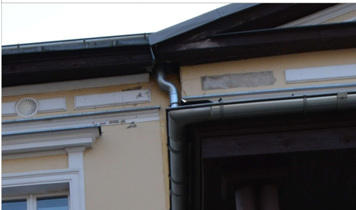
Fot. 27. Elewacja północno zachodnia – weranda – widoczne spękanie tynku.
