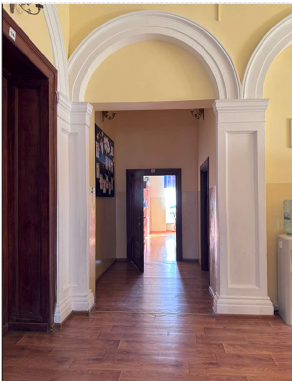
Fot. 75. Detal architektoniczny – arkady na poziomie wysokie parteru. Wykończenie wykładziną PCV.
