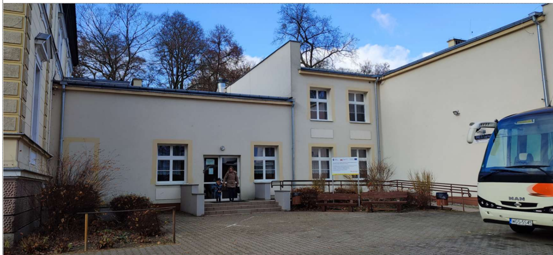
Fot. 6. Widok na elewację południowo – wschodnią części niezabytkową. Widoczne opaski okienne wykonane za pomocą wykorzystania innego odcienia powłoki malarskiej. Styropianowe detale architektoniczne.
