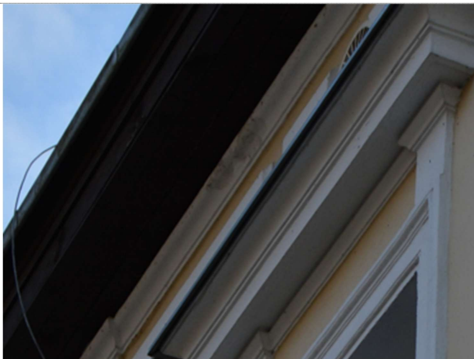
Fot. 33. Elewacja północno zachodnia – widoczne spękanie i odspojenie powłoki malarskiej.
