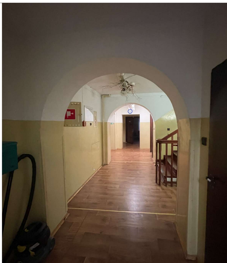
Fot. 100. Poziom „+1” części starej szkoły. Widoczne łuki nad przejściami.
