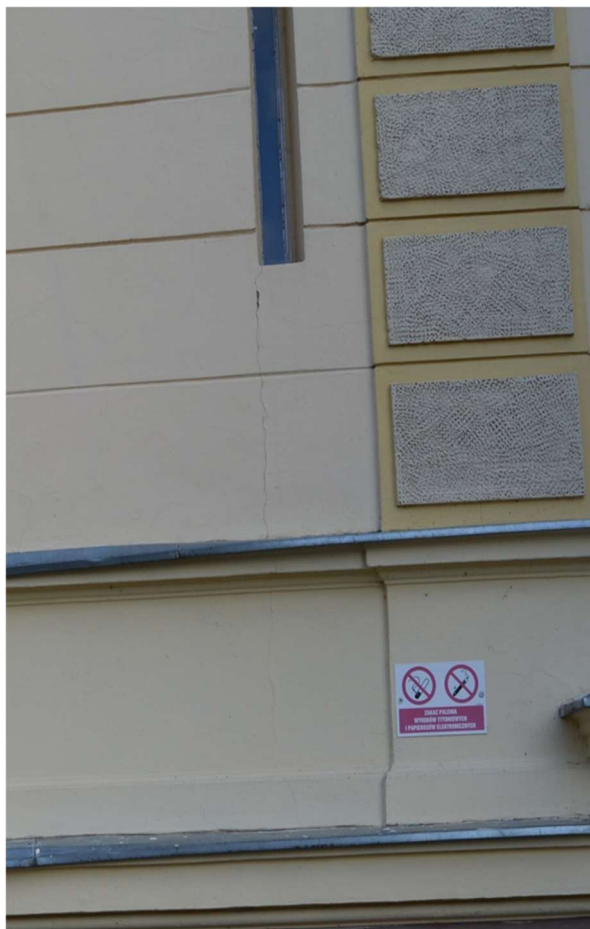
Fot. 53. Elewacja południowo – zachodnia – zachodnia części zabudkowej – widoczne spękanie – rysa.
