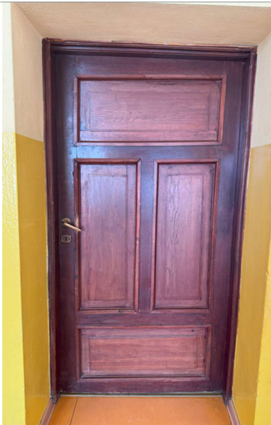
Fot. 96. Poziom wysokiego parteru DR6 – drzwi drewniane renowacja lub rekonstrukcja.
