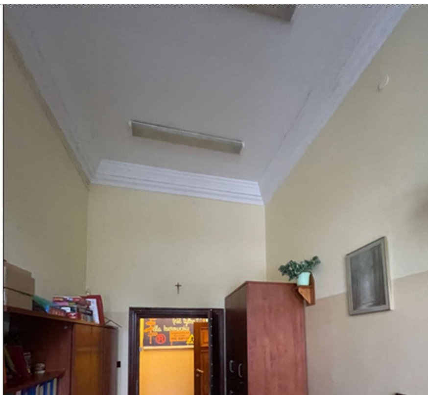
Fot. 71. Poziom wysokiego parteru pom. 0.2. Widoczny detal gzymsu podsufitowego.
