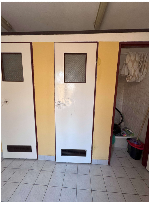
Fot. 103. Poziom „+1” zabytkowej części – toaleta – widok na kabiny.
