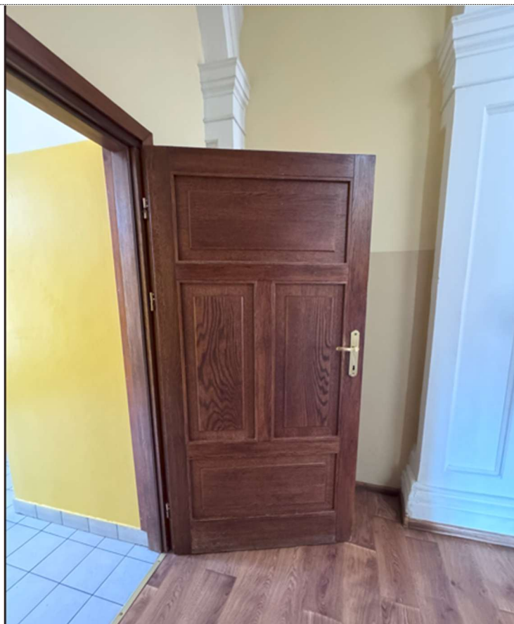
Fot. 91. Poziom wysokiego parteru DR2 – drzwi drewniane renowacja lub rekonstrukcja.
