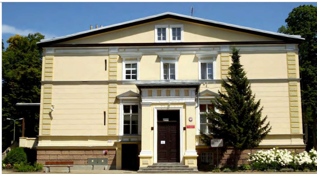
Fot. 2. Widok na elewację południowo – zachodnią zabytkowej części szkoły. Widoczne główne wejście do szkoły na poziom wysokiego parteru oraz wejście na poziom niskiego parteru. Wysoki cokół boniowany z rustykalną fakturą oraz boniowany wysoki parter – boniowanie pasowe. Pionowe partie boń tzw. lizeny. Stolarka okienna w kolorze bieli. Bogate zdobienie obramowań okiennych. W parterze płycinowe podokienniki, opaski okienne, trójkątne naczółki. Okna na poziomie wysokiego parteru z prostymi naczółkami i parapetami wspartymi na konsolkach. Gzymsy podokienne na wysokim parterze oraz na poziomie +1. Gzyms kordonowy oraz gzyms okalający trójkątnie zakończony szczyt. Na poziomie +2 widoczna stolarka okienna ze zdobioną opaską okienną.
