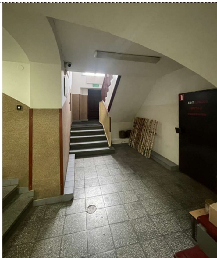
Fot. 56. Poziom niskiego parteru. Widok na klatkę schodową A. Wykończenie podłogi płytkami lastryko.
