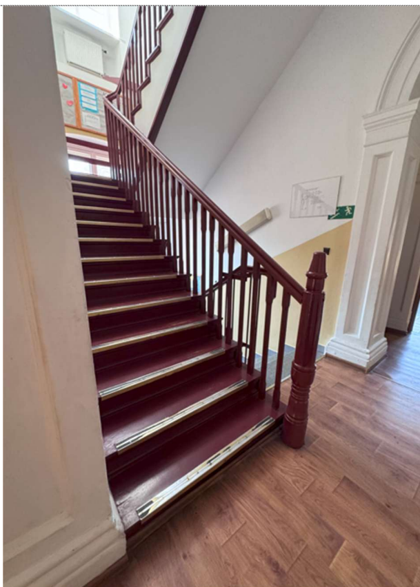
Fot. 67. Widok klatka schodowa A. Poziom wysoki parter, słupek balustrady, tralki, pochwyt i trepy drewniane.
