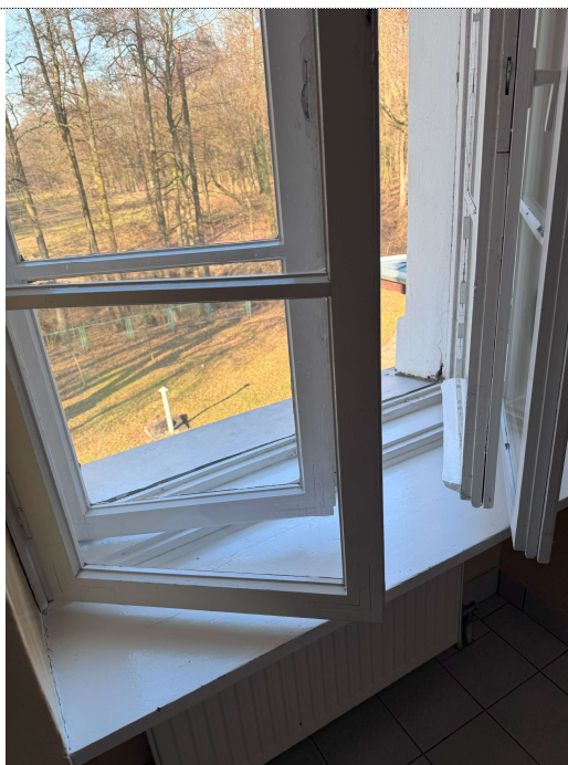
Fot. 102. Poziom „+1” zabytkowej części – toaleta – poziom parapetu okna na wysokości 62cm – zostanie wykonana barierka
