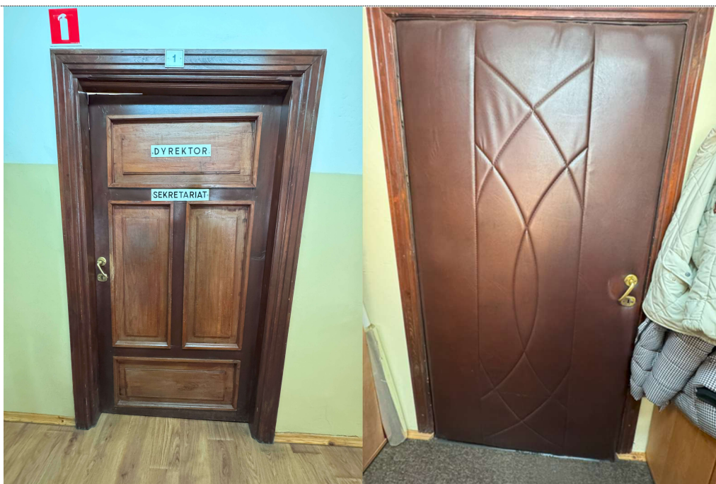
Fot. 106. Poziom +1 zabytkowej części DR10 - widoczna tapicerka na drzwiach od strony wewnętrznej – drzwi drewniane renowacja lub rekonstrukcja.
