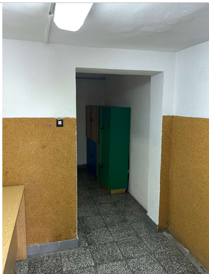
Fot. 61. Przejście w pom. -1.7. (poziom niskiego parteru).
