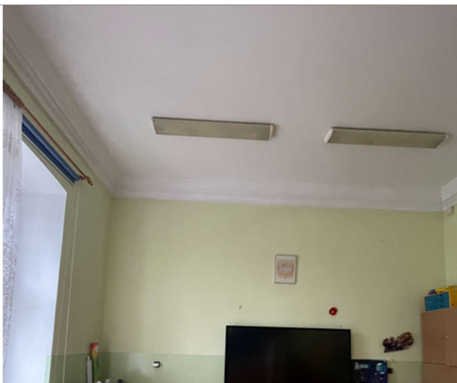
Fot. 72. Poziom wysokiego parteru pom. 0.3. Widoczny detal gzymsu podsufitowego.
