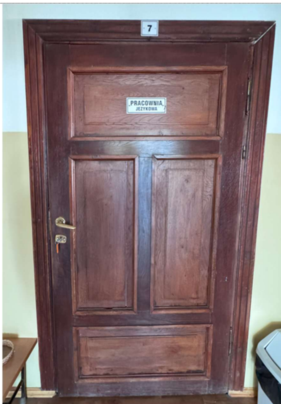
Fot. 111. Poziom „+1” zabytkowej części DR14 – drzwi drewniane renowacja lub rekonstrukcja.
