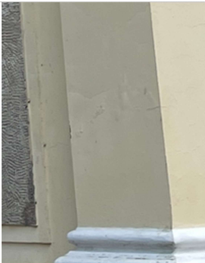
Fot. 35. Elewacja południowo-zachodnia. Widoczne spękania powłoki malarskiej.
