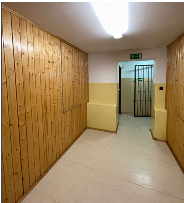
Fot. 120. Poziom „+2” boazeria drewnopodobna na ścianach. Widoczne drzwi krata stalowa.
