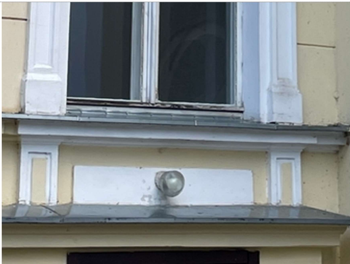
Fot. 35. Elewacja południowo-zachodnia. Widoczne spękania powłoki malarskiej.
