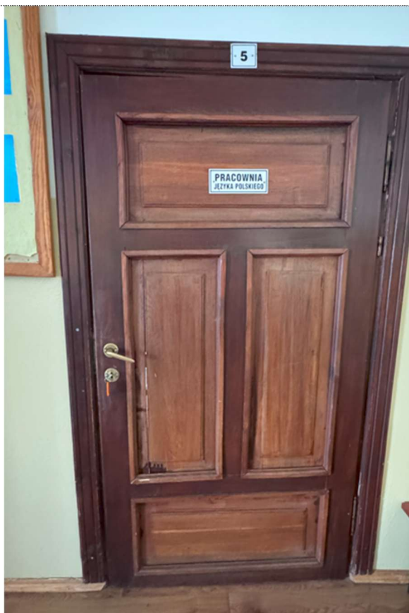
Fot. 114. Poziom „+1” zabytkowej części DR16 – drzwi drewniane renowacja lub rekonstrukcja.
