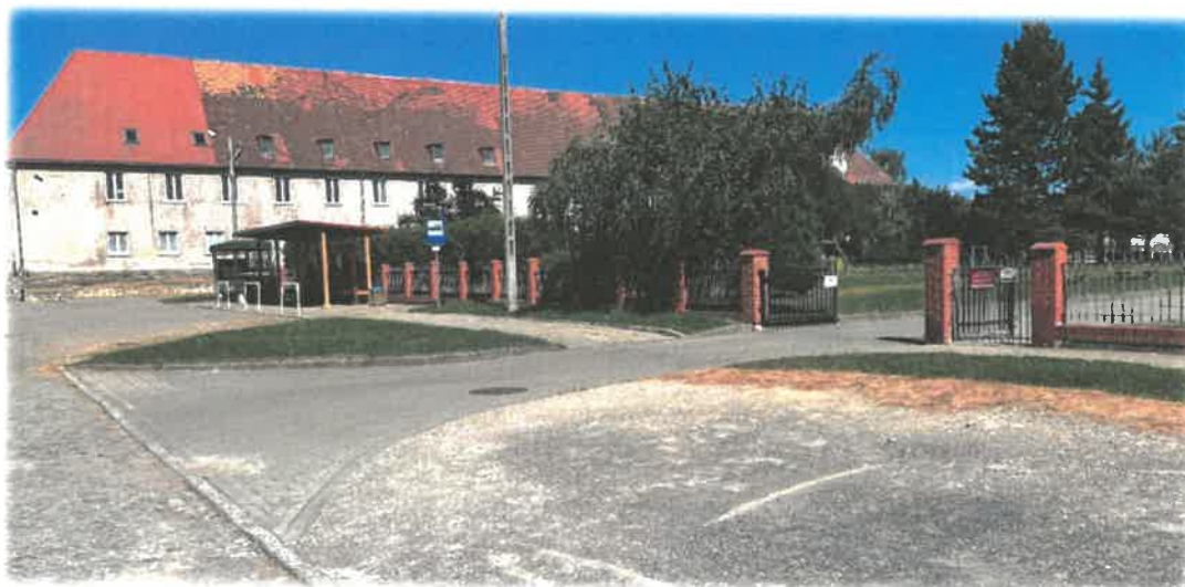
Wjazd na teren SP2 od str. ul. Kusocińskiego.
