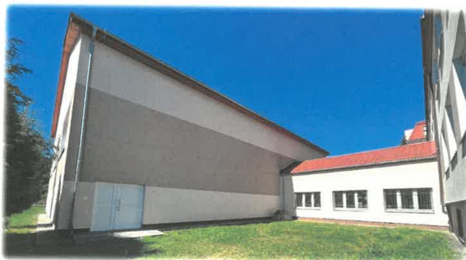
Budynek „B” wraz z łącznikiem
