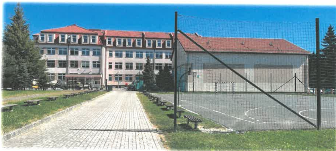
Widok BUDYNKU „A” I „B” od strony ul. Kusocińskiego
