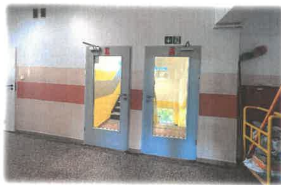
WEJŚCIE DO KLATKI SCHODOWEJ „K2” OD STRONY WEW. KORYTARZA
