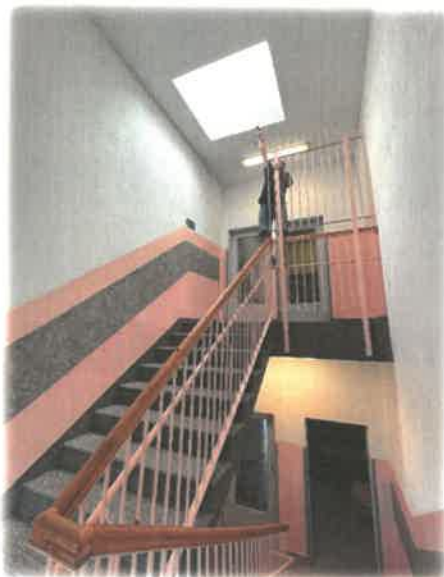
ISTNIEJACE OKNO W KLATCE SCHODOWEJ „K1”
