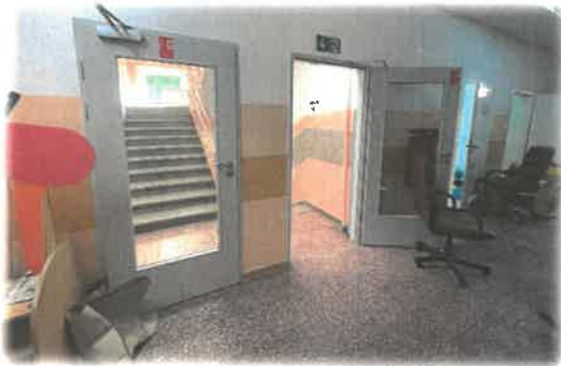
WEJŚCIE DO KLATKI SCHODOWEJ „K1” OD STRONY WEW. KORYTARZA
