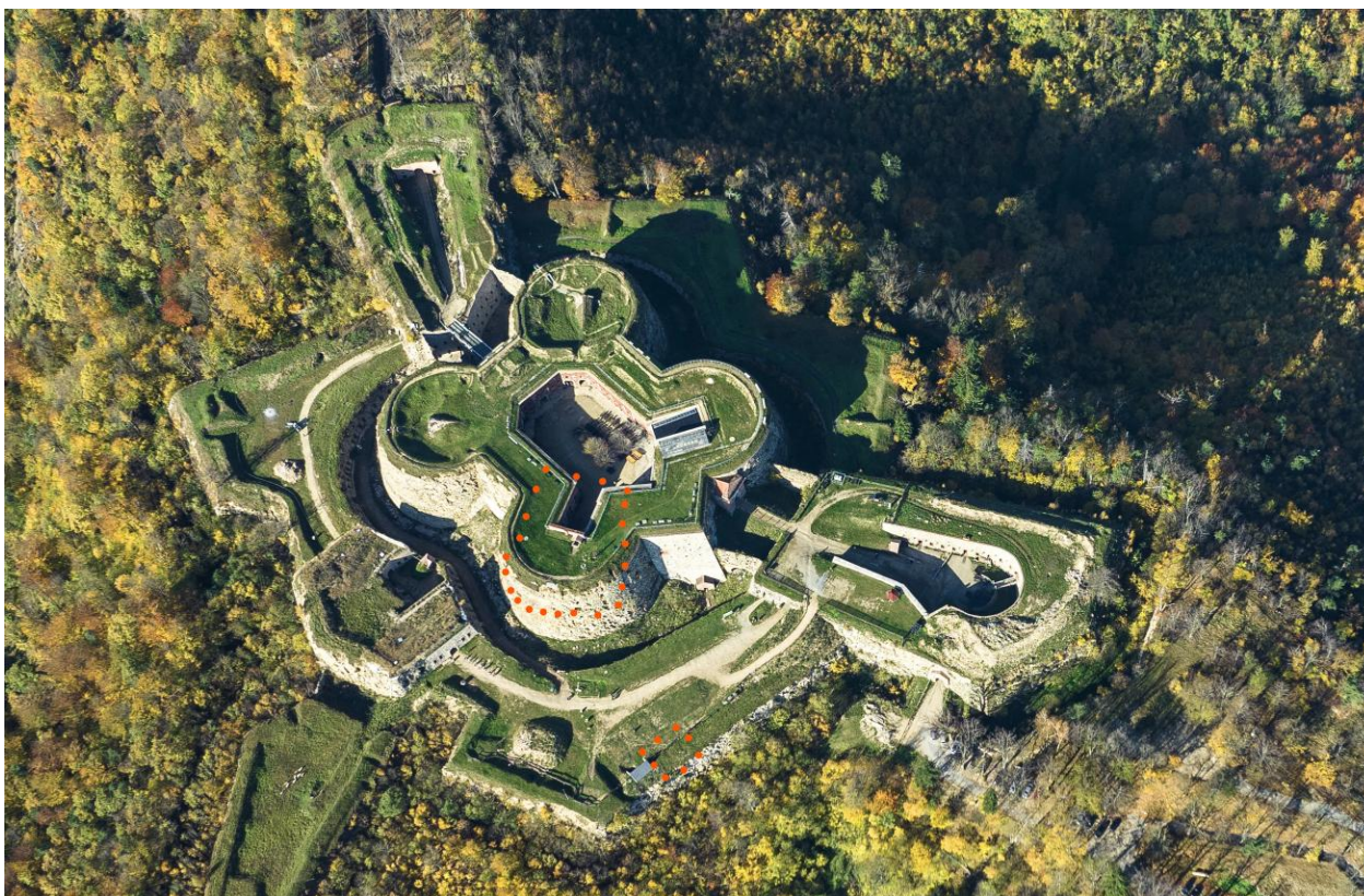
Il. 1. Rdzeń Twierdzy Srebrna Góra, ujęcie z drona. Kropkami oznaczono lokalizację zadania w Wieży Miejskiej Donjonu i na Bastionie Miejskim. Na całym terenie inwestycji na co dzień realizowany jest ruch turystyczny.
