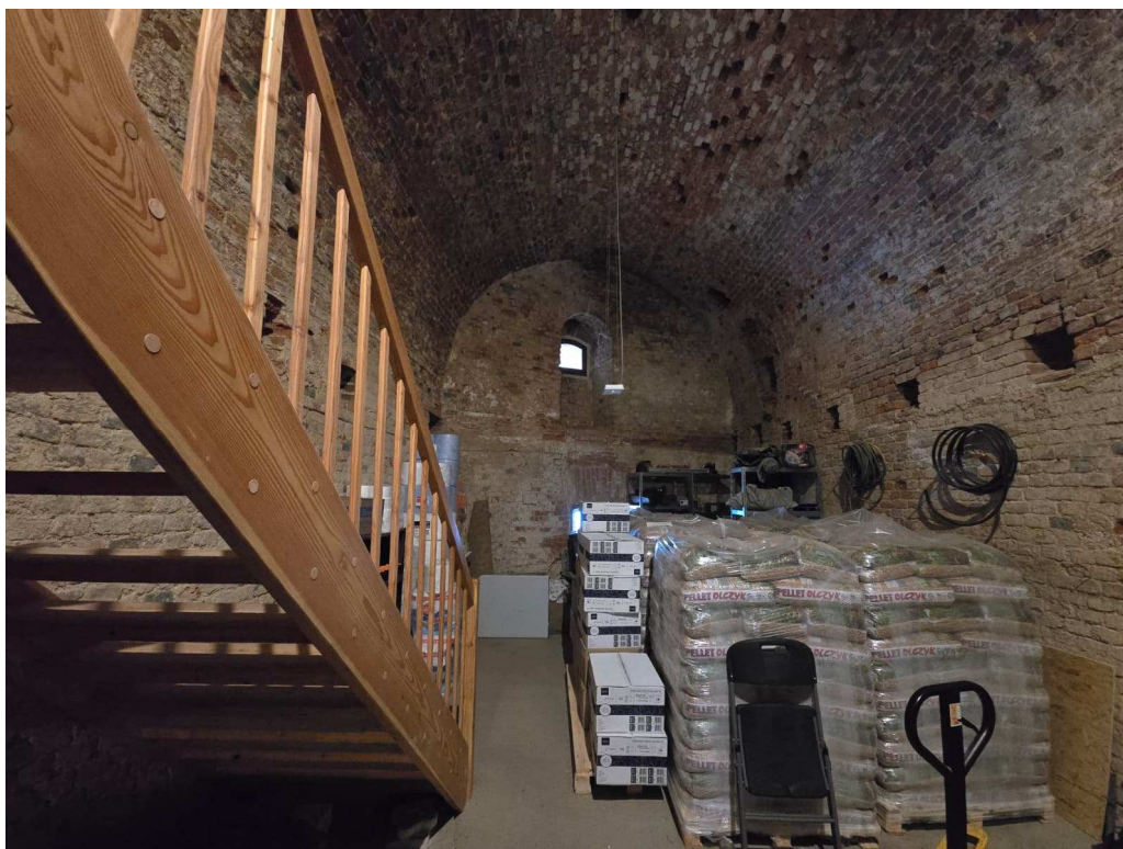
II.3. Stan murów wewnętrznych i sklepienia kazamaty nr 009 ocenia się jako dobry Widoczna drewniana klatka schodowa przeznaczona do demontażu. Kazamata posiada posadzkę betonową. W oknach stolarka okienna drewniana. W ścianach widoczne gniazda, w których oparte były belki stropowe.
