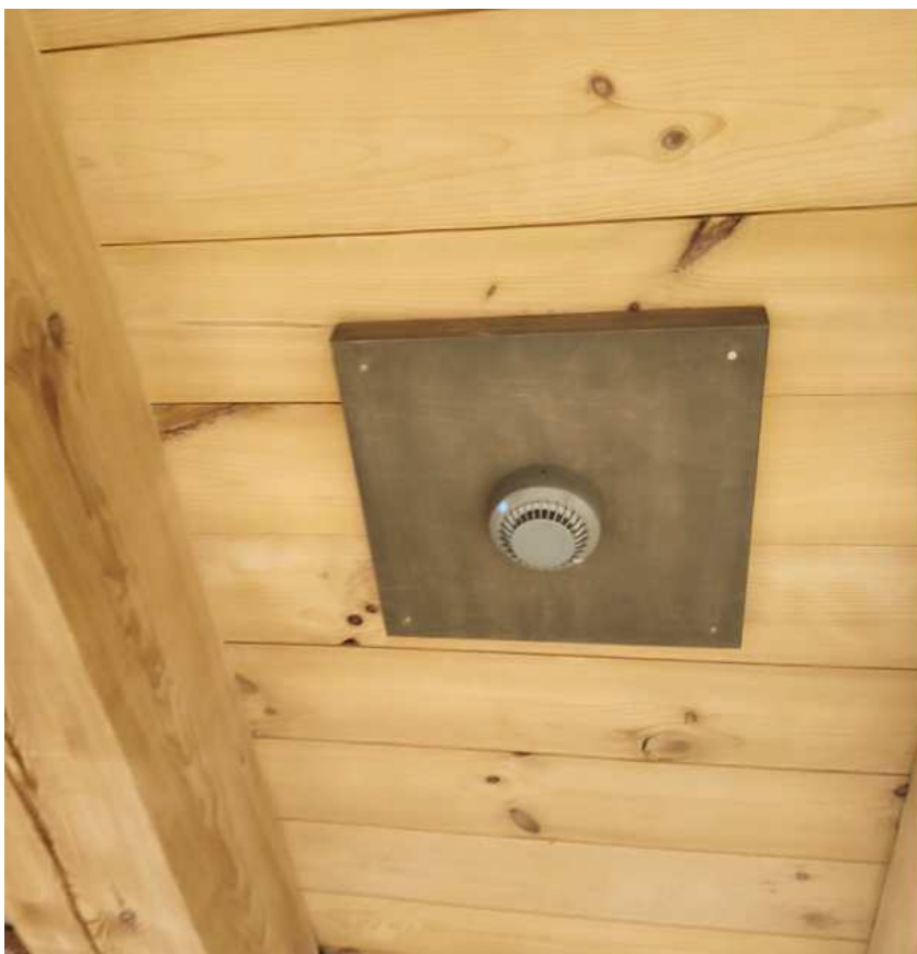
Montaż czujek SSP strop drewniany.
