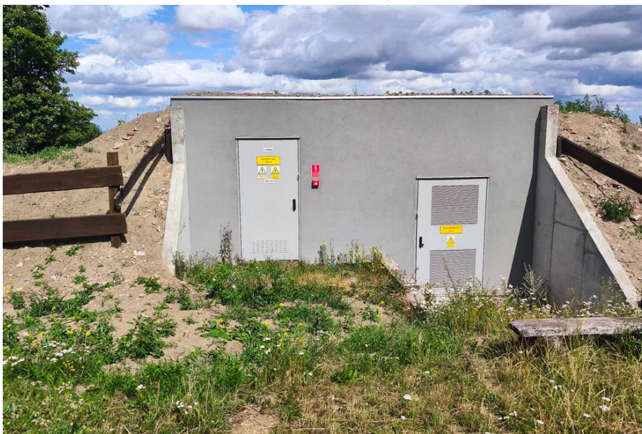
Budynek stacji transformatorowej.
