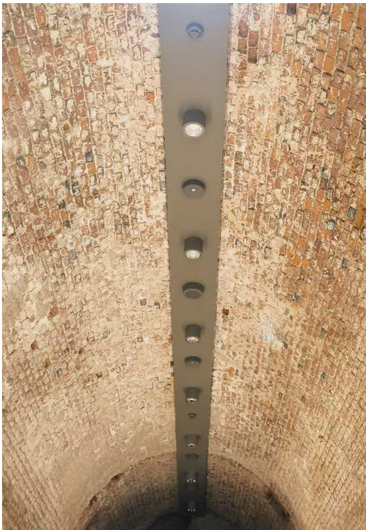
Montaż opraw i prowadzenie kabli w listwach podsklepiennych.
