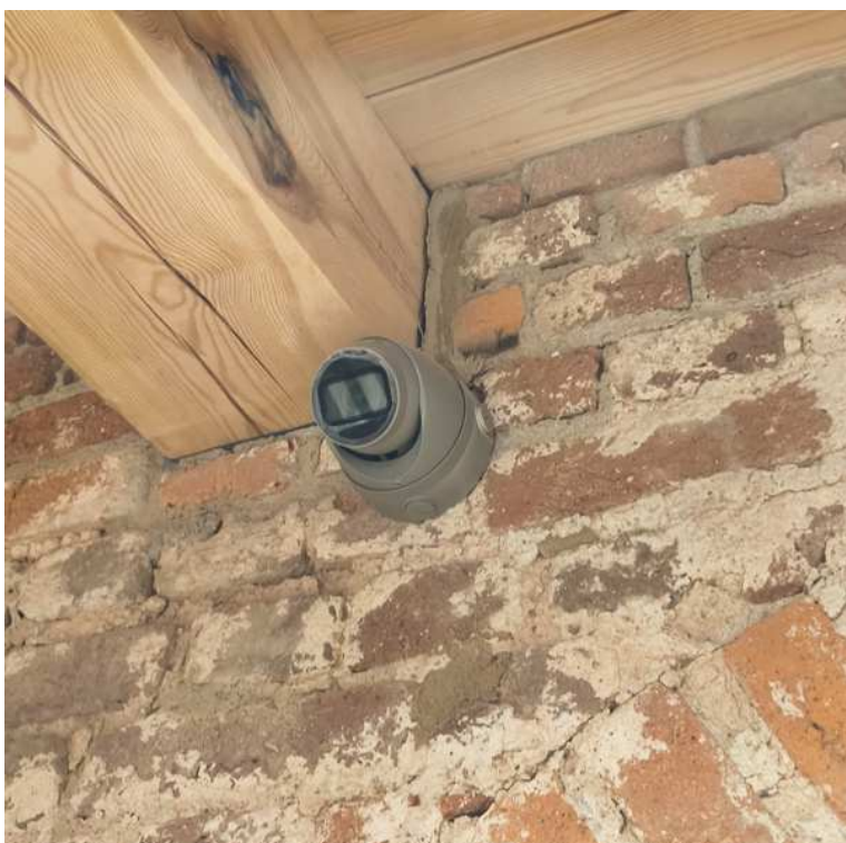
Montaż kamery monitoringu.
