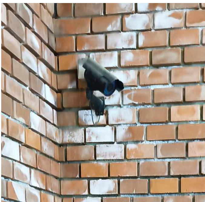
Montaż kamery monitoringu.
