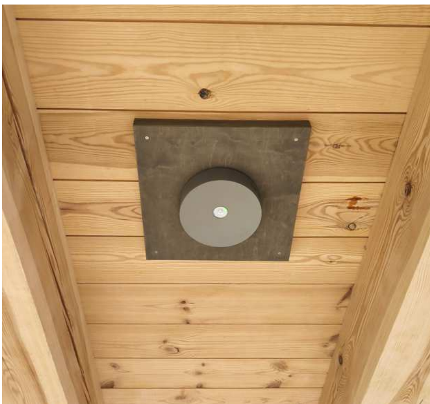
Montaż opraw awaryjnych strop drewniany.
