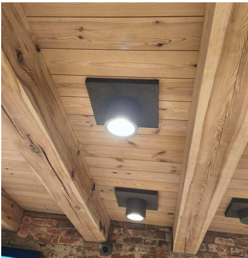
Montaż opraw strop drewniany.
