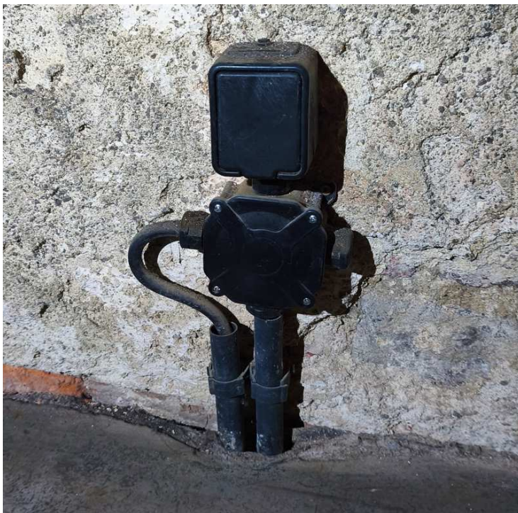
Gniazdo wtykowe pojedyncze, zasilane z posadzki.
