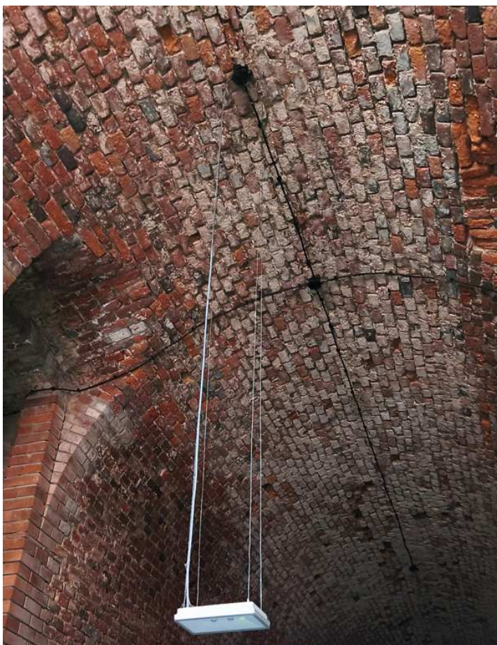
Instalacja zasilania oświetlenia natynkowa, montaż oprawy awaryjnej na linkach.
