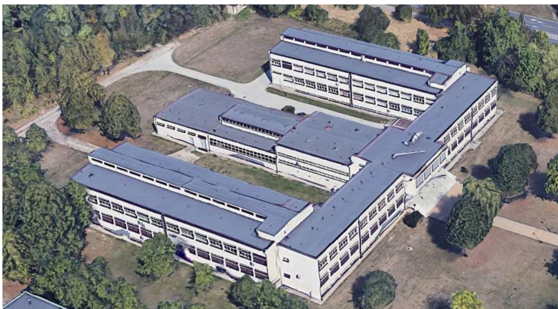
Widok ogólny budynku CMPW PAN w Zabrzu.
