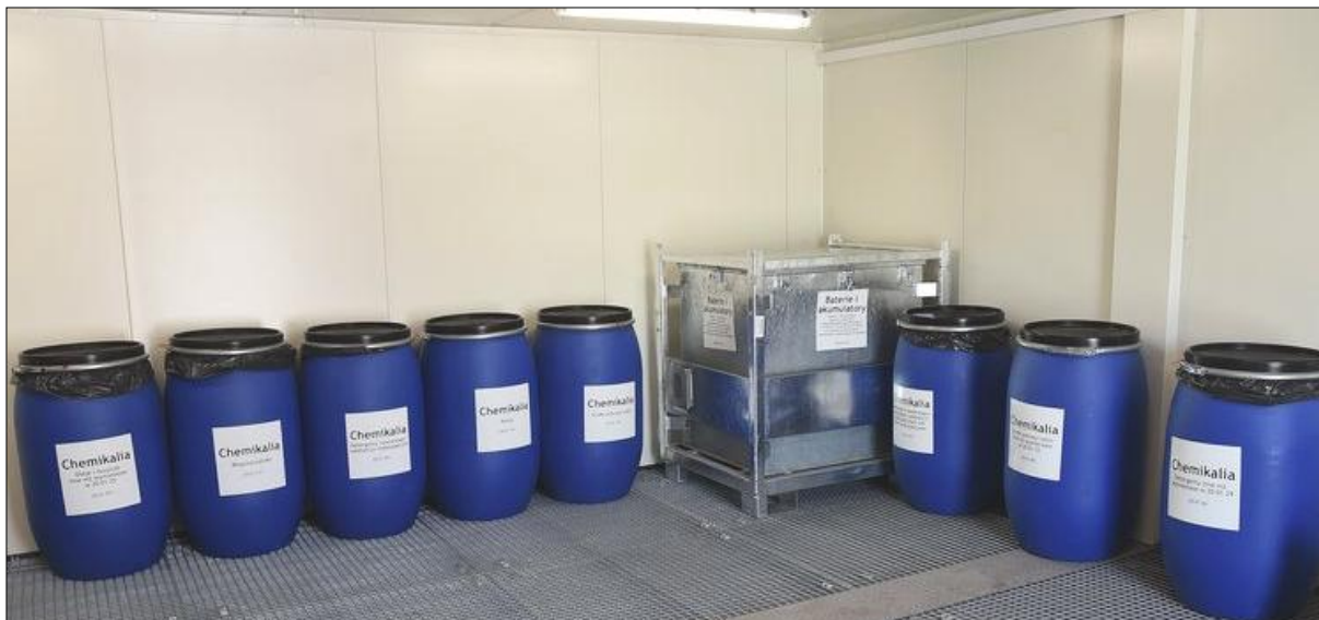
Ryc. 11. Propozycja wykonania podłogi magazynu ZSEE
