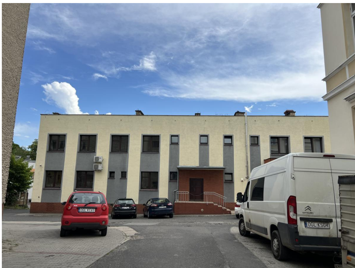
Fot. 4. Elewacja północna
