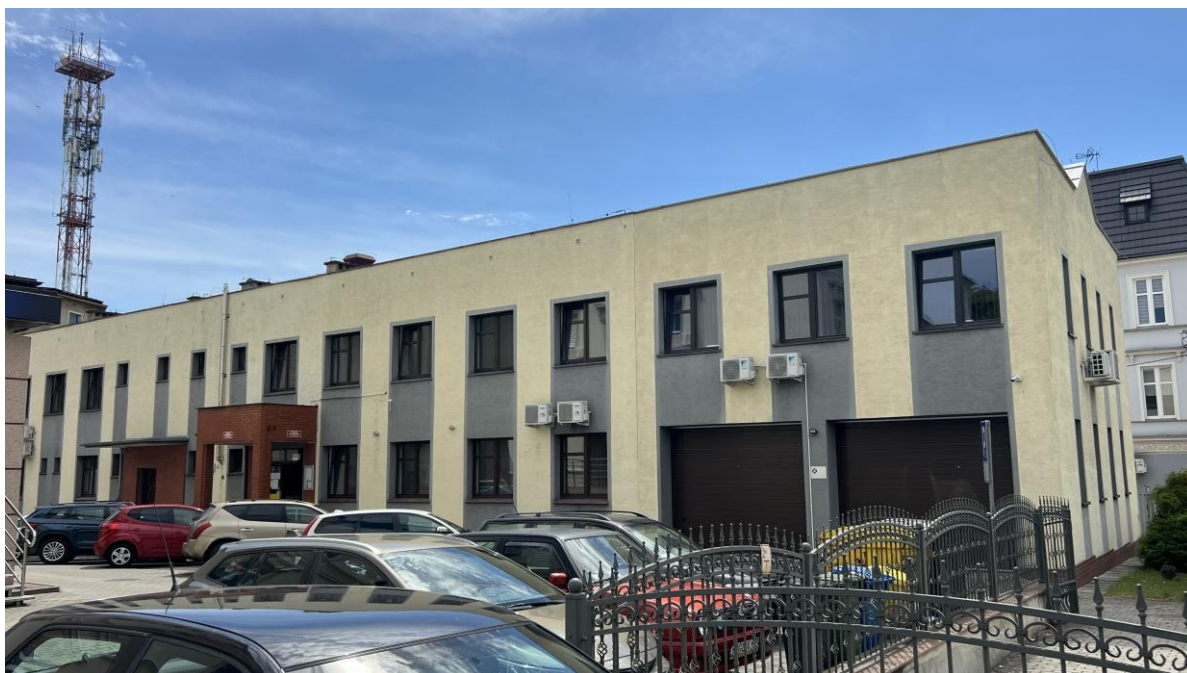
Fot. 3. Elewacja północna
