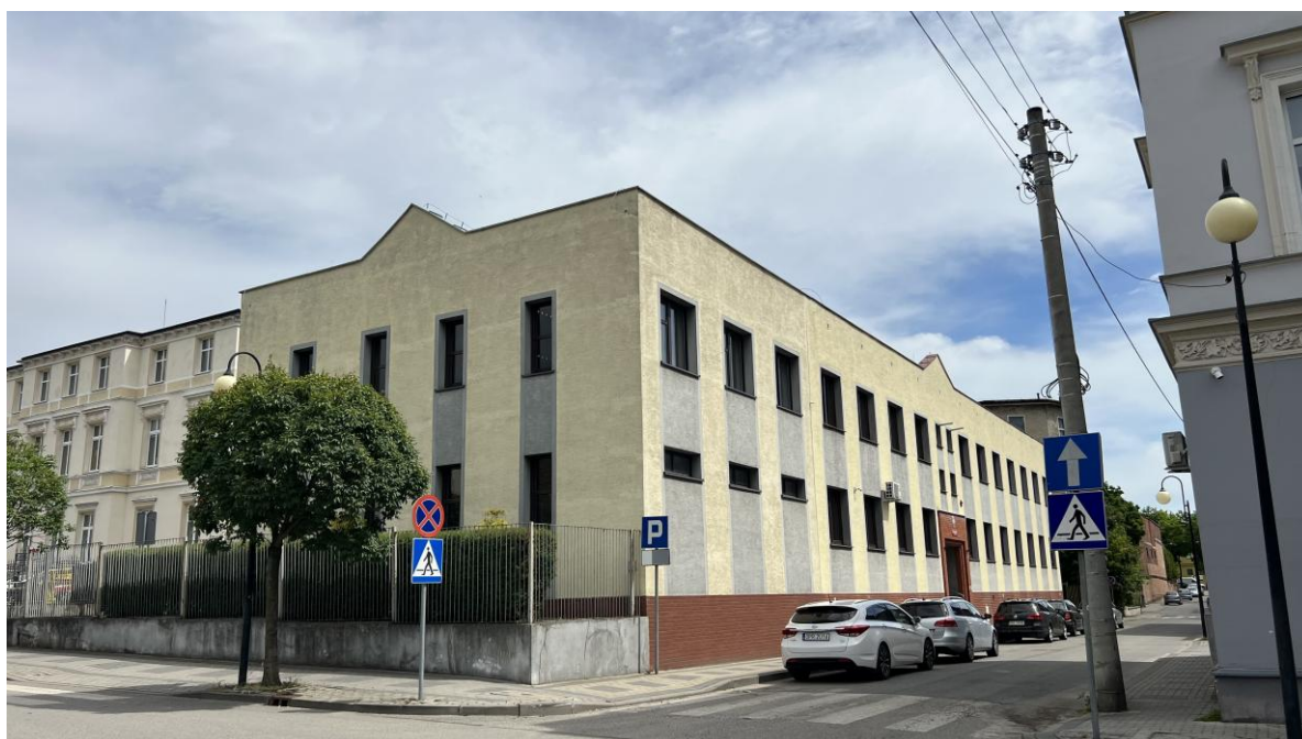
Fot. 2. Elewacja południowo- zachodnia
