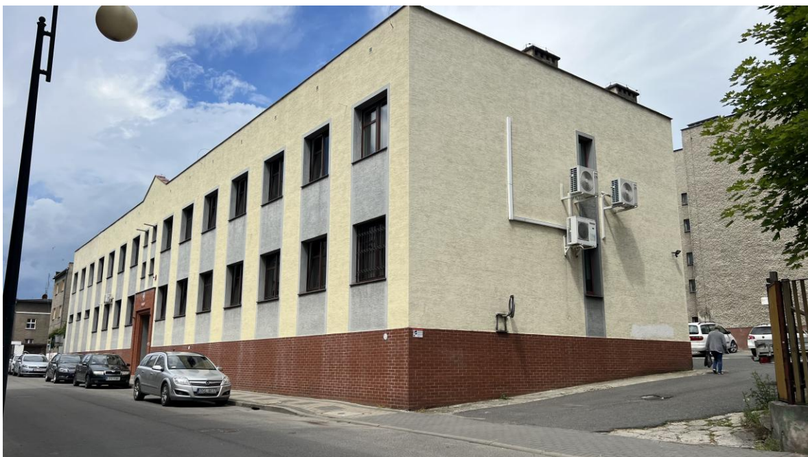
fot. 1. Elewacja południowo- wschodnia
