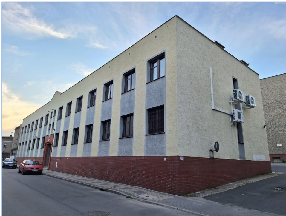
Fot. Elewacja budynku Urzędu Skarbowego w Głubczycach, ściana A.
