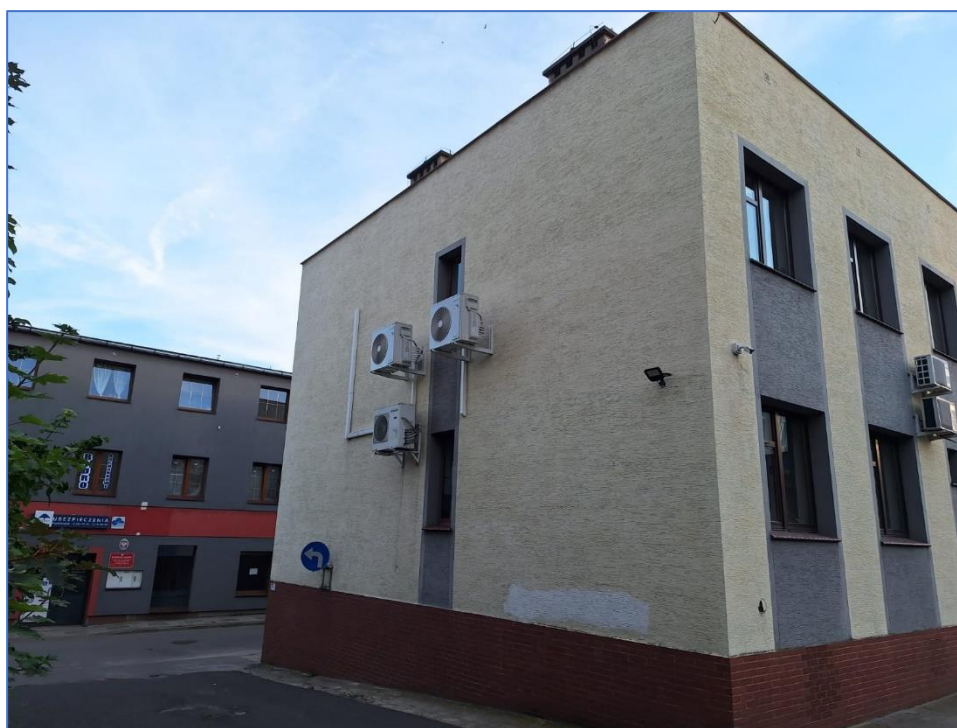
Fot. Elewacja budynku Urzędu Skarbowego w Głubczycach, ściana B.
