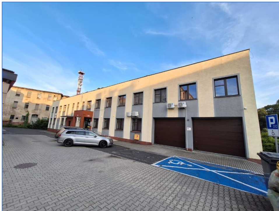
Fot. Elewacja budynku Urzędu Skarbowego w Głubczycach, ściana C.
