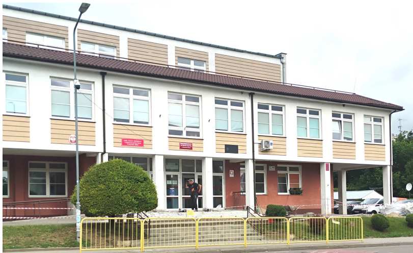
Fot. nr 1 Widok ogólny tarasu (elewacja frontowa)
