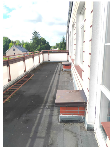
Fot. nr 2 Ścianka wewnętrzna i balustrada
