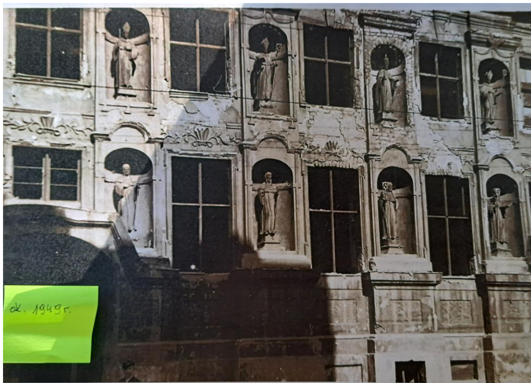
Fot. 1. Elewacja frontowa, zdjęcie archiwalne z r. ok. 1949. Widoczny katastrofalny stan tynków.
