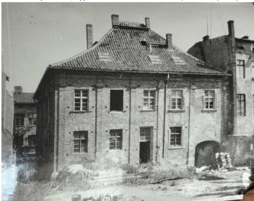
Fot. 2. Elewacja tylna, zdjęcie archiwalne, widoczne relikty tynków.
