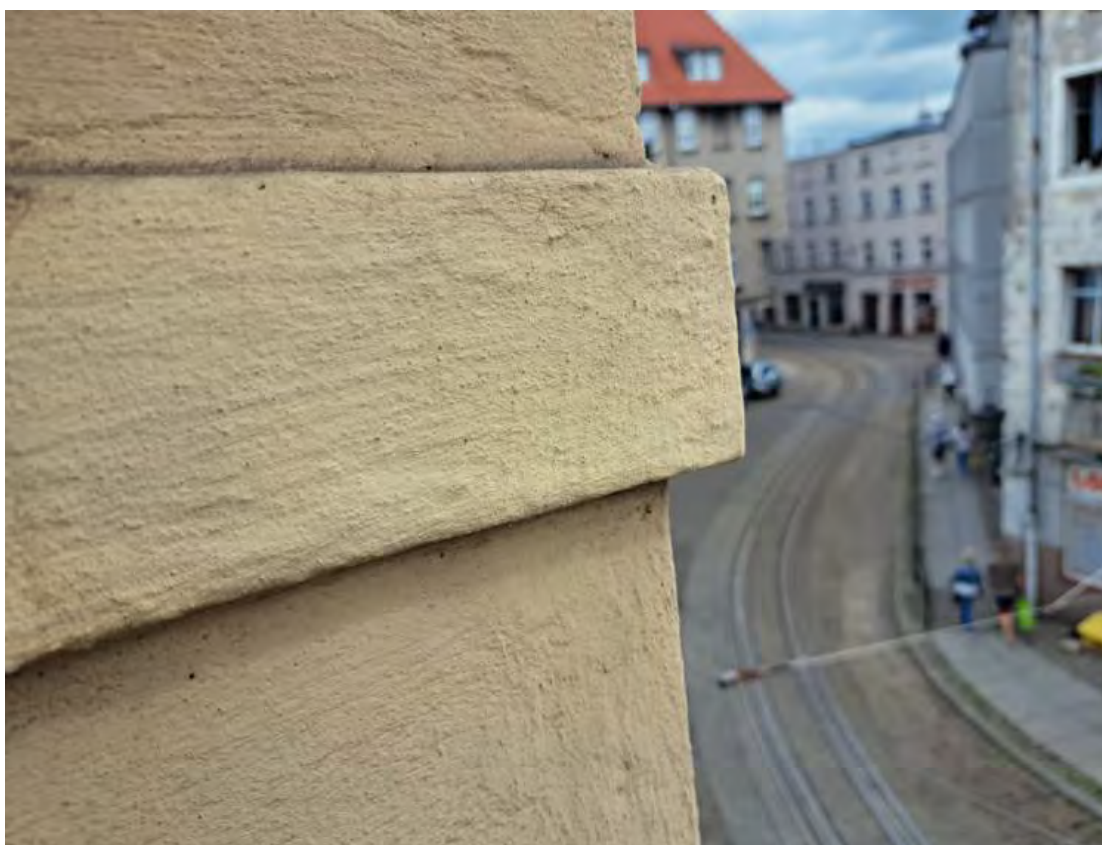
Fragmenty elewacji frontowej. Faktury tynków i wypraw malarskich w zbliżeniach.
