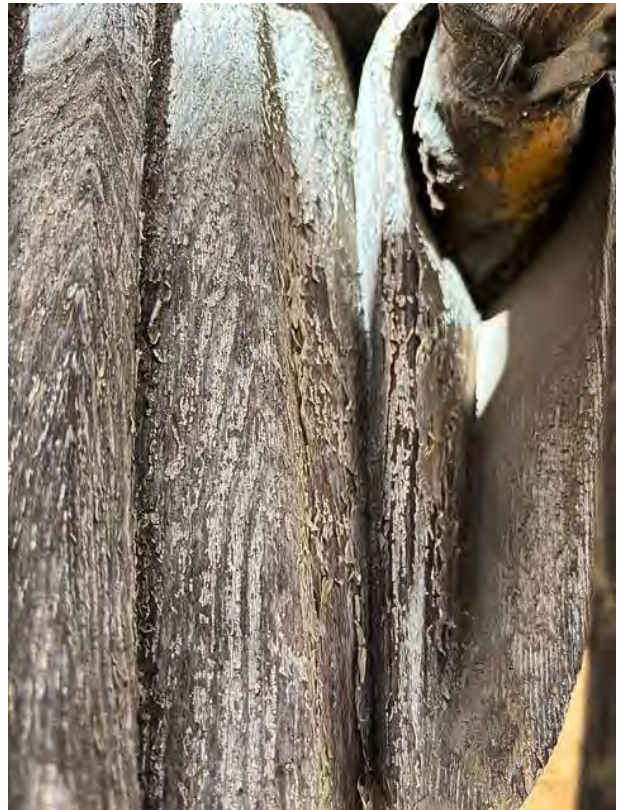
Śladowe resztki powłok zabezpieczających, korozja i lokalne ubytki fragmentów rzeźb, świadczą o konieczności demontażu rzeźb do kompleksowej konserwacji. Przy zabezpieczeniu i inwentaryzacji konserwatorskiej.
