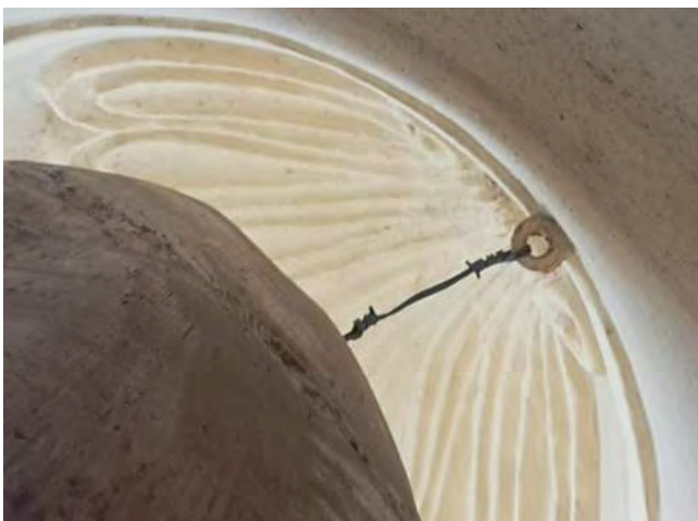
Przykłady sposobu aktualnego montażu rzeźb ściąganiem drutowym na plecach z uchem w niszy oraz nasadzeniem na trzpień ukryty w piedestale figury. Rzeźby stoją na przekładkach z papy z wypoziomowaniem i izolacyjnie.
