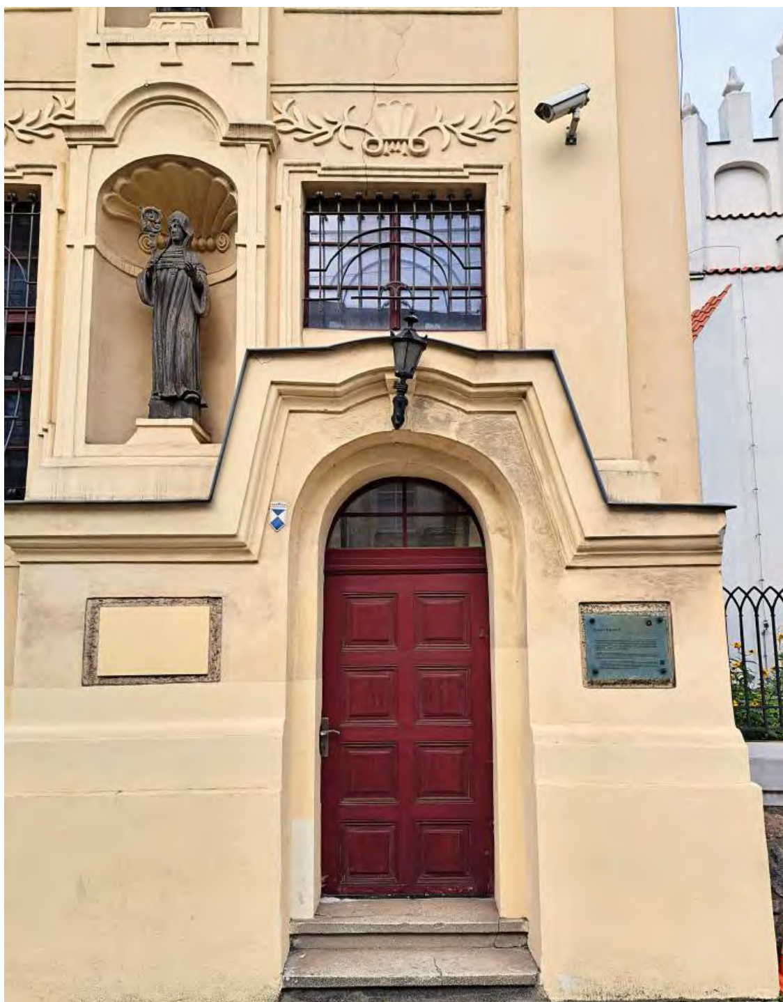
Portal drzwi wejściowych od elewacji frontowej, pozostających w dobrym stanie i stylistyce międzywojennej stolarki.
