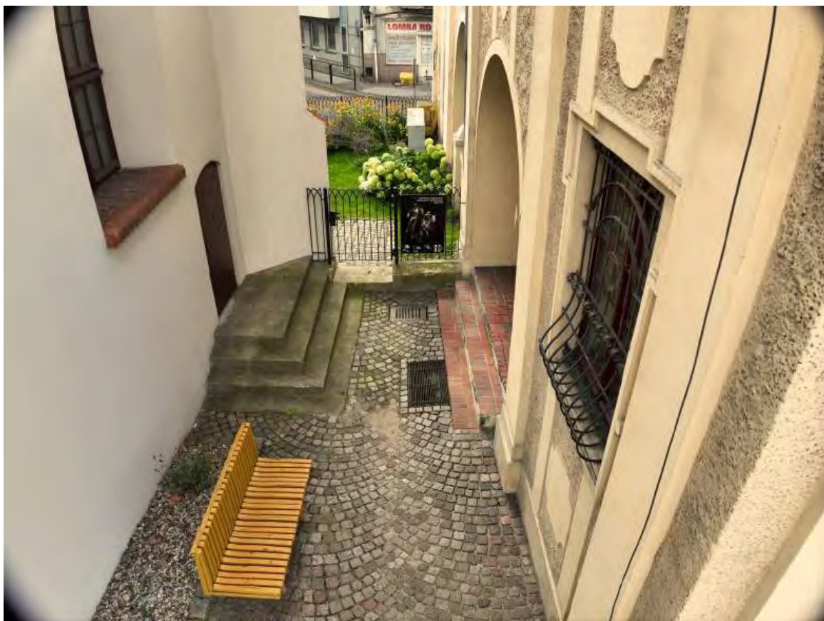
Dawna, bezpośrednia komunikacja kościoła z furtką klasztorną, dziś stanowi wejście do muzeum w podcieniu. Widoczny stan znacznych osadów zabrudzeń na tynkach rustykalnych zacienionej elewacji bocznej.
