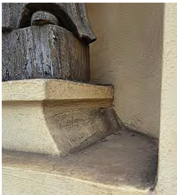
Stan zabrudzeń przy piedestałach, nieszczelności w posadowieniu rzeźb, skłania do interwencji konserwatorskiej.
