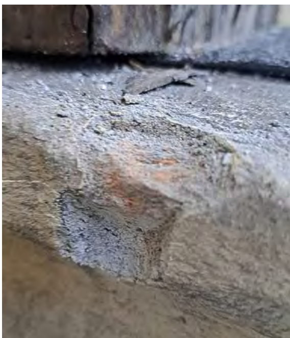
Stan zabrudzeń przy piedestałach, nieszczelności w posadowieniu rzeźb, skłania do interwencji konserwatorskiej.
