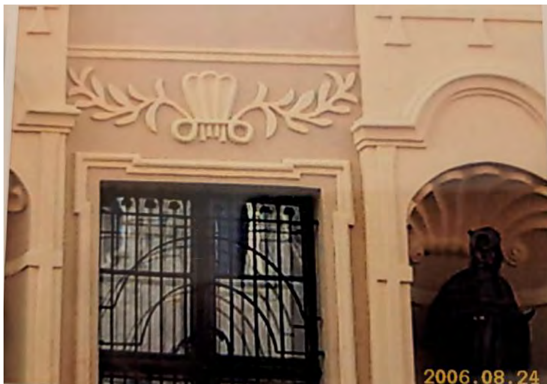
Skan zdjęcia z zasobów Muzeum Grudziądza, ukazuje kolejne interpretacje barw historyzujących. Widoczne w odkrywkach warstw na elewacjach jako wtórne wyprawy ochrowej barwy i różowych powłok.
