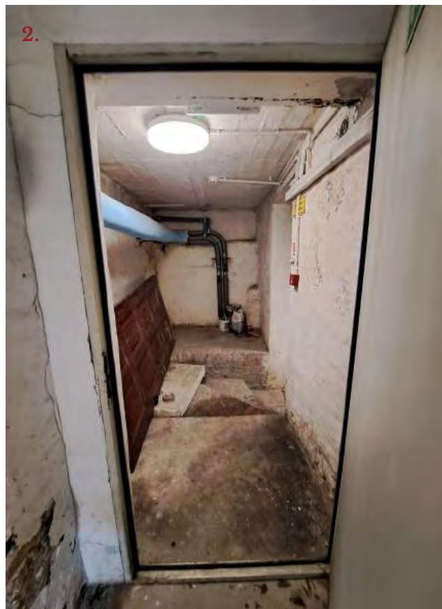
Drzwi wejściowe i korytarze wymagają modyfikacji wentylacyjnej, celem poprawy cyrkulacji powietrza w całej piwnicy.
