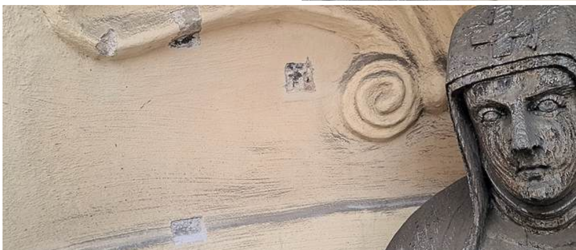
Widoczne ślady prób poszukiwań warstw historycznych zapraw, kolorystyki w odkrywkach stratygraficznych nisz. Objawiły głównie znaczne wtórne przetworzenia substancji elewacji, zabrudzenia czy przecierki cementowe.
