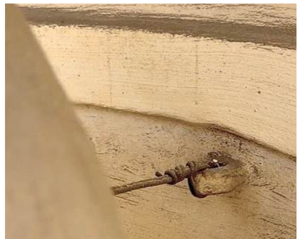
Przykłady sposobu aktualnego montażu rzeźb ściąganiem drutowym na plecach z uchem w niszy oraz nasadzeniem na trzpień ukryty w piedestale figury. Rzeźby stoją na przekładkach z papy z wypoziomowaniem i izolacyjnie.
