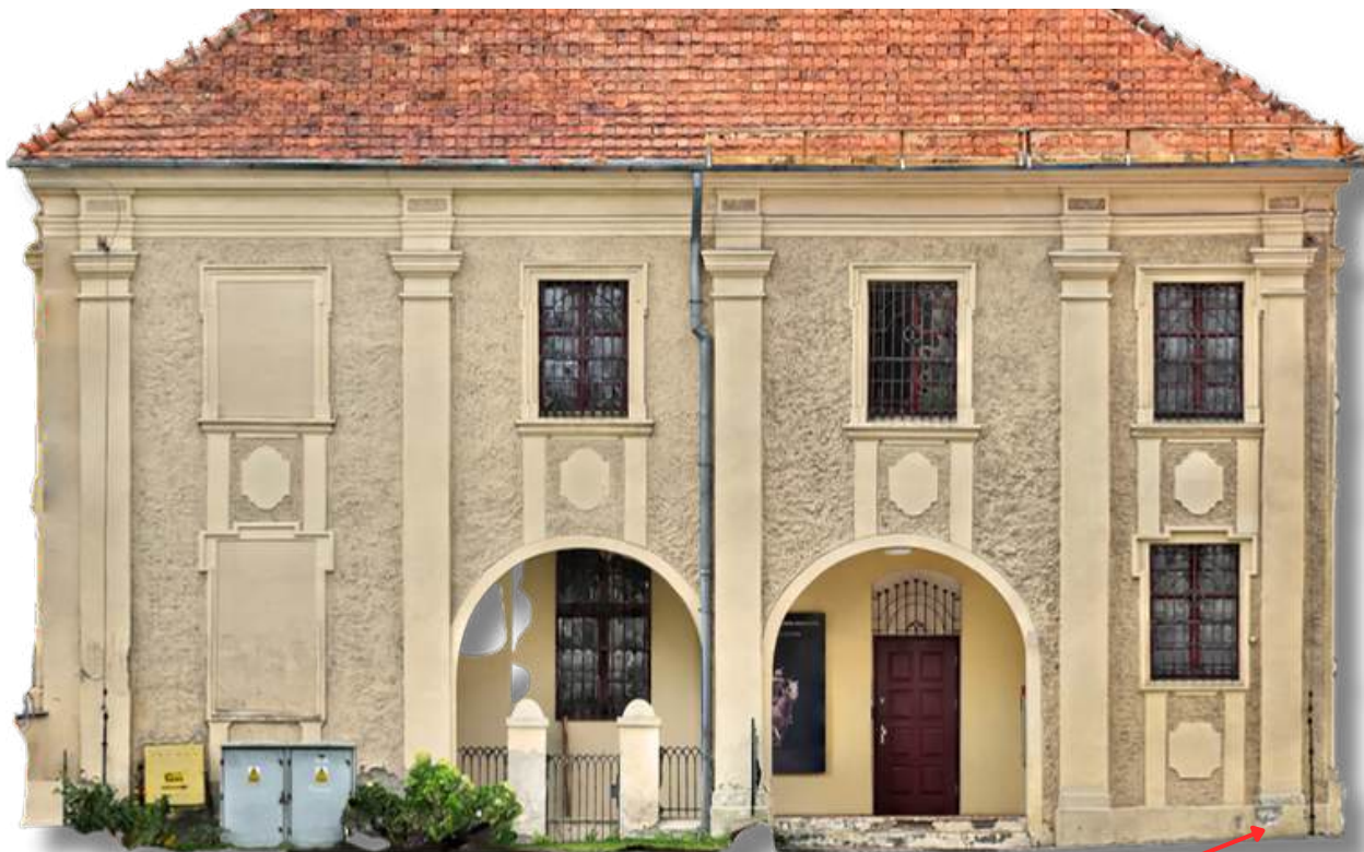
Ortofotomapa kładu elewacji, obrazuje zakres zniszczeń.
