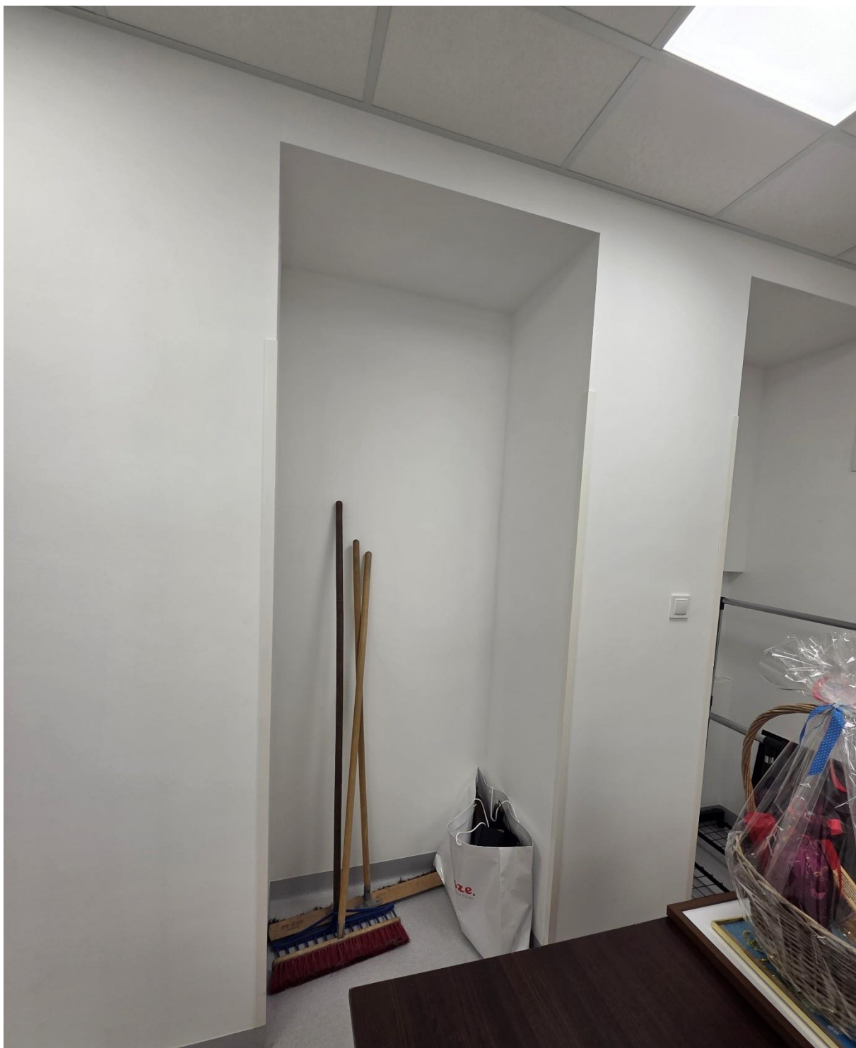
Lokalizacja szafy – wnęka.
