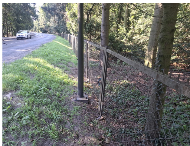
FOTO NR 10 – odcinek 9
