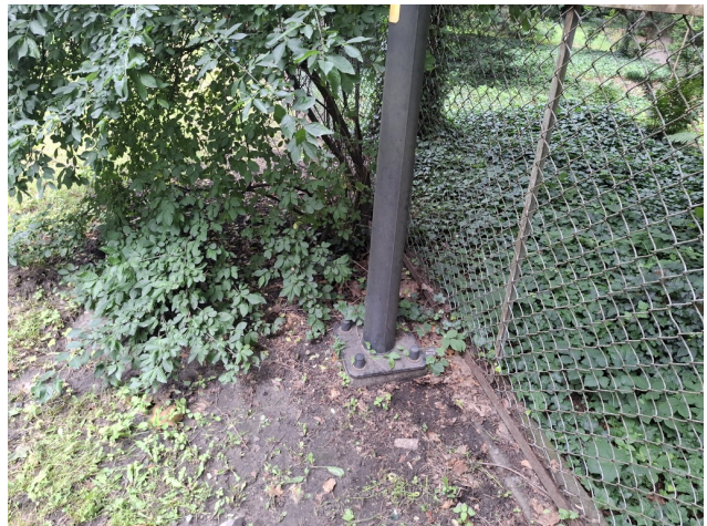
FOTO NR 7 – odcinek 4
