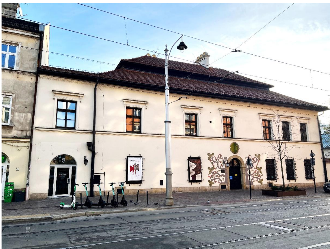
Fot. 1 Widok budynku od strony frontowej
