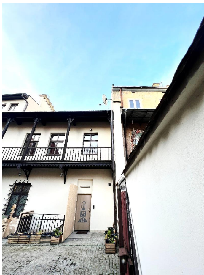
Fot. 4 Widok ściany sąsiedniego budynku
