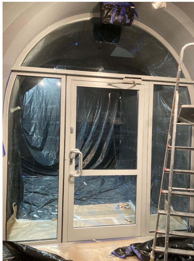
Fot. nr 36 Budynek Muzeum Etnograficznego „Dom Esterki” przy ul. Krakowskiej 46 w Krakowie. Pomieszczenie wystawiennicze, widok współczesnej ślusarki drzwiowej w przejściu do przedsionka wejścia bocznego na elewacji zach. Stan przed konserwacją. Kraków, 2024 r.
