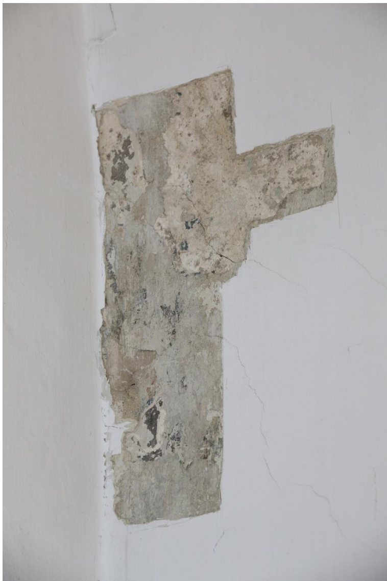
Fot. nr 22 Budynek Muzeum Etnograficznego „Dom Esterki” przy ul. Krakowskiej 46 w Krakowie. Pomieszczenie biblioteki. Odkrywka na wysklepce. Widoczne relikty historycznych warstw malarskich. Stan przed konserwacją. Kraków, luty 2026 r.
