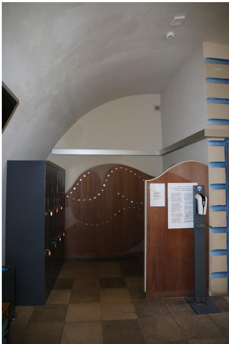
Fot. nr 29 Budynek Muzeum Etnograficznego „Dom Esterki” przy ul. Krakowskiej 46 w Krakowie. Pomieszczenie sieni z wydzieloną toaletą. Widok na ścianę z planowanym przebicciem do sali wystawowej. Stan przed konserwacją. Kraków, luty 2026 r.
