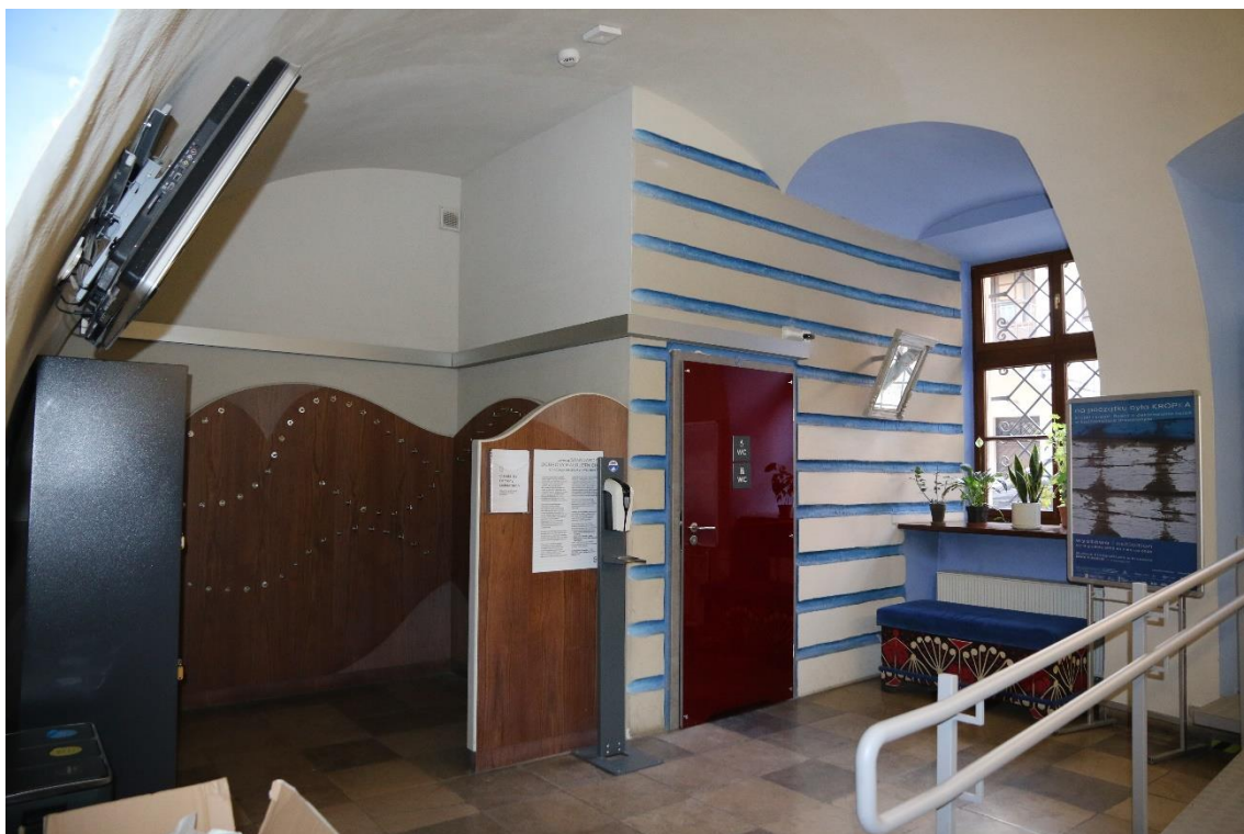
Fot. nr 25 Budynek Muzeum Etnograficznego „Dom Esterki” przy ul. Krakowskiej 46 w Krakowie. Pomieszczenie sieni z wydzieloną toaletą. Stan przed konserwacją. Kraków, luty 2026 r.
