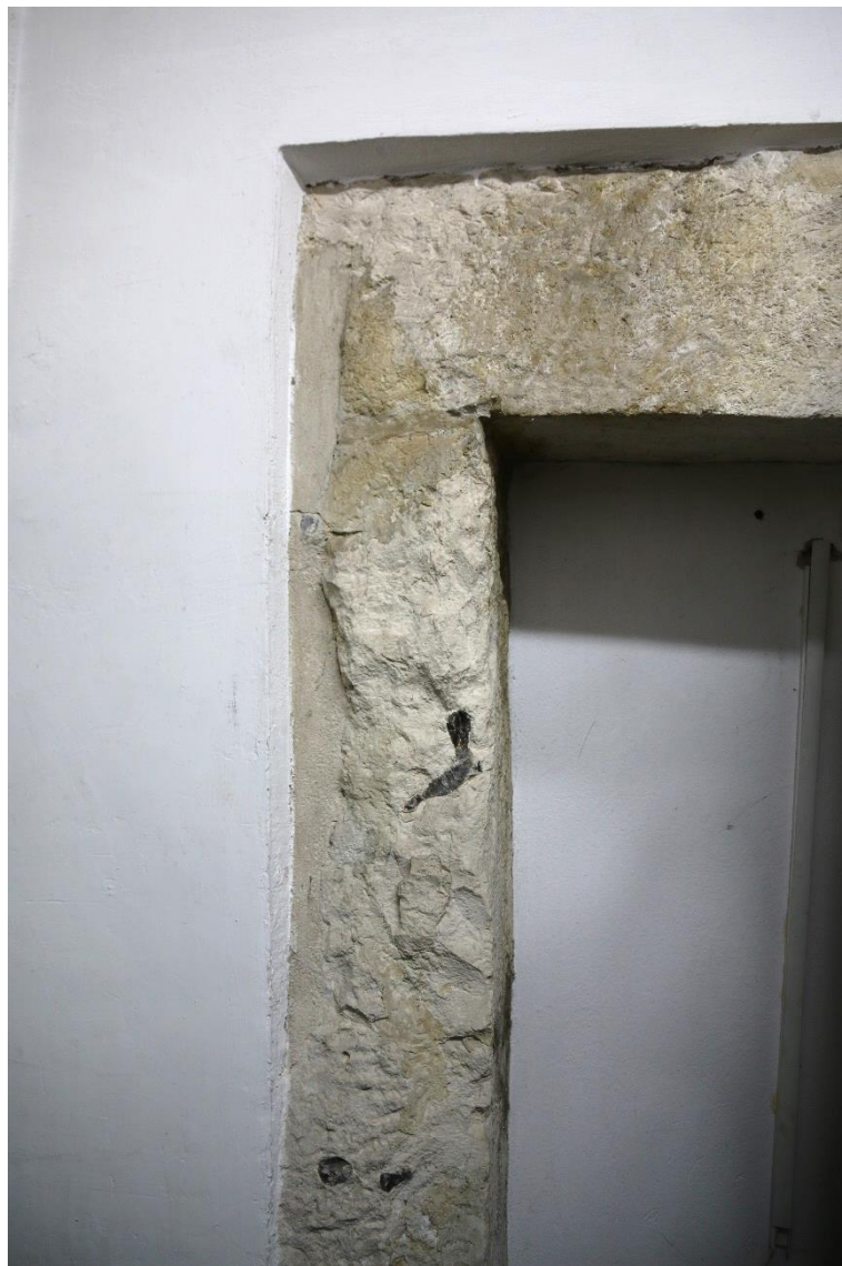
Fot. nr 19 Budynek Muzeum Etnograficznego „Dom Esterki” przy ul. Krakowskiej 46 w Krakowie. Pomieszczenie biblioteki. Widoczny fragment kamienny portal na północnej ścianie. Stan przed konserwacją. Kraków, luty 2026 r.
