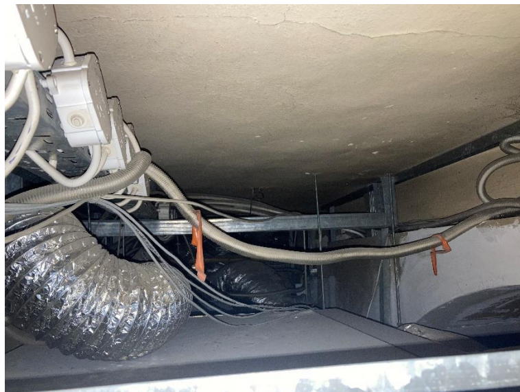
Fot. nr 40 Budynek Muzeum Etnograficznego „Dom Esterki” przy ul. Krakowskiej 46 w Krakowie. Pomieszczenie dawnej sieni przejazdowej, widok sufitu ponad sufitem podwieszanym. Widoczne współczesne instalacje. Stan przed konserwacją. Kraków, 2024 r.
