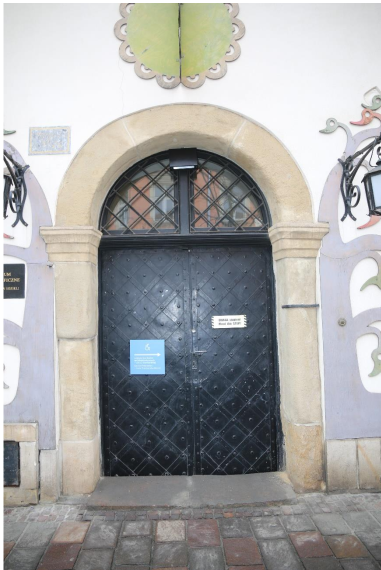
Fot. nr 5 Budynek Muzeum Etnograficznego „Dom Esterki” przy ul. Krakowskiej 46 w Krakowie. Widok drzwi wejścia głównego oraz portalu z piaskowca na elewacji zachodniej. Stan przed konserwacją. Kraków, luty 2026 r.
