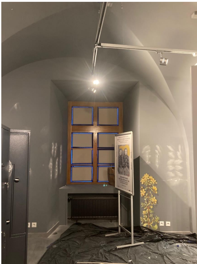
Fot. nr 35 Budynek Muzeum Etnograficznego „Dom Esterki” przy ul. Krakowskiej 46 w Krakowie. Pomieszczenie wystawiennicze, widok okna na ścianie zachodniej. Stan przed konserwacją. Kraków, 2024 r.
