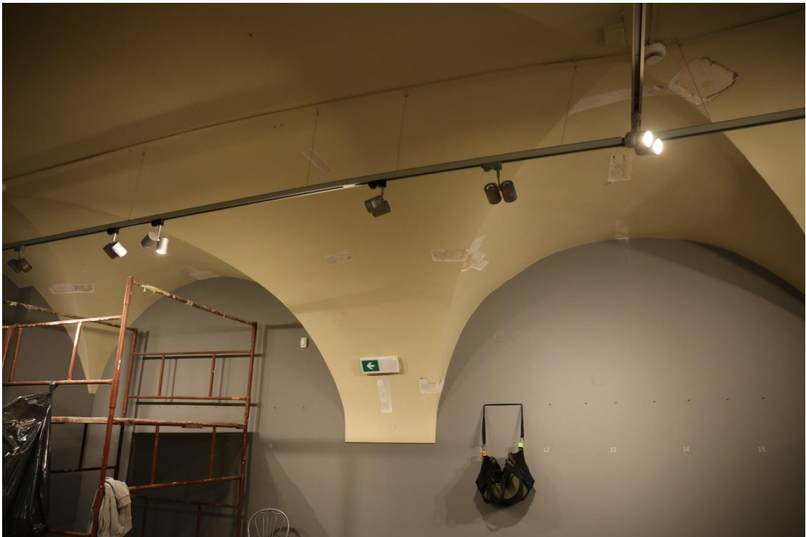
Fot. nr 33 Budynek Muzeum Etnograficznego „Dom Esterki” przy ul. Krakowskiej 46 w Krakowie. Pomieszczenie wystawiennicze, fragment ściany południowej. Widoczne odkrywki na sklepieniu na obecność polichromii. Stan przed konserwacją. Kraków, luty 2026 r.
