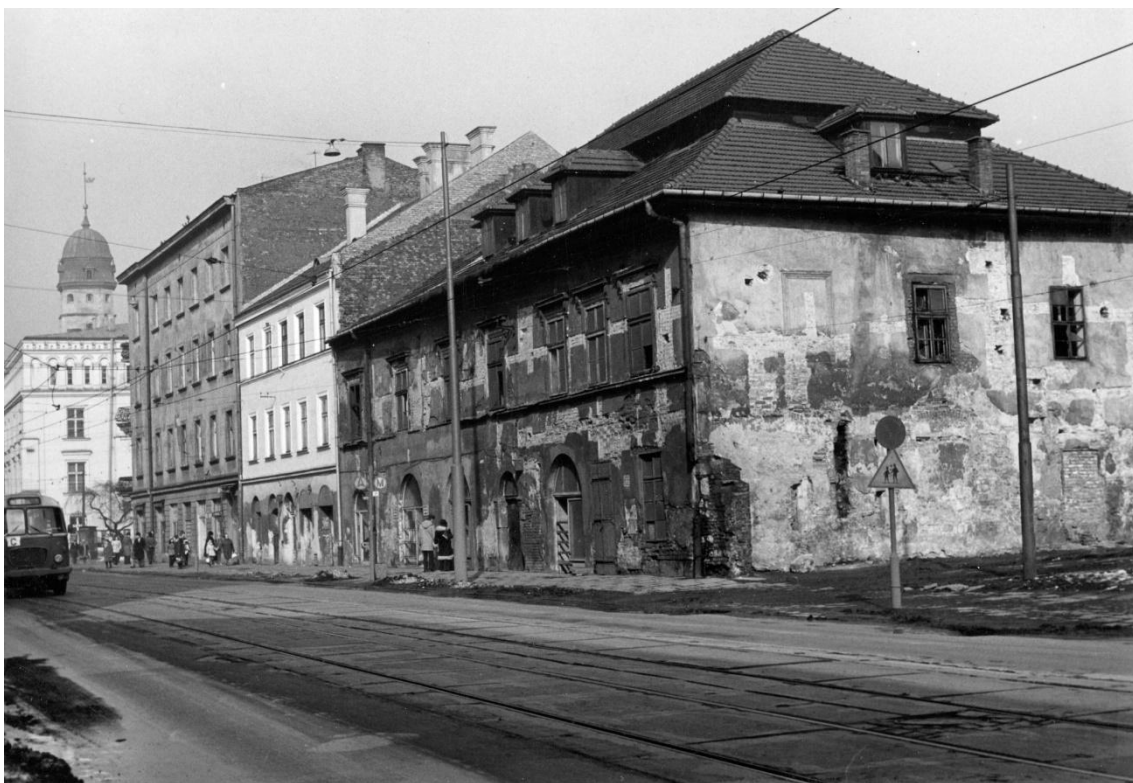
Fot. nr 3 Elewacja frontowa Domu Esterki ok. 1975 r. Widoczne przebudowane otwory wejściowe w obrębie parteru. Widok podczas badań architektonicznych. Fot. Stanisław Świętoń. Źródło: Muzeum Etnograficzne w Krakowie
