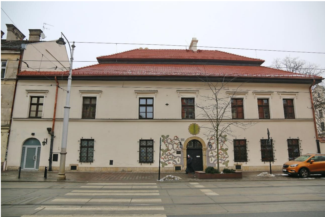
Fot. nr 1 Budynek Muzeum Etnograficznego „Dom Esterki” przy ul. Krakowskiej 46 w Krakowie. Widok ogólny elewacji frontowej zachodniej. W lewej skrajnej osi parteru widoczne współczesne aluminiowe drzwi. Stan przed konserwacją.
