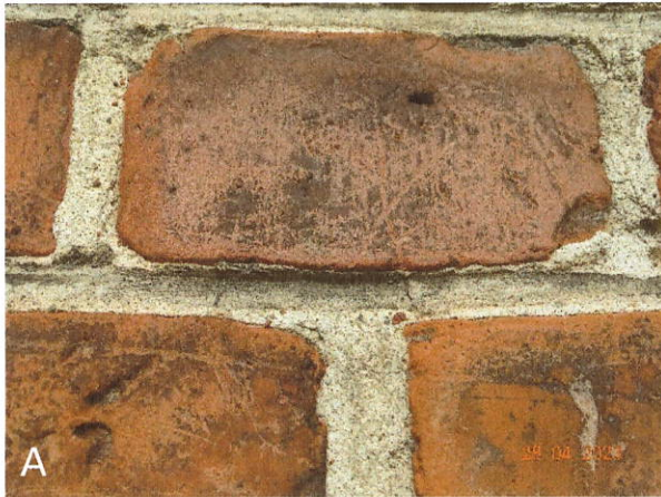
fot 3. A i B – Fragmenty ceglanej ściany – spoina między cegłami.
