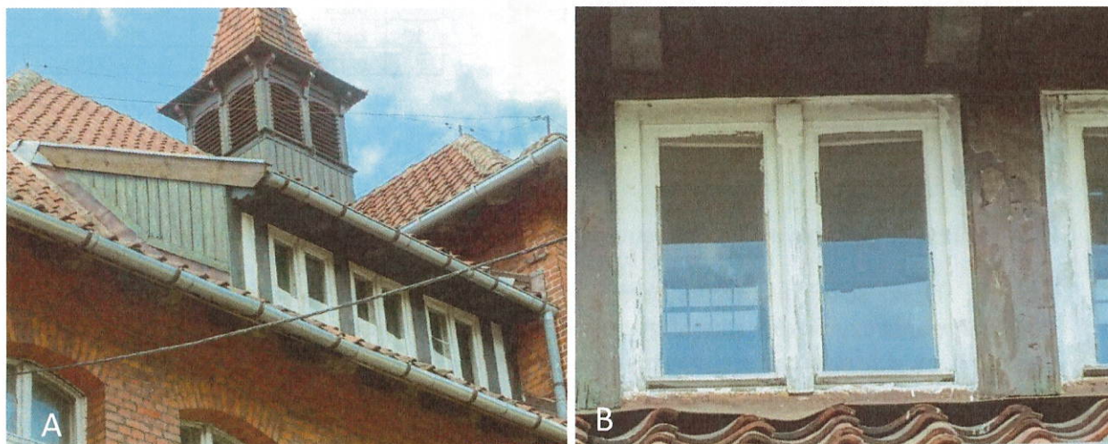
fot 13. A – widok na lukarnę dachową; B – okno lukarny.
