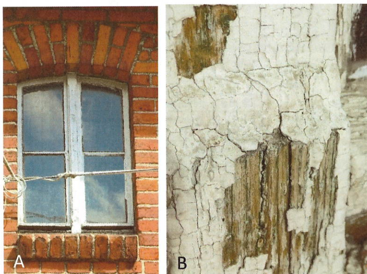
fot 24. Okno w dawnym budynku gospodarczym: A – zachowane oryginalne okno na elewacji północnej; B – fragment skrzydła okiennego pokazujący stopień zniszczenia powłok i drewna.
