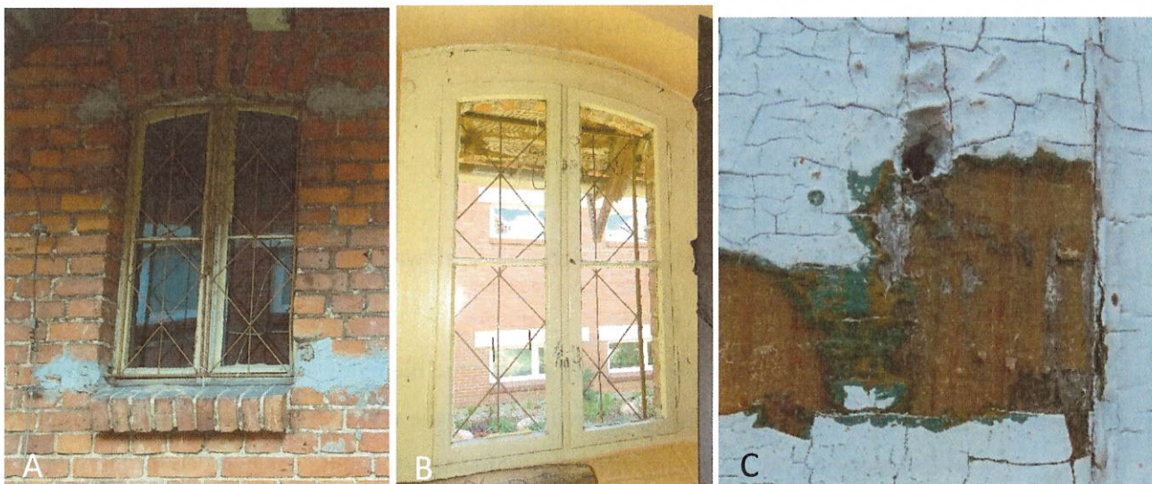
fot 25. Oryginalne okna w budynku gospodarczym: A – widok od zewnątrz; B – widok od wewnątrz; C – odkrywka na framudze.
