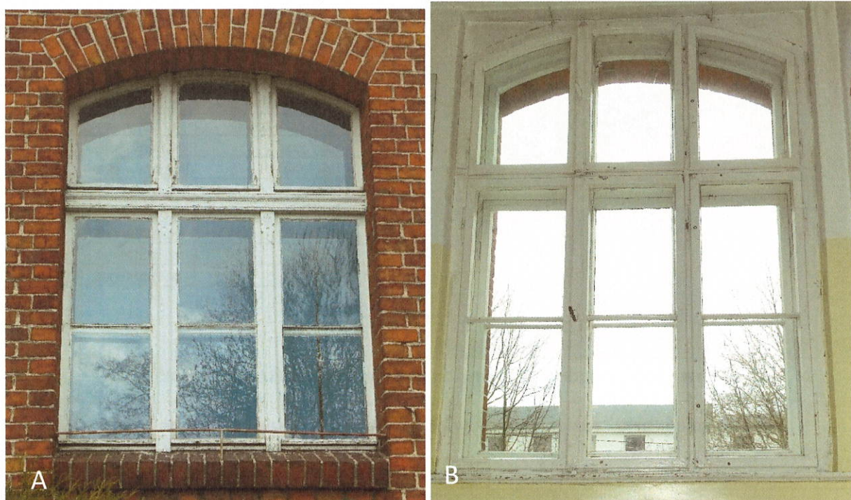
fot 9. Okno na klatce schodowej: A – z zewnątrz. B – od wewnątrz.
