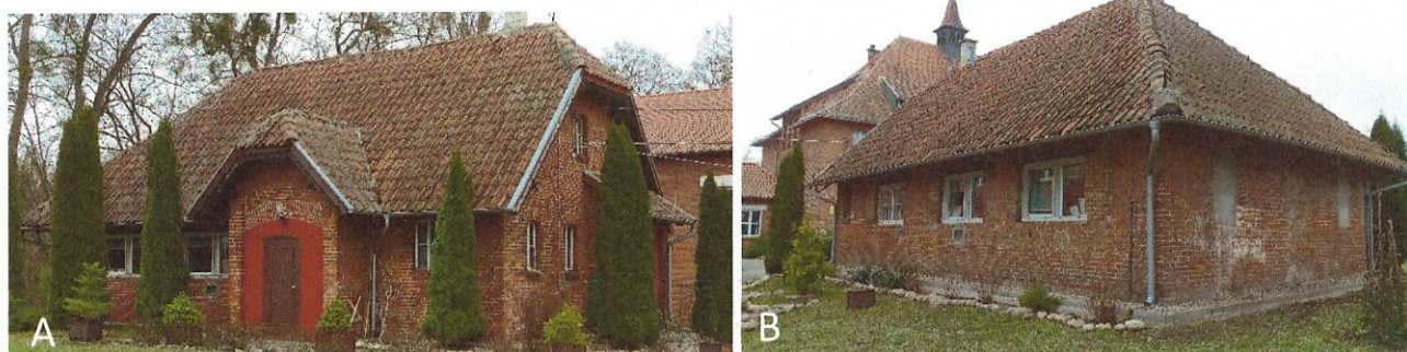
fot 23. Dawny budynek gospodarczy: A – elewacja frontowa, od północy; B – widok od wschodu.
