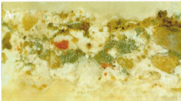
fot 5. Próbkę nr 2 ze spoiny – widoczne spękania struktury, zróżnicowane ziarna wypełniacza (piasek okruszyny cegły), a także szare zanieczyszczenia, które wniknęły w głąb.
