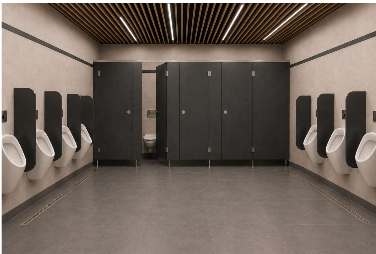
Widok zakresu toalet wraz z zabudową kabin, pisuarami i podłogowym odprowadzeniem liniowym.
