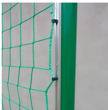
Przykładowy profil do mocowania haczyków siatki piłkochwytu – źródło https://www.sport-transfer.com.pl
