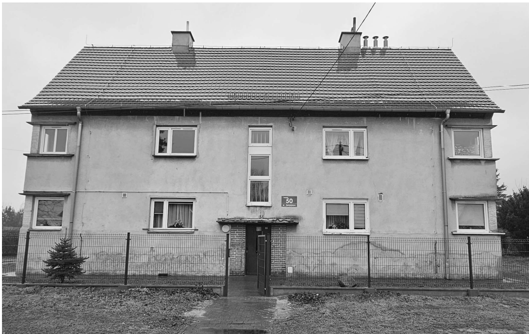
Rys. nr 2. Widok elewacji frontowej – północnej – od ul. W. Świerzego.
