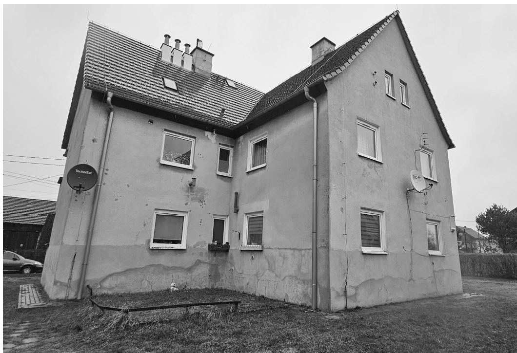
Rys. nr 3. Widok elewacji – fragment elewacji południowej i zachodniej.
