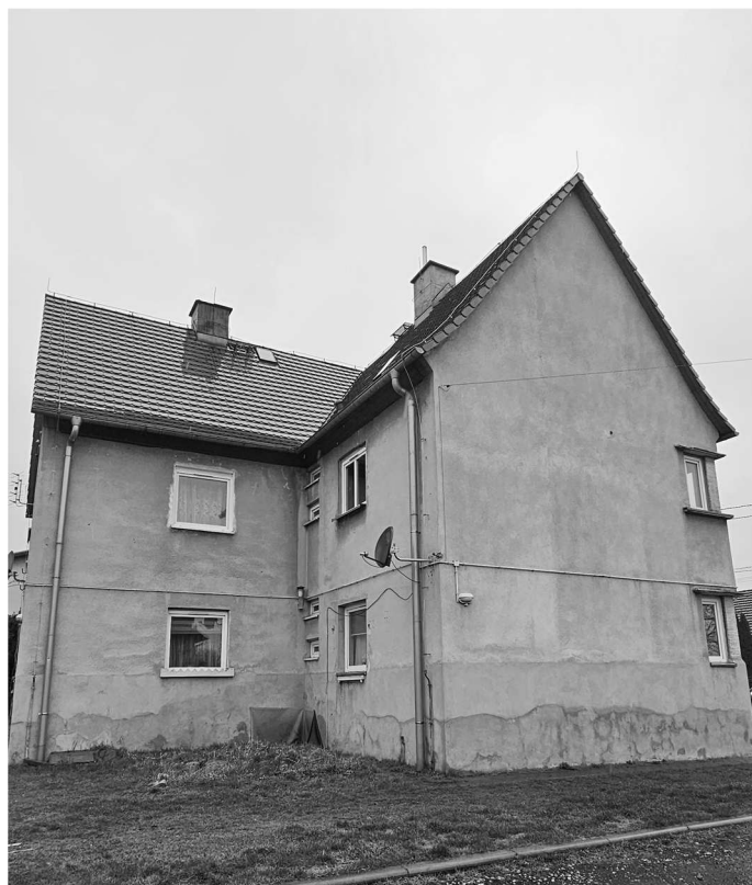
Rys. nr 4. Widok elewacji – fragment elewacji wschodniej i południowej.
