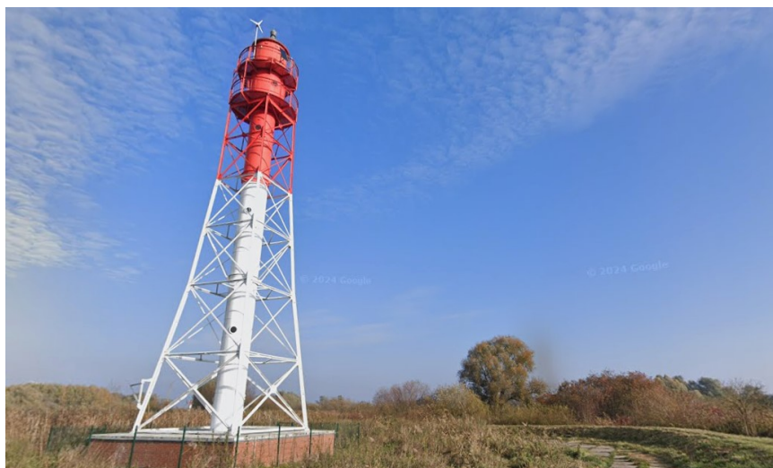
Fot. 3 Miejsce zakończenia przebiegu szlaku po istniejącym wale, przejście w kierunku Odry – źródło Google
