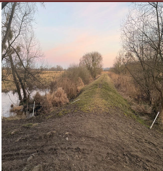
Fot. 8 Widok na istniejący wał przeznaczony pod przyszłą lokalizację szlaku rowerowego
