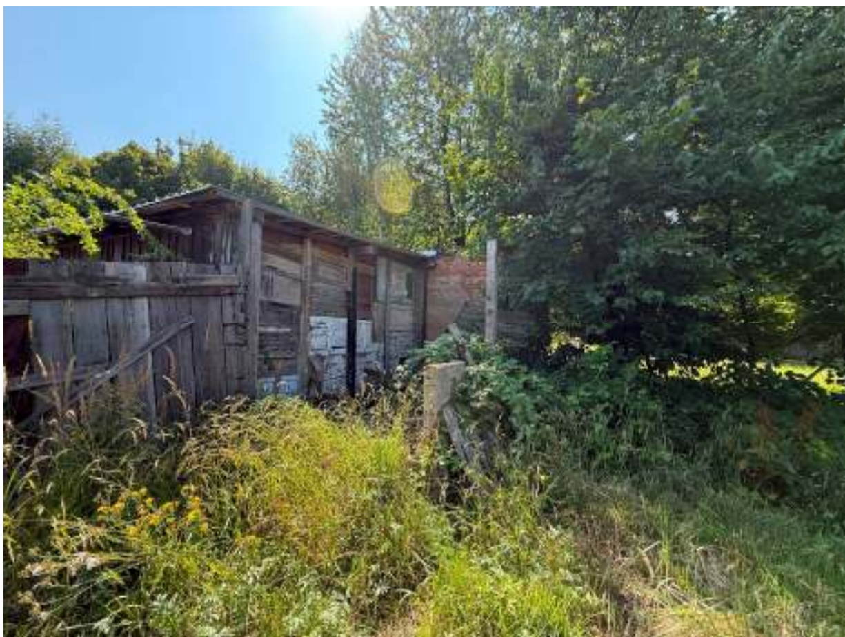
Zdj.12. Widok pozostałości po dawnej zabudowie przeznaczonych do wyburzenia.
