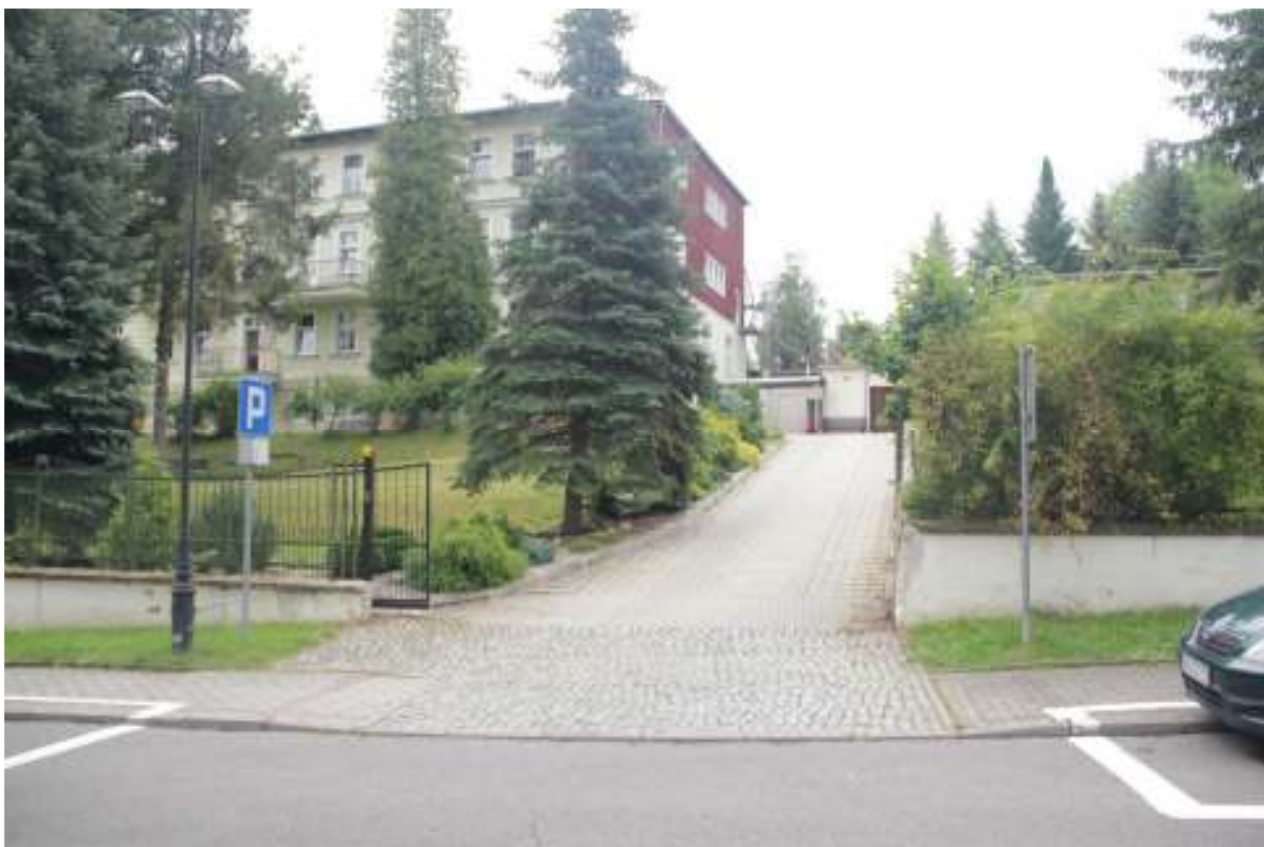
Zdj.7. Wjazd na działkę nr 1859/11 z ul. Parkowej od strony zachodniej (widoczna istniejąca brama przesuwna do zachowania).
