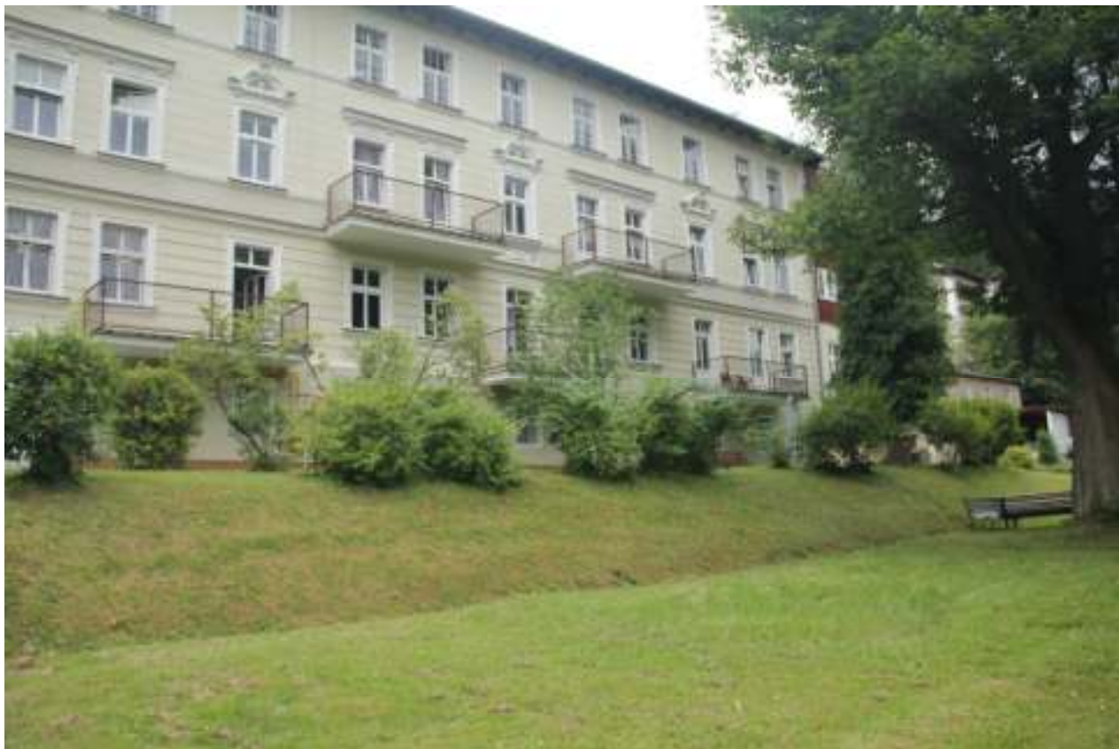
Zdj.6. Widok terenu przed budynkiem ZOL (1).
