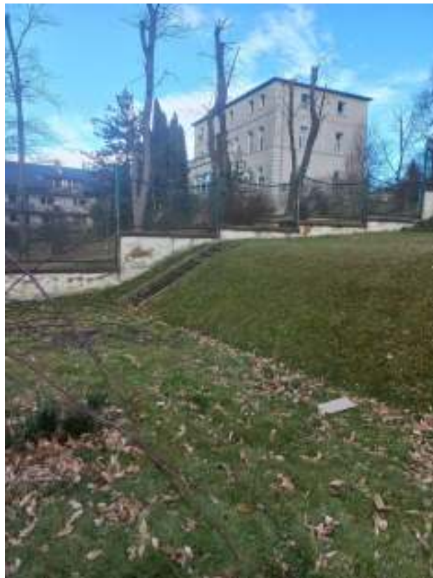
Zdj. 2. Widok ogrodzenia przy schodach terenowych od strony północnej (widok z działki 1859/11).
