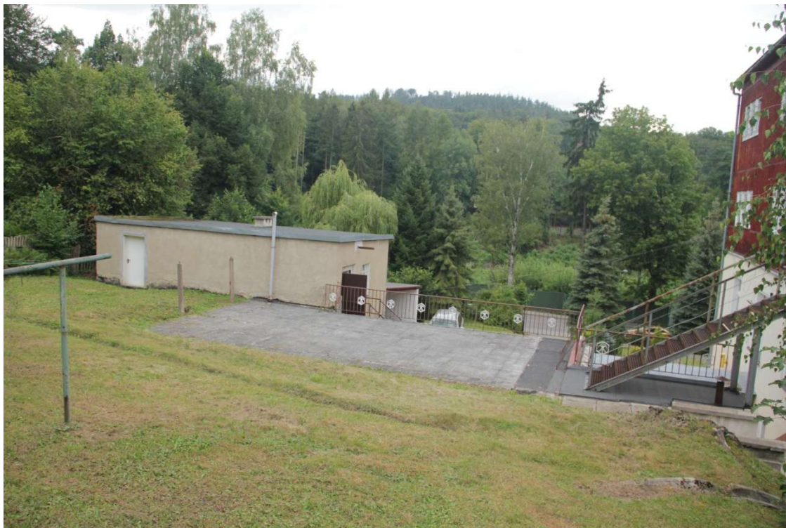
Zdj.10. Widok terenu za budynkiem ZOL z tarasem widokowym nad budynkiem gospodarczym.
