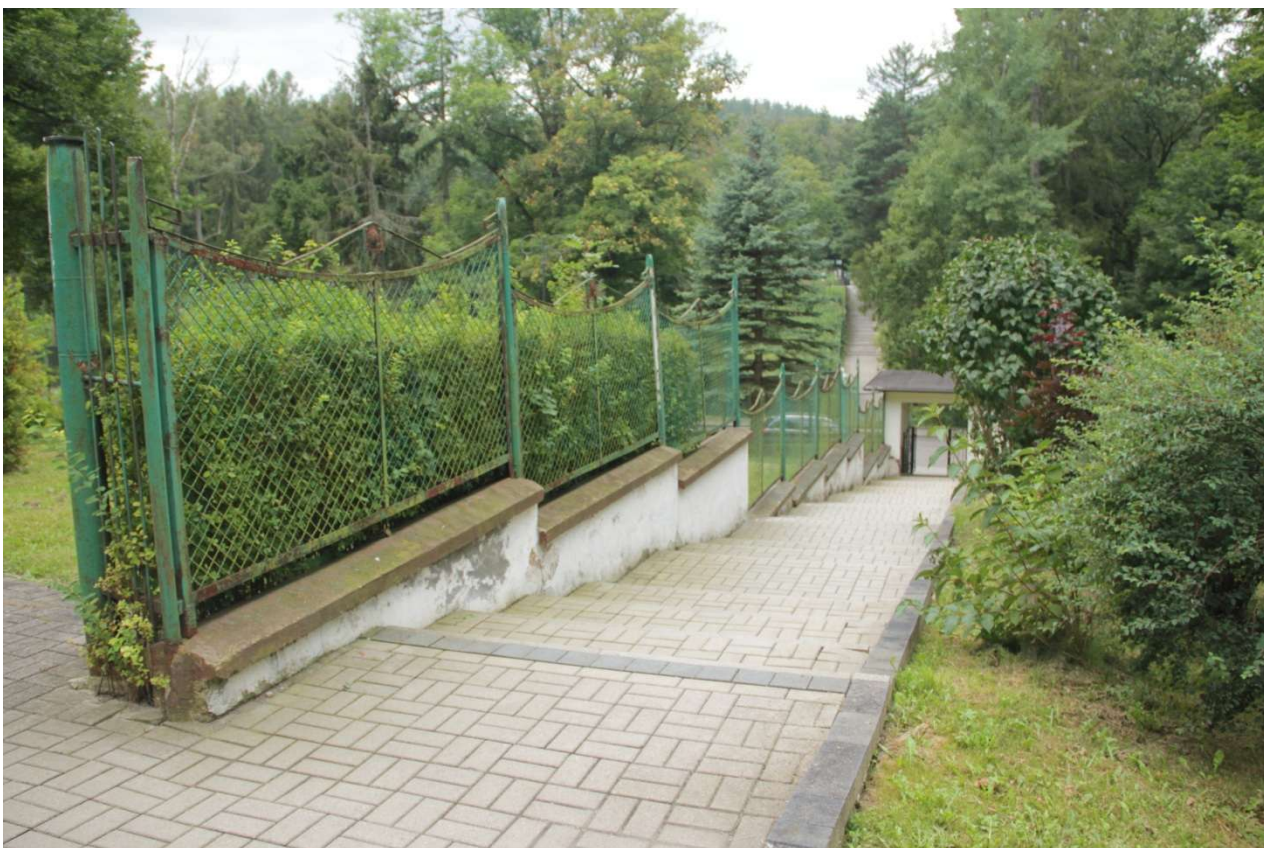
Zdj. 3. Widok ogrodzenia przy schodach terenowych od strony północnej (widok z działki 1859/10).
