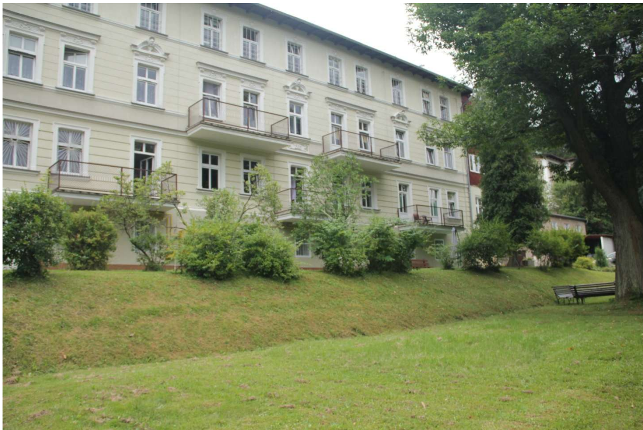
Zdj.6. Widok terenu przed budynkiem ZOL (1).
