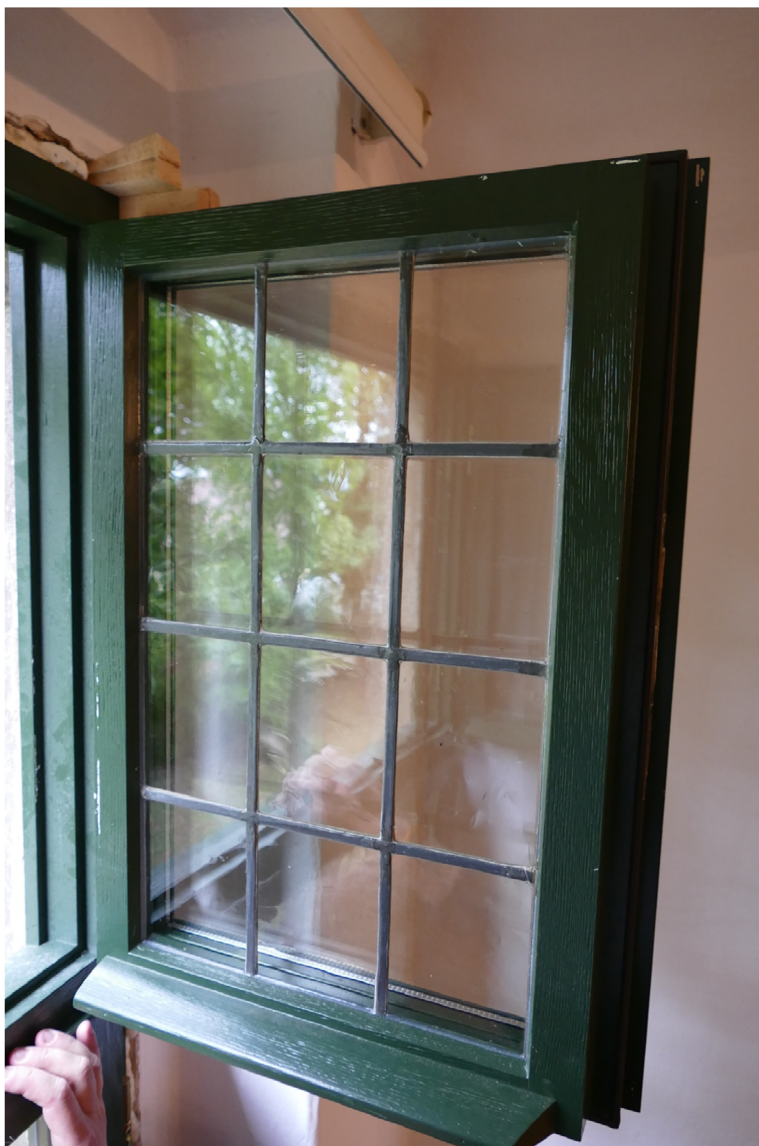
Fot. 36 Skrzydło nowego okna, wymienionego w 2024 r.
