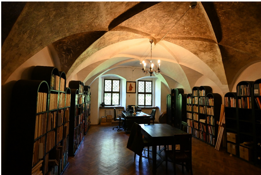
Fot. 24 Widok pomieszczenia nr D/0/104
