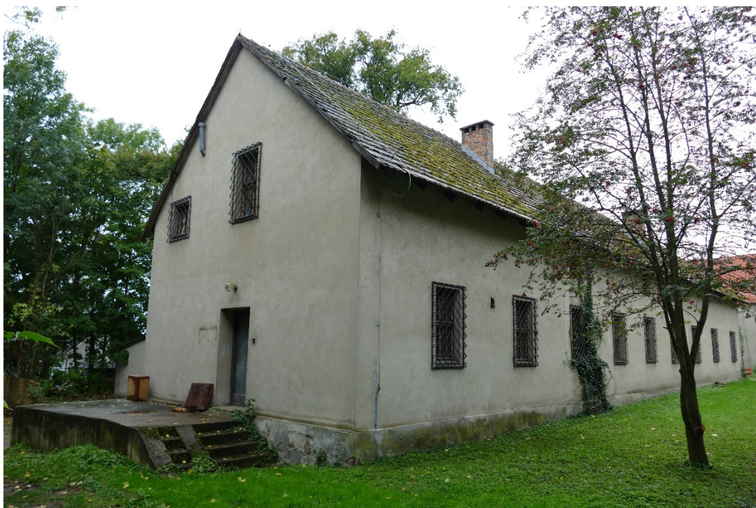
Fot. 38 Budynek administracyjny, elewacja południowo-wschodnia oraz północno-wschodnia
