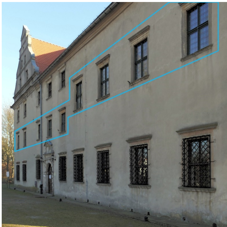
Fot. 1 Elewacja północna, na której oznaczono 9 okien, wymienionych w roku 2024.
