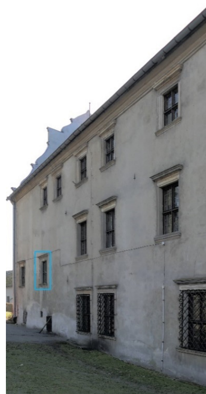
Fot. 2 Elewacja wschodnia z oznaczeniem okna wymienionego w 2024 r.
