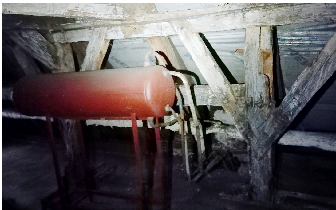
Fot. 17 Poddasze nieużytkowe - naczynie wyrównawcze do centralnego ogrzewania
