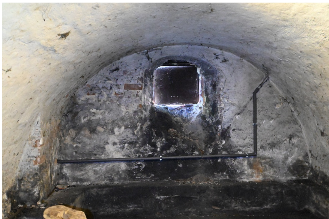
Fot. 9 Pomieszczenie gospodarcze nr D/0/002
