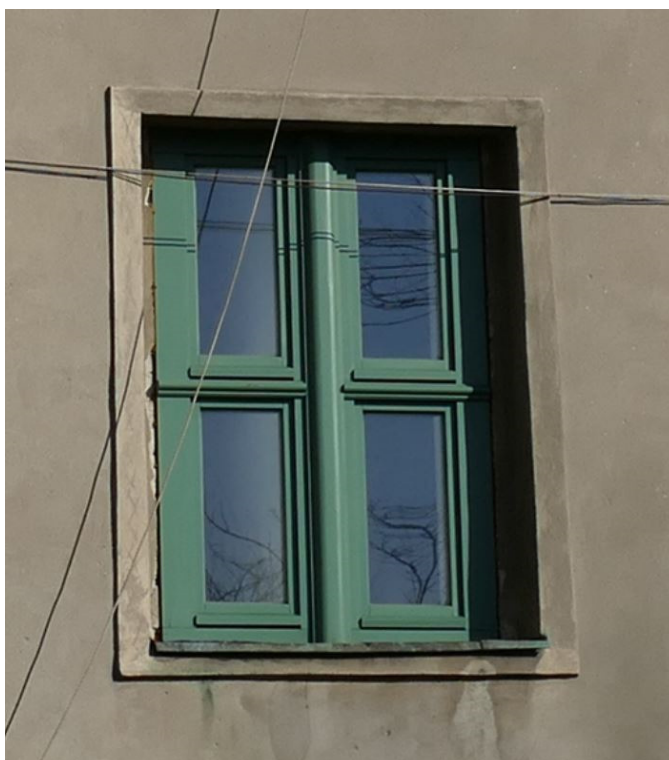
Fot. 5 Okno w łazience, poza zakresem opracowania
