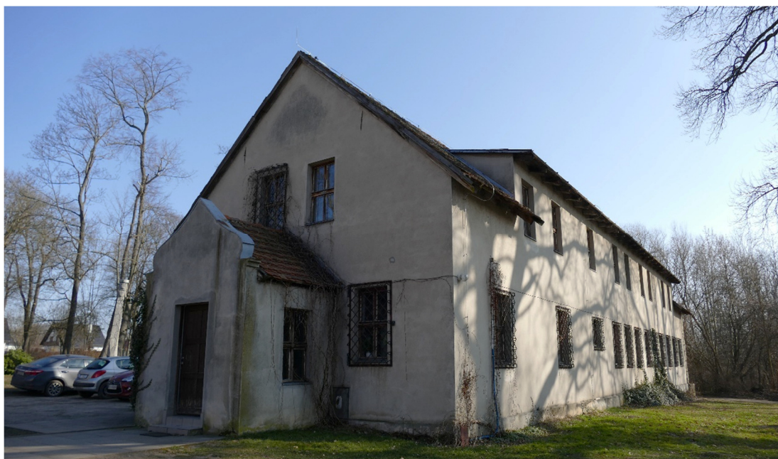
Fot. 37 Budynek administracyjny, elewacja północno-zachodnia oraz południowo-zachodnia
