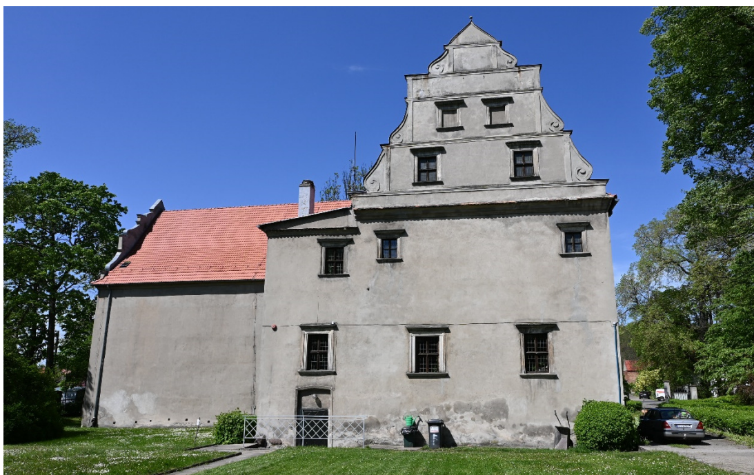
Fot. 2 Budynek dworu, elewacje południowe
