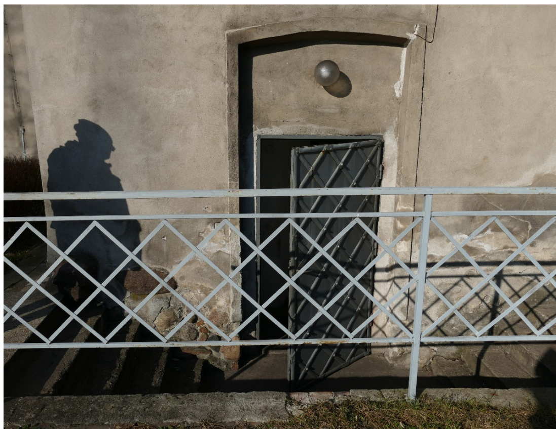
Fot. 8 Wejście techniczne w elewacji południowej, skrzydła wschodniego
