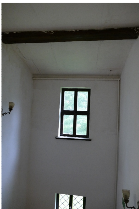
Fot. 43 Konstrukcja poddasza, ponad schodami
