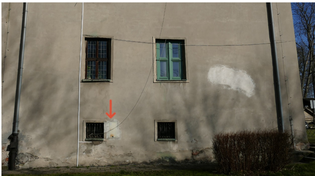
Fot. 7 Szafka elektryczna w elewacji zachodniej, skrzydła wschodniego
