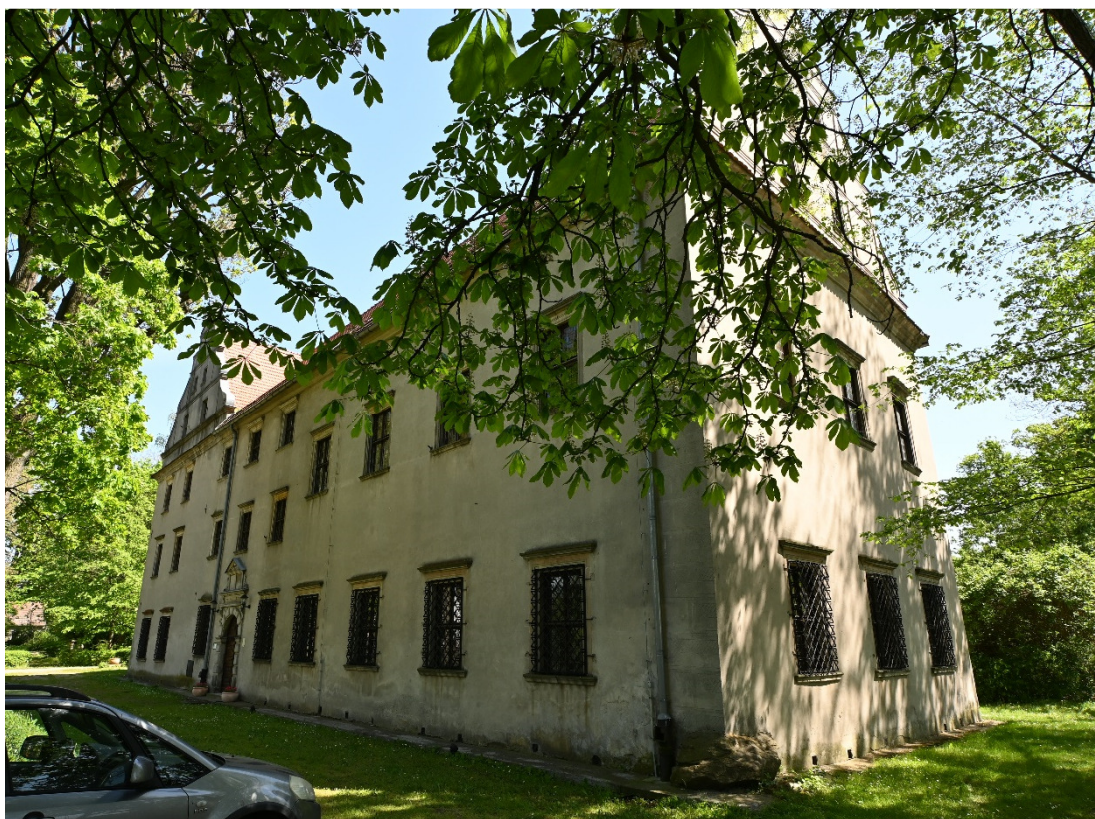
Fot. 3 Budynek dworu, elewacja północna i zachodnia
