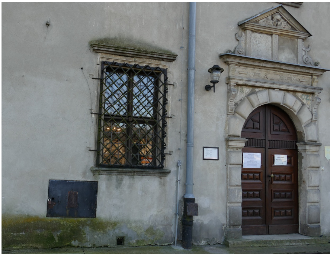
Fot. 6 Widok elewacji, przy wejściu głównym, z lewej strony szafka elektryczna
