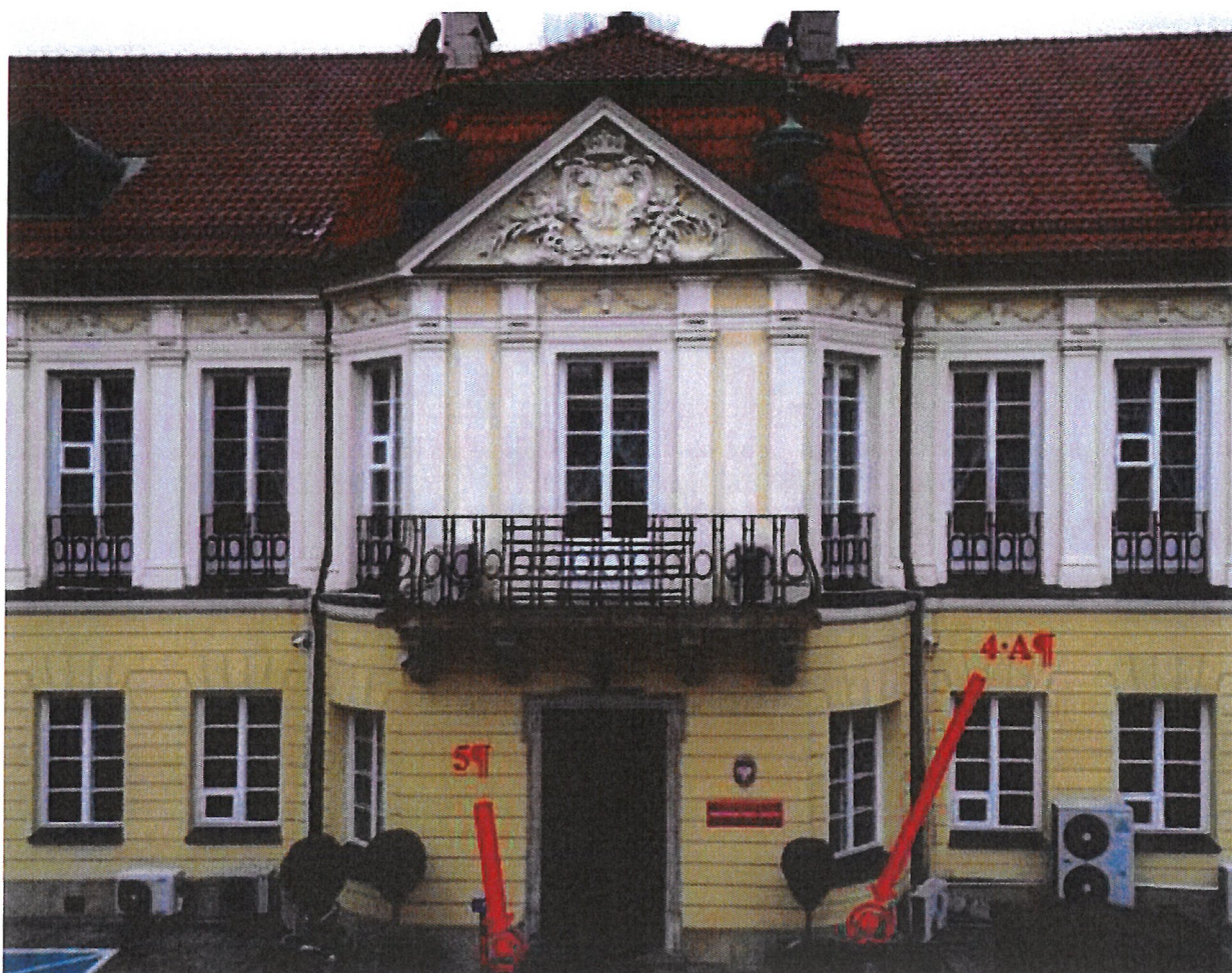
Fot. 102. Elewacja ryzalitu korpusu głównego od strony dziedzińca. Miejsca pobrania próbek nr 4 A i nr 5.
