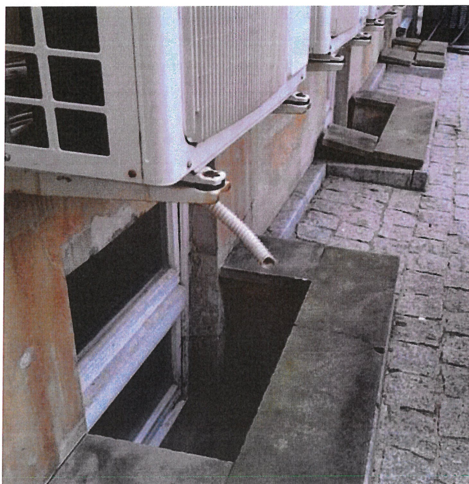
Fot. 56. Ta sama studzienka, widok na stan podłoża pod nieprzymocowaną płytą piaskowca
