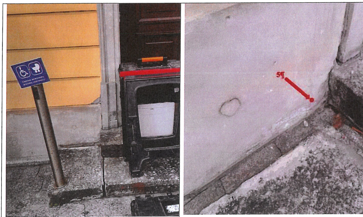
Fot. 105 i 106. Elewacja ryzalitu korpusu głównego od strony dziedzińca, po lewej stronie portalu. Zbliżenie na miejsce pobrania próbki nr 5.
