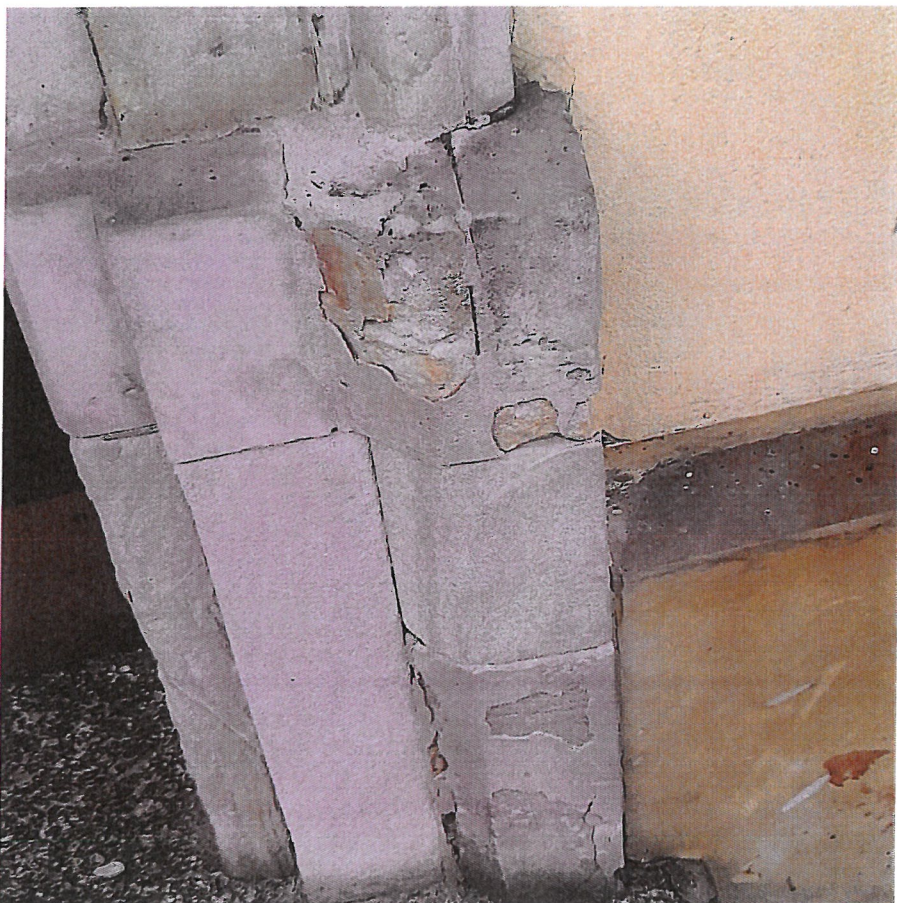
Fot. 65. Zbliżenie na część cokołową portalu po prawej stronie drzwi. Widoczna degradacja powierzchni piaskowca, ubytki kamienia i stare uzupełnienia kwalifikujące się do wymiany
