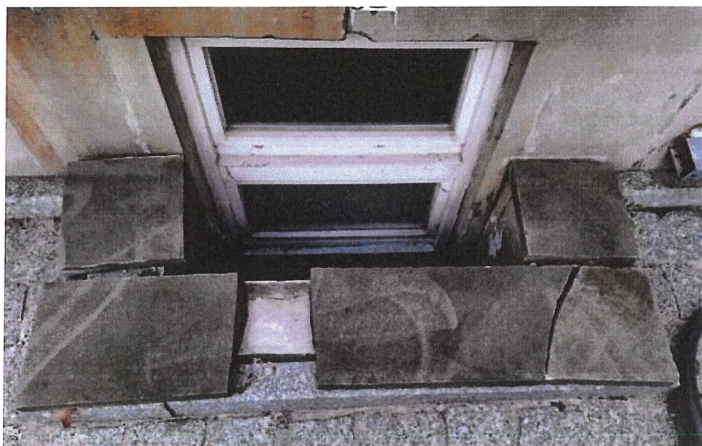
Fot. 55. Kamienne obłożenie studzienki położonej najbliżej korpusu głównego.
