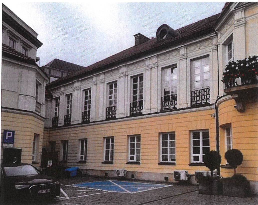
Fot. 10. Korpus główny od strony dziedzińca, skrzydło zachodnie.
