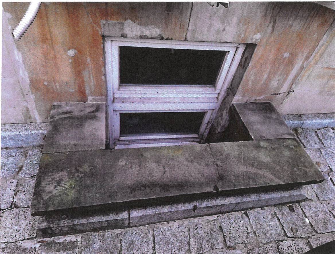
Fot. 58. Studzienka najbliższa wejściu nr 1. Jest to jedyna z trzech studzienek na tej elewacji, która ma przymocowane płyty kamienia. Pomimo tego mocowania, widoczne są pęknięcia i ubytek kamienia na jego krawędzi, a także silne zabrudzenie i porażenie mikrobiologiczne.
