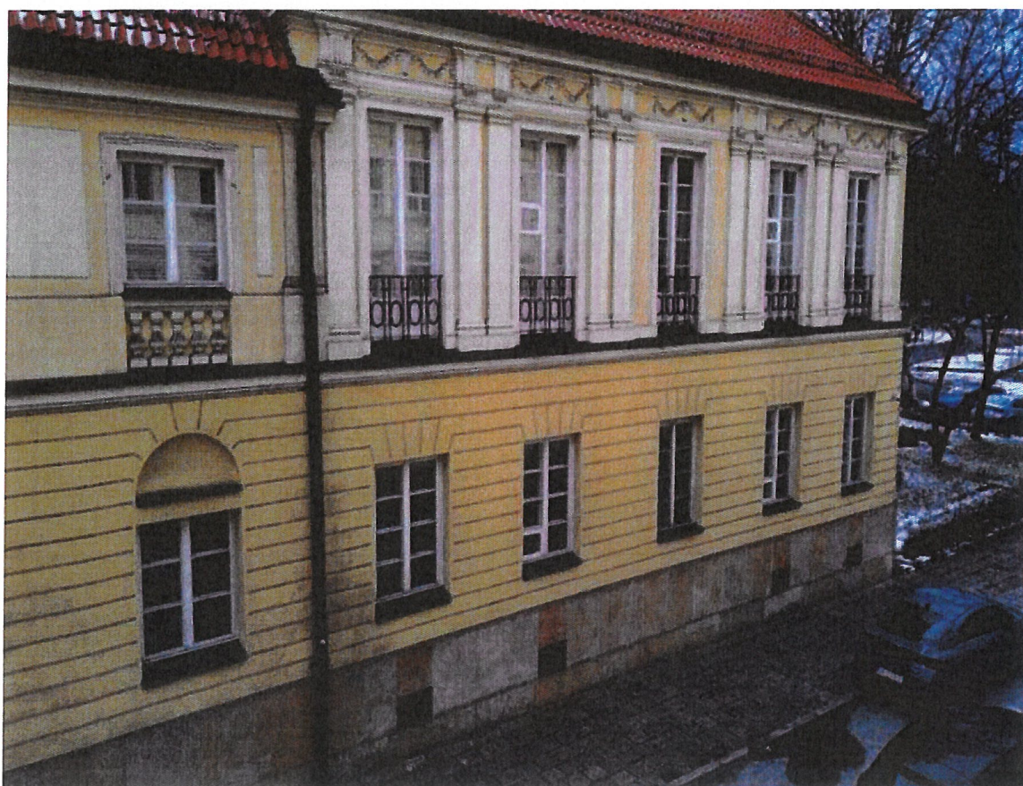
Fot. 23. Elewacja boczna korpusu głównego od strony ul. Nowy Przejazd.
