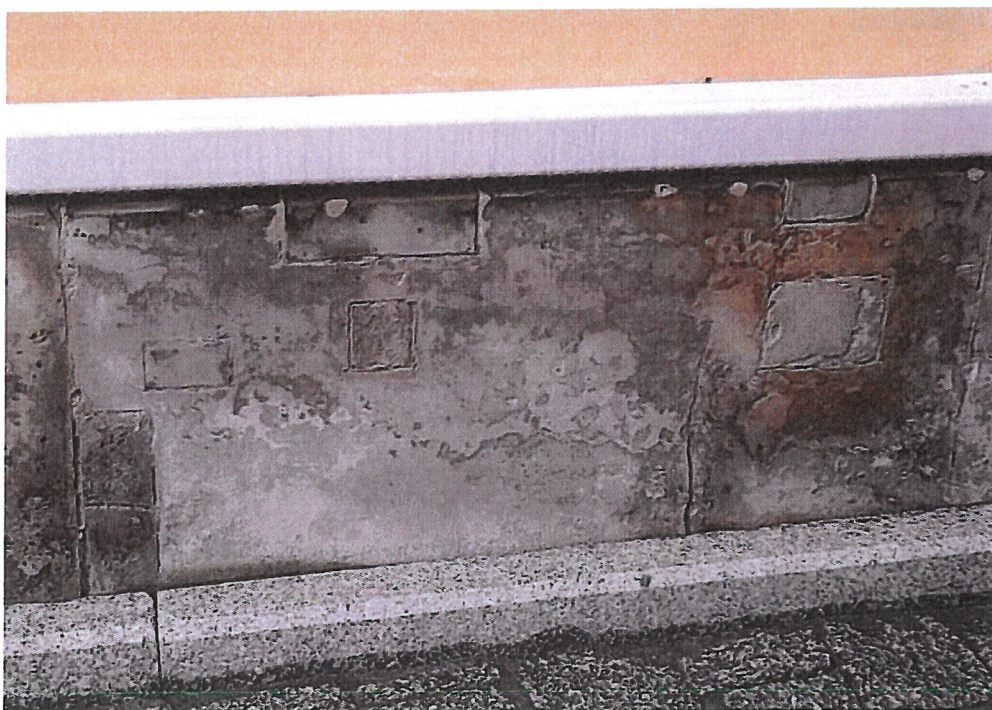
Fot. 28. Piaskowcowy cokół elewacji od strony dziedzińca. Widoczna silna degradacja powierzchniowej warstwy kamienia.
