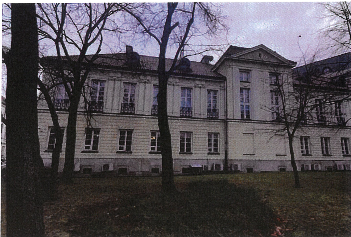
Fot. 24. Korpus główny, elewacja północna, od strony Trasy W-Z.
