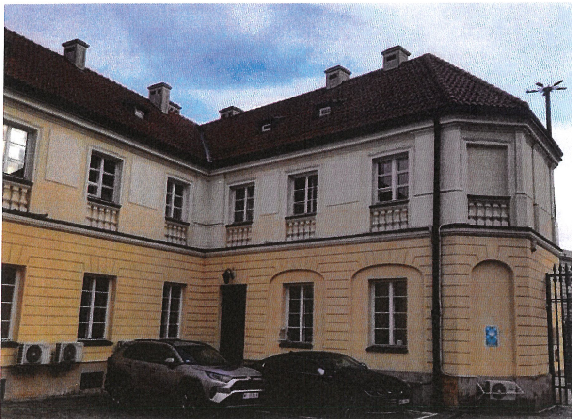
Fot. 14. Oficyna wschodnia od strony dziedzińca, Drzwi boczne nr 5 w narożu oficyny.
