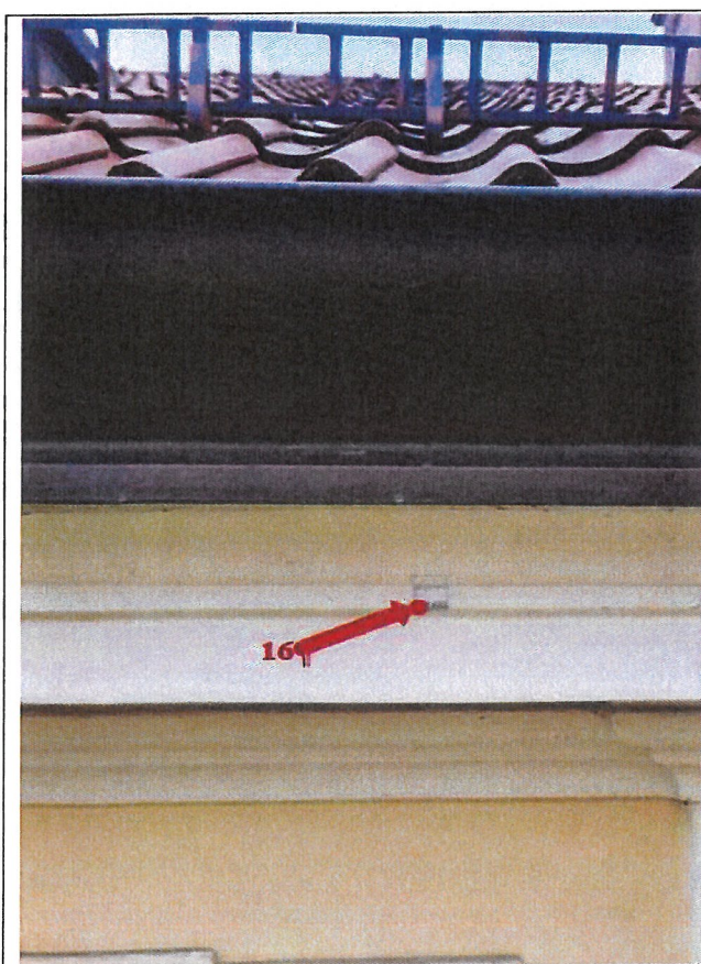
Fot. 149. Zbliżenie na miejsce wykonania odkrywki nr 16.
