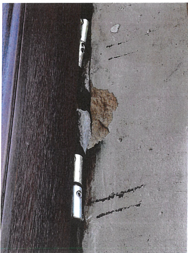
Fot. 65. Zbliżenie na część cokołową portalu po prawej stronie drzwi. Widoczna degradacja powierzchni piaskowca, ubytki kamienia i stare uzupełnienia kwalifikujące się do wymiany
