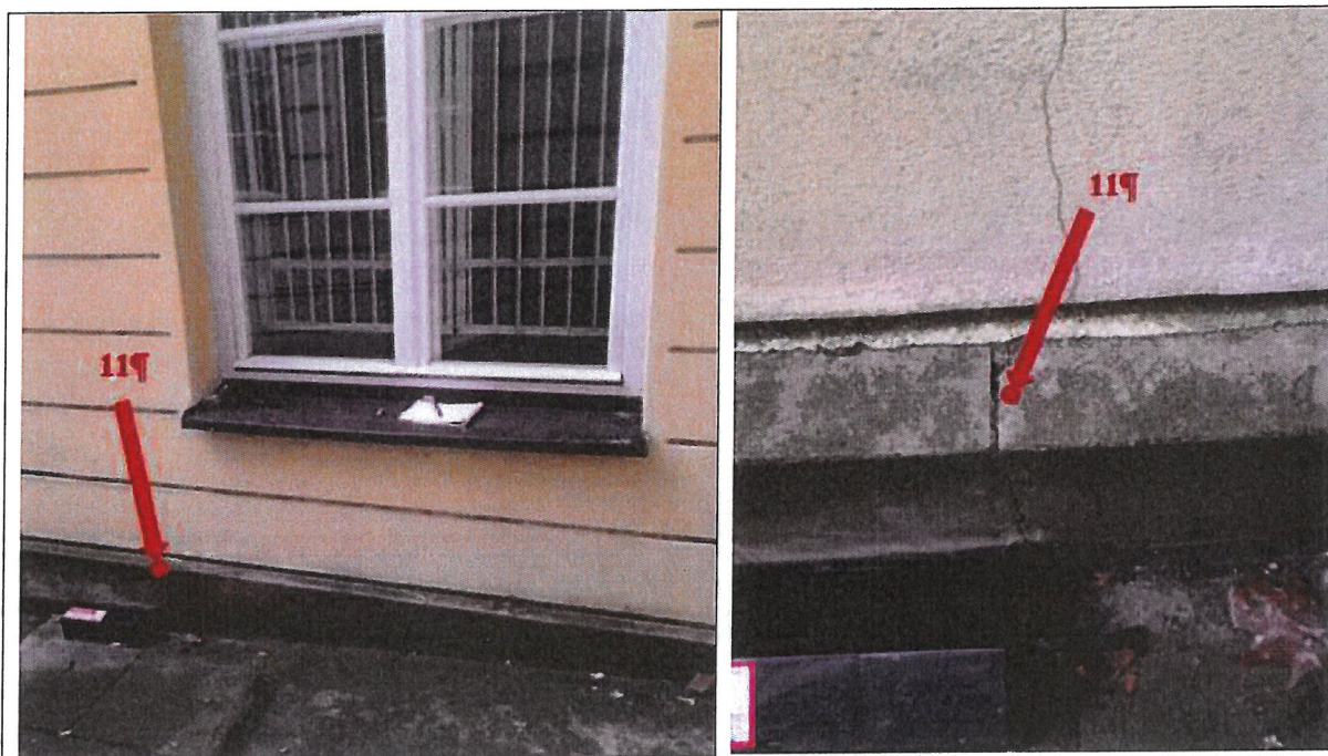
Fot. 135 i 136. Elewacja zewnętrzna oficyny zachodniej, dochodząca do ściany nowego budynku starego ratusza. Zbliżenie na miejsce pobrania próbki nr 11.
