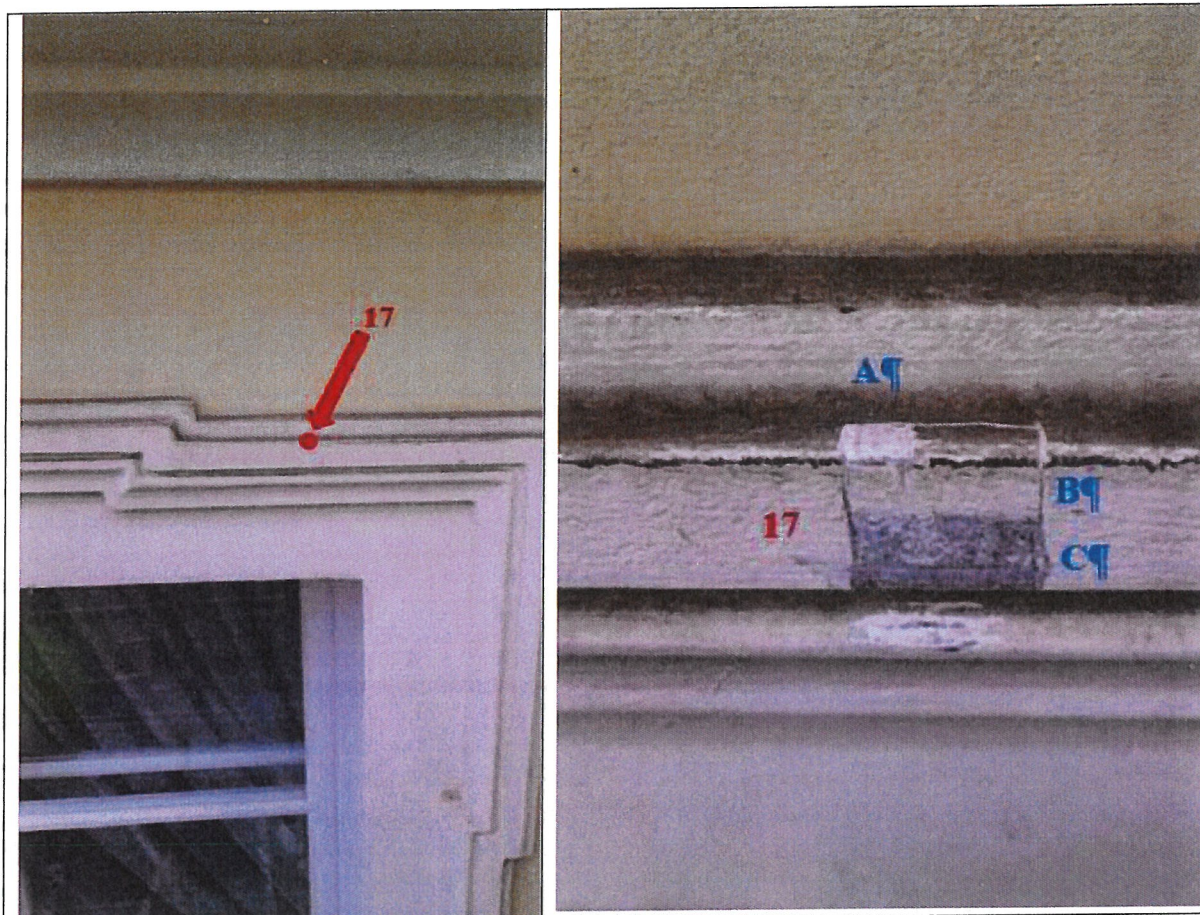
Fot. 151. Zbliżenie na miejsce wykonania odkrywki nr 17.
