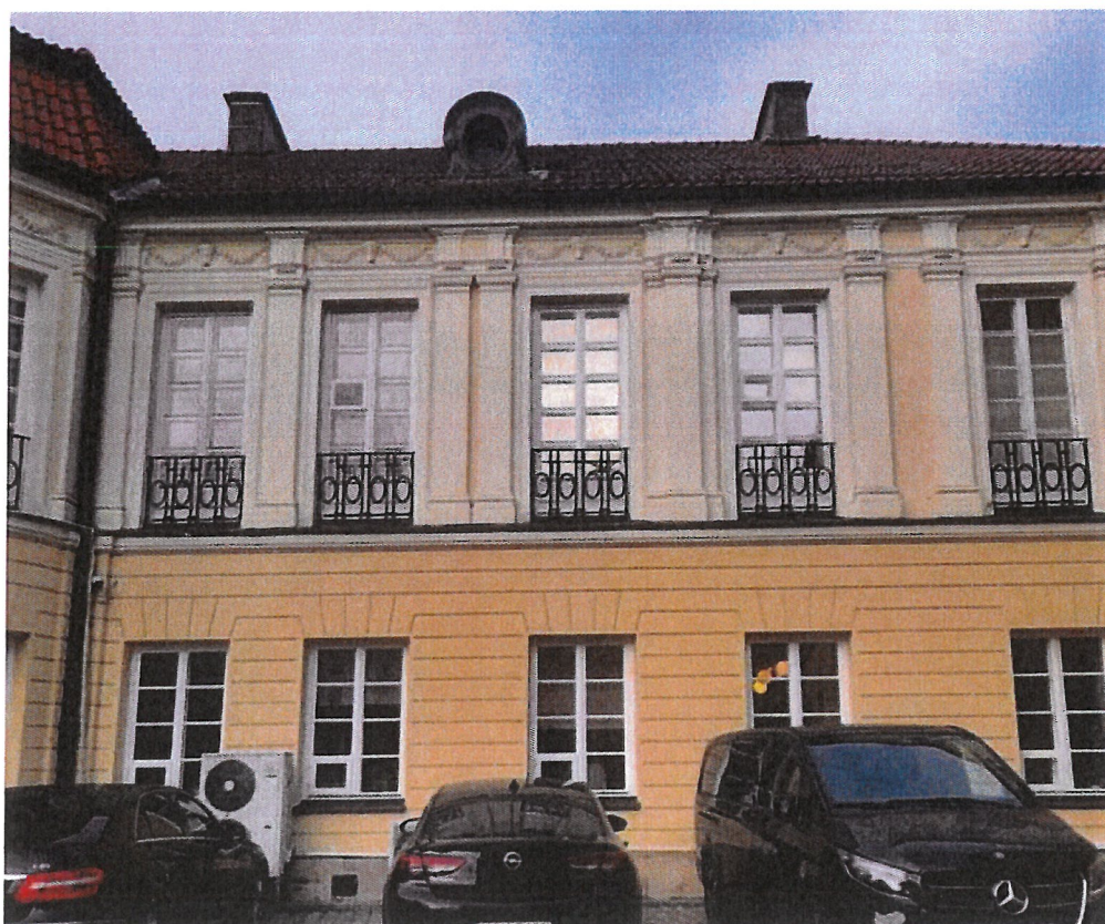
Fot. 17. Korpus główny od strony dziedzińca, skrzydło wschodnie.
