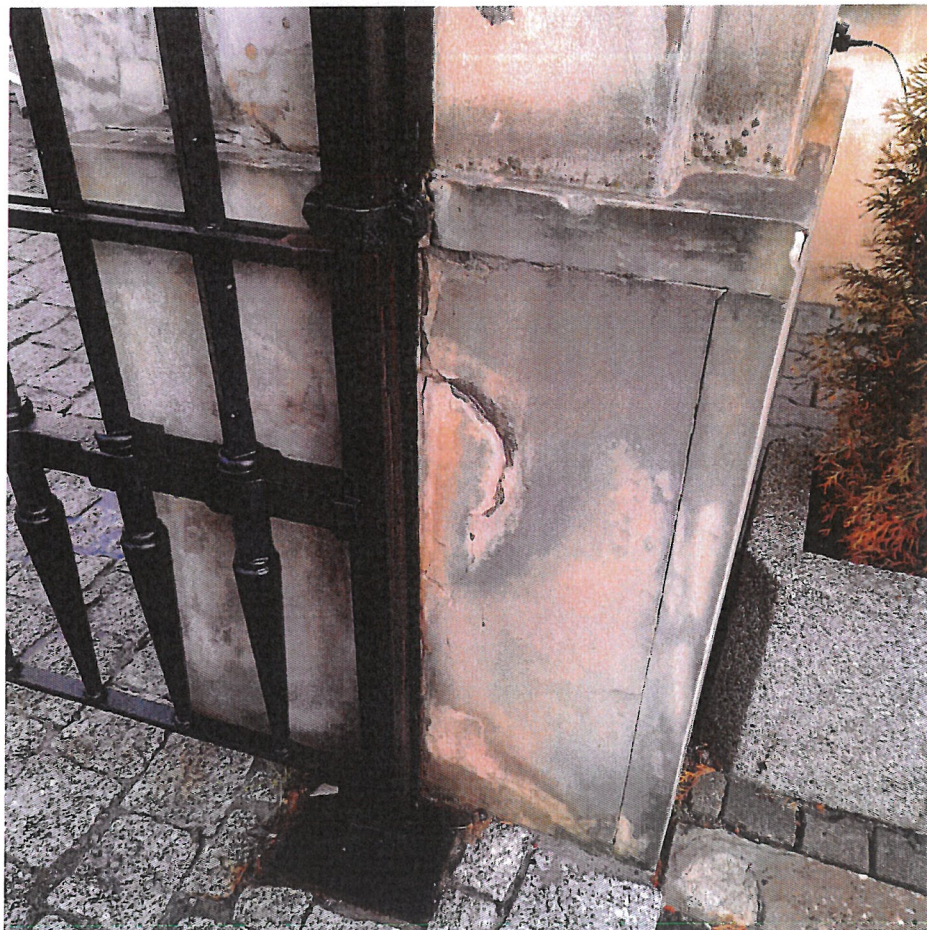
Fot. 51. Filar wschodni. Widok od strony prześwitu bramnego.
