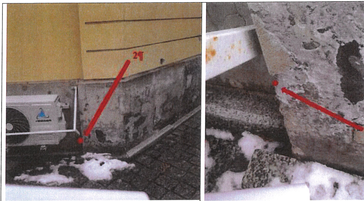
Fot. 94 i 95. Elewacja oficyny wschodniej od strony dziedzińca, cokół od strony furtki. Zbliżenie na miejsce pobrania próbki nr 2.
