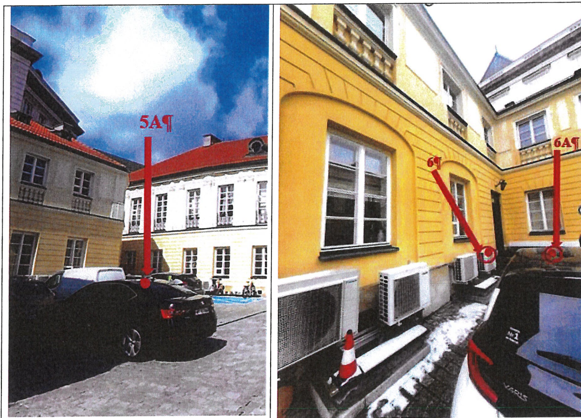
Fot. 107 i 108. Elewacja zach. skrzydła korpusu głównego oraz oficyny zach. od strony dziedzińca. Miejsca pobrania próbek nr 5A, 6 i 6A.
