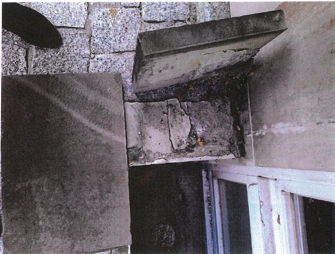
Fot. 56. Ta sama studzienka, widok na stan podłoża pod nieprzymocowaną płytą piaskowca
