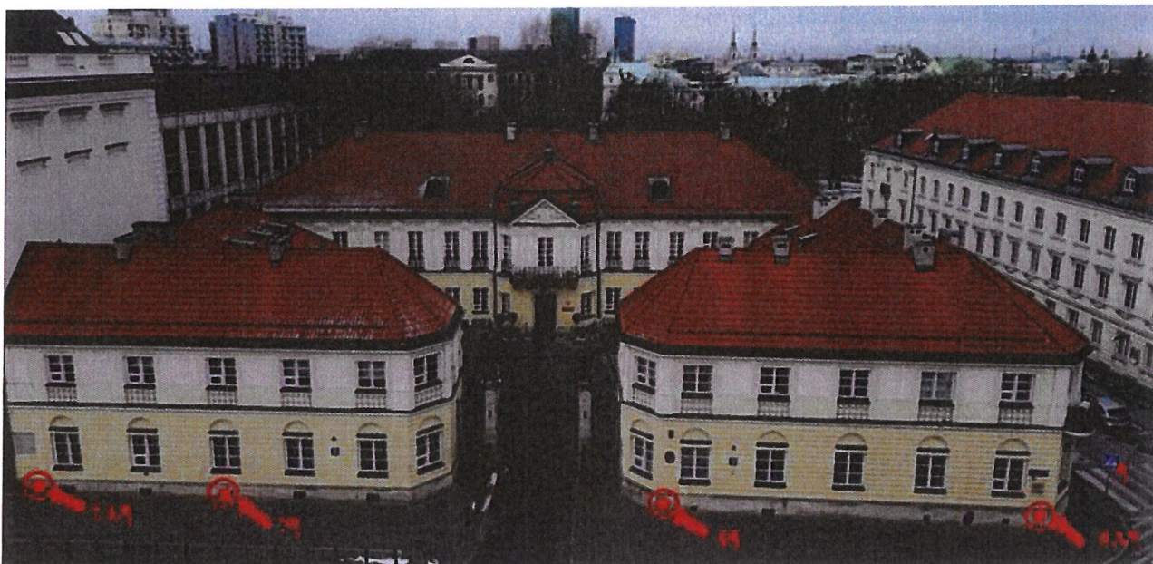
Fot. 114. Widok na elewację południową oficyn od strony ul. Senatorskiej, miejsca pobrania próbek nr 7 i 7A oraz 8 i 8A.
