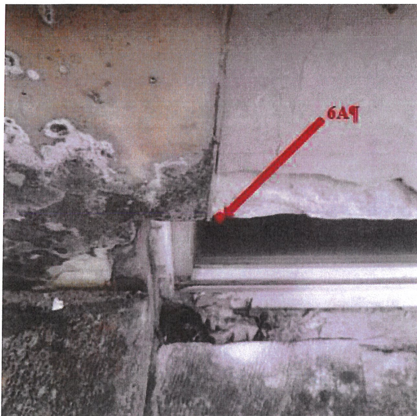
Fot. 113. Elewacja oficyny zach. od strony dziedzińca, na lewo od drzwi nr 1. Zbliżenie na miejsce pobrania próbki nr 6A.
