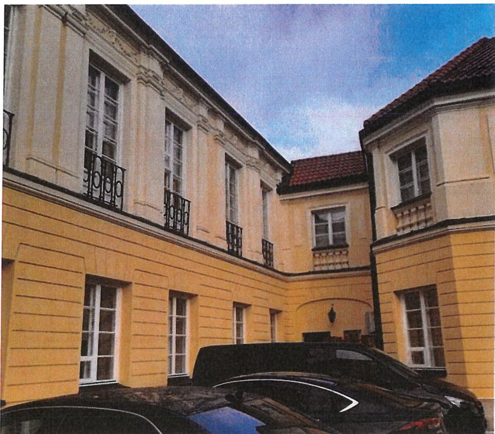
Fot. 16. Łącznik oficyny wschodniej z korpusem głównym od strony dziedzińca.
