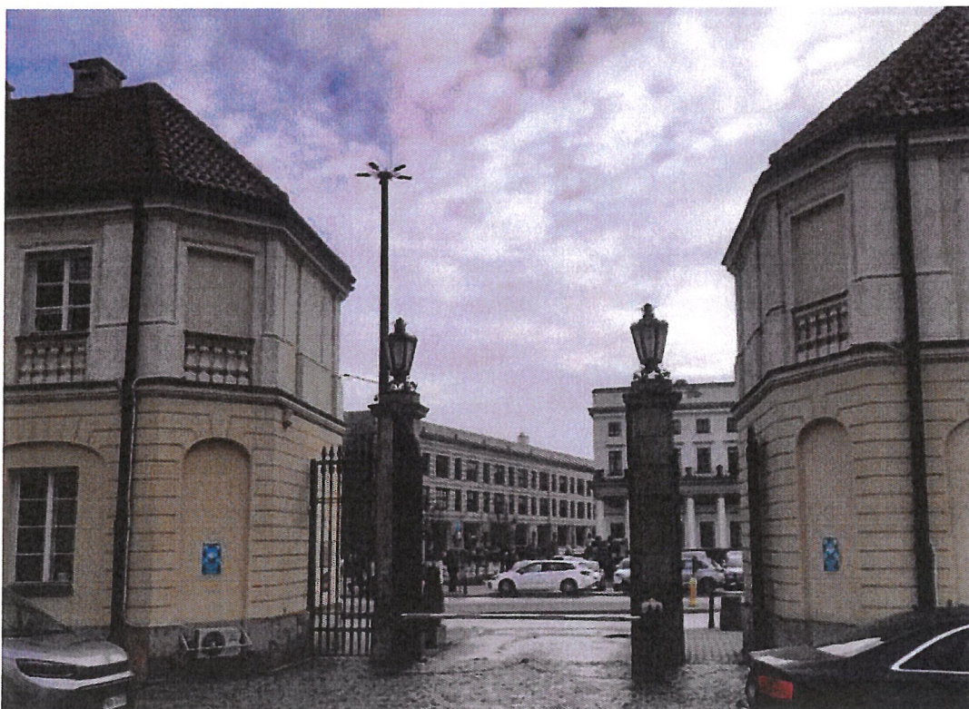
Fot. 13. Narożniki oficyn i brama wjazdowa od strony dziedzińca.
