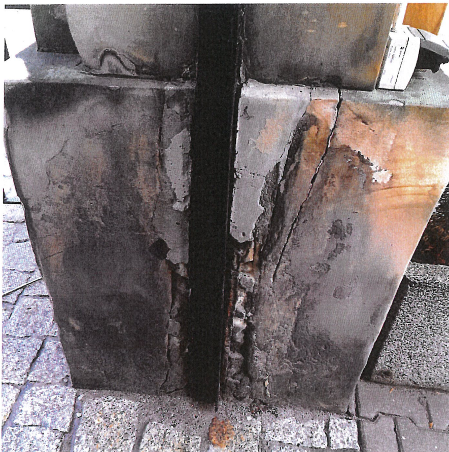
Fot. 50. Filar zachodni. Widok od strony prześwitu bramnego.
