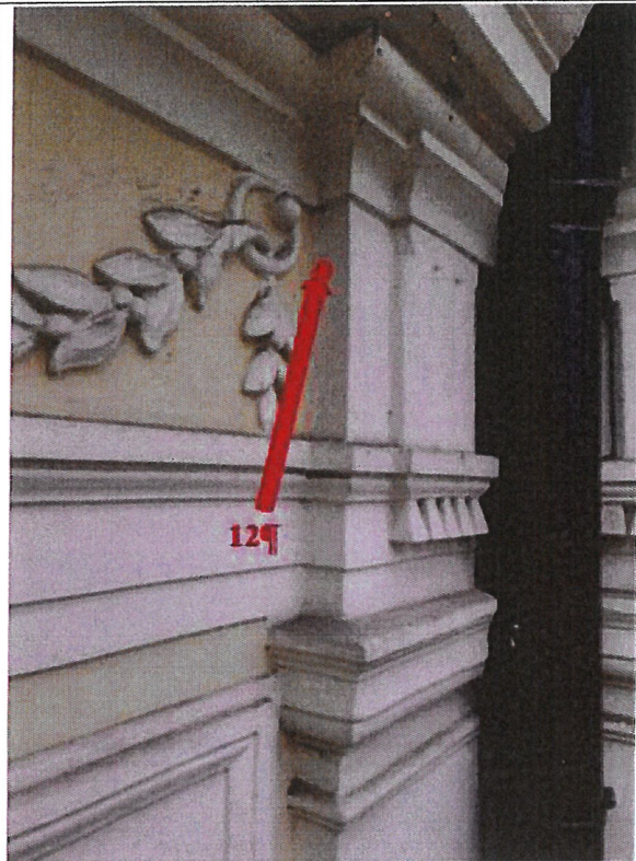
Fot. 140. Zbliżenie na miejsce wykonania odkrywki nr 12.
