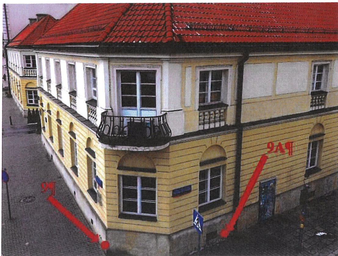
Fot. 123. Widok na narożnik południowo-wschodni i miejsca pobrania próbek nr 9 i 9A z cokołu elewacji oficyny wschodniej wzdłuż ul. Nowy Przejazd.
