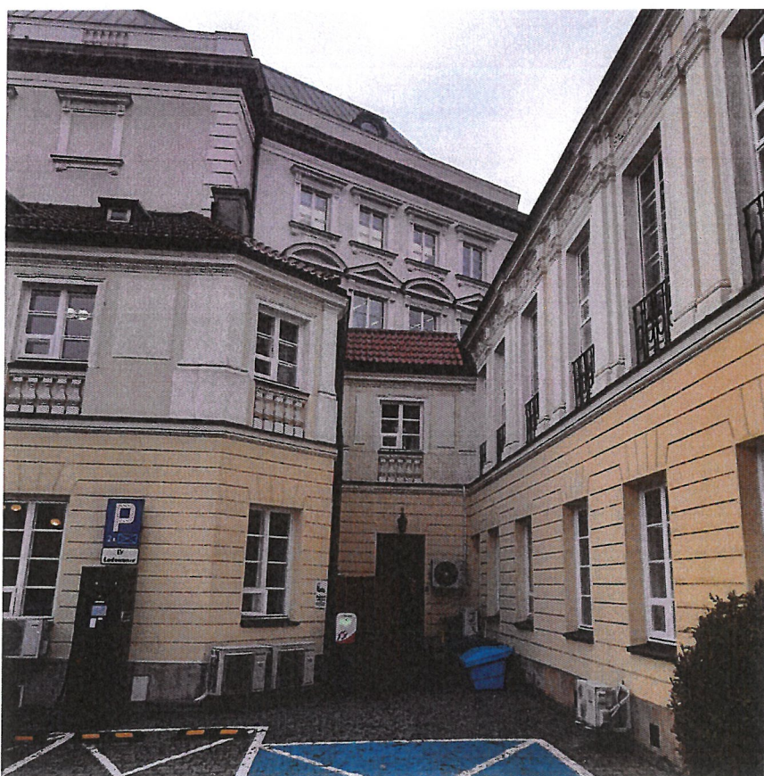
Fot. 11. Drzwi nr 2, w łączniku korpusu głównego z oficyną zachodnią. Z tyłu widoczny nowy budynek dawnego ratusza.
