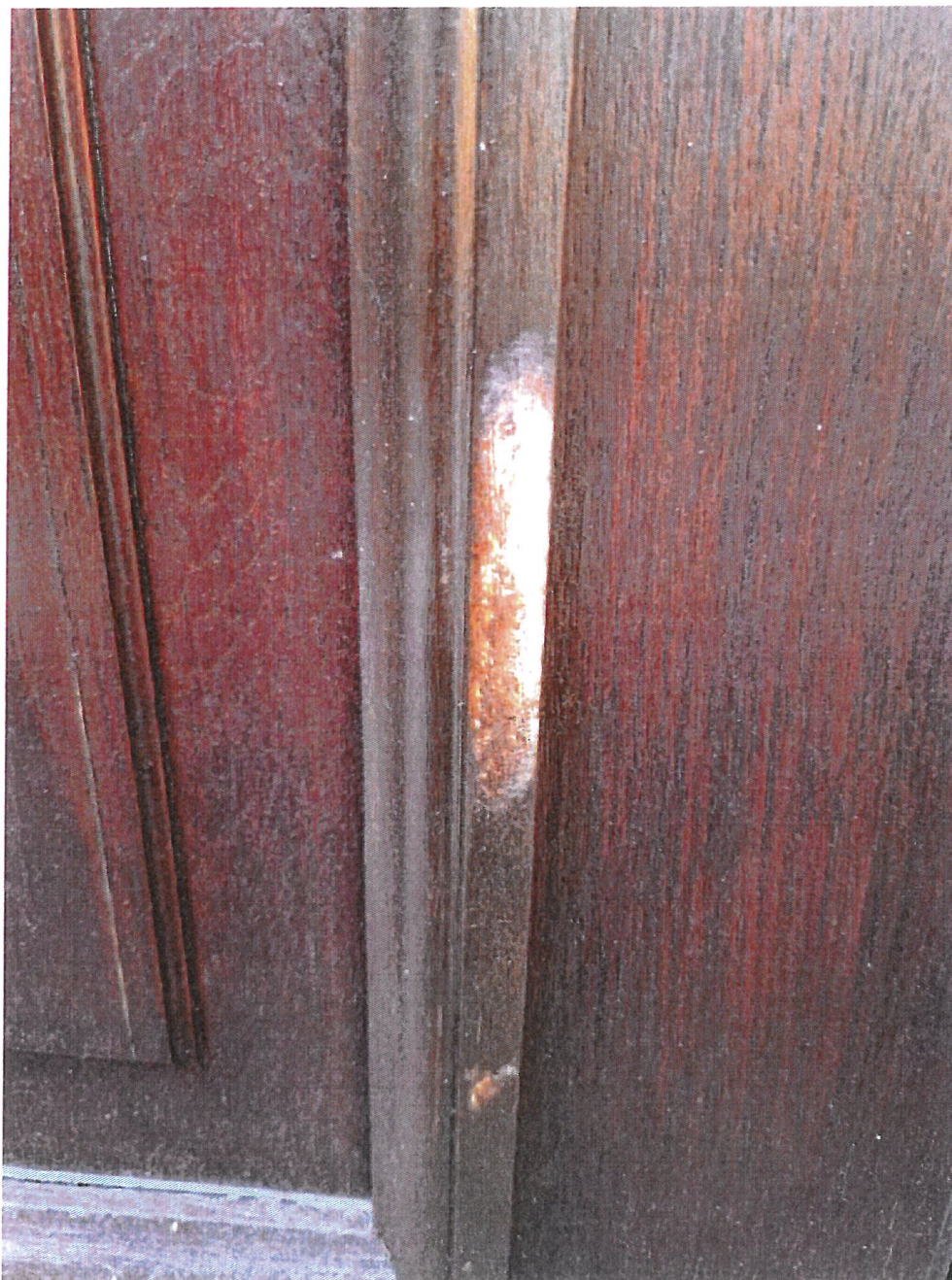
Fot. 70. Widoczne wytarcie warstwy lakieru i bejcy na ozdobnej listwie w dolnej części płyty drzwiowej.
