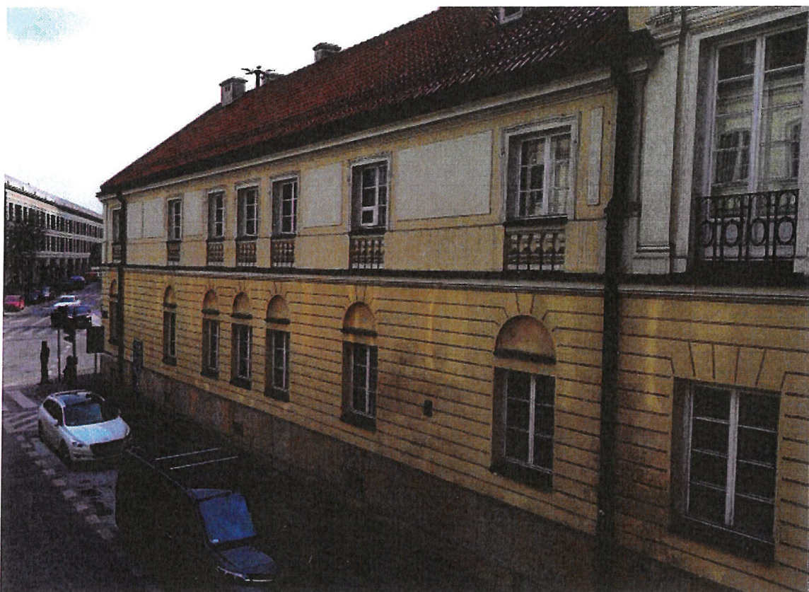
Fot. 22. Elewacja oficyny wschodniej od strony ul. Nowy Przejazd.
