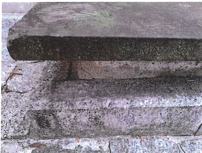
Fot. 58. Studzienka najbliższa wejściu nr 1. Jest to jedyna z trzech studzienek na tej elewacji, która ma przymocowane płyty kamienia. Pomimo tego mocowania, widoczne są pęknięcia i ubytek kamienia na jego krawędzi, a także silne zabrudzenie i porażenie mikrobiologiczne.
