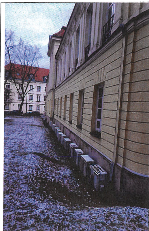
Fot. 137. Elewacja północna, widoczny spadek gruntu w kierunku muru.
