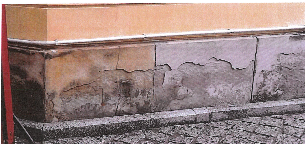
Fot. 28. Piaskowcowy cokół elewacji od strony dziedzińca. Widoczna silna degradacja powierzchniowej warstwy kamienia.
