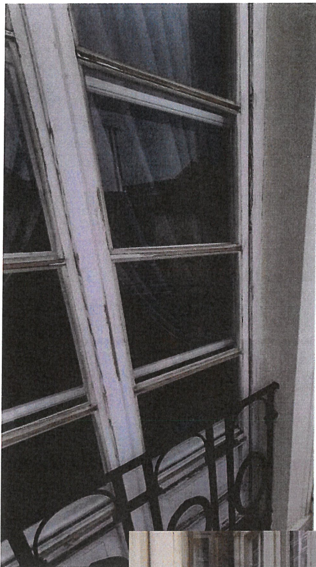
Fot. 73. Zbliżenie na stolarkę okienną porte-fenêtre pierwszego piętra korpusu głównego od strony dziedzińca.
