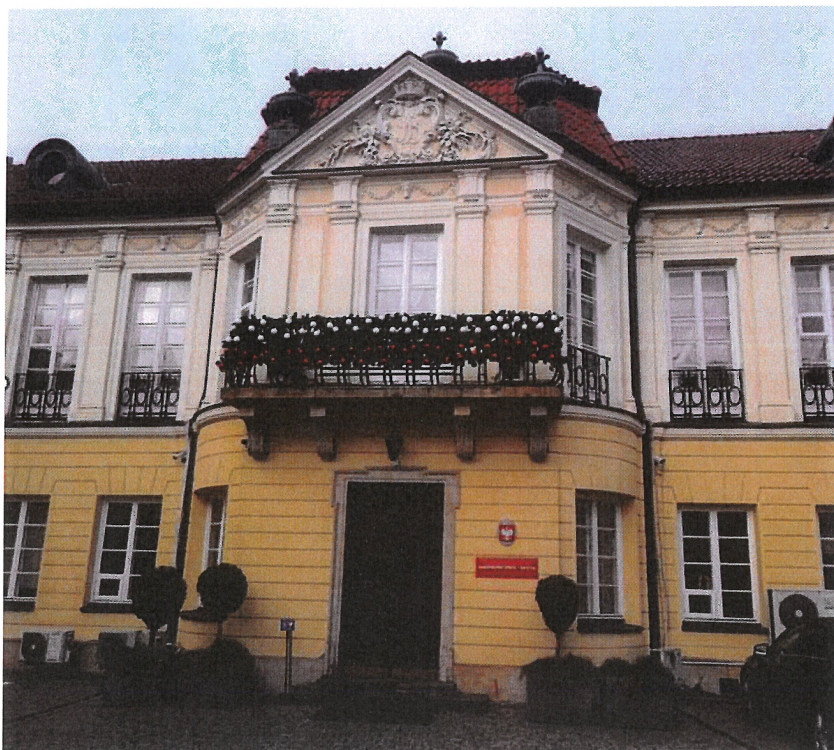
Fot. 9. Ryzalit frontowy z wejściem głównym do budynku.
