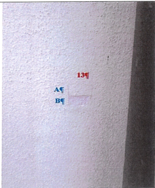
Fot. 143. Odkrywka nr 13. Kolejne warstwy: A – farba; B - zaprawa
