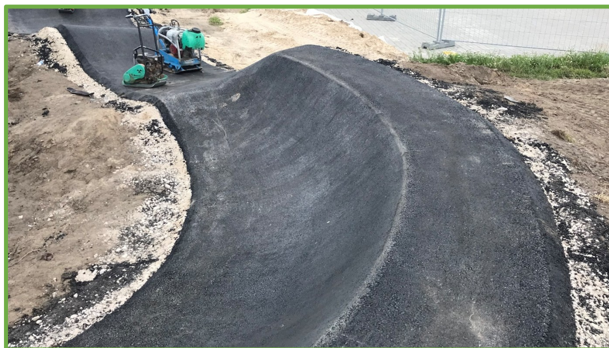
Prawidłowo wykonana nawierzchnia asfaltowa – jednorodna i gładka.
