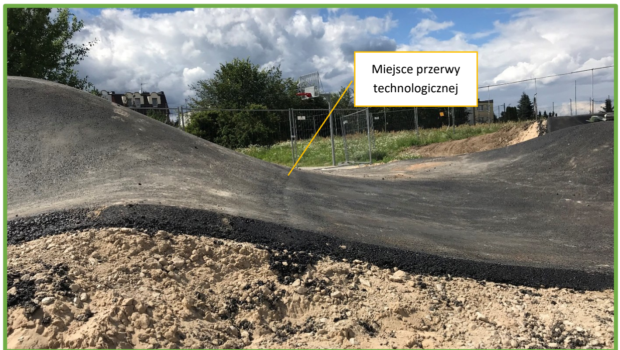
Prawidłowo wykonane połączenia – bez wyczuwalnych uskoków ani zmian profilu przeszkody.
