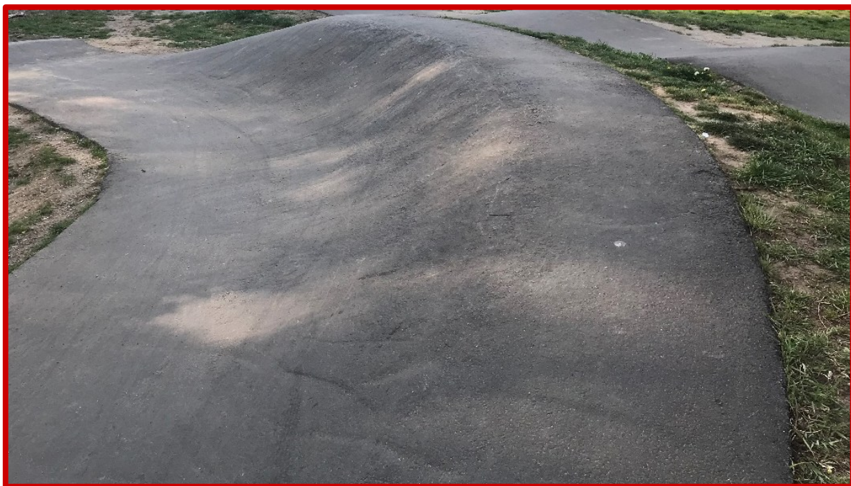
Nieprawidłowa powierzchnia nawierzchnia asfaltowa – nadmiernie chropowata z widocznymi rysami i nierównościami
