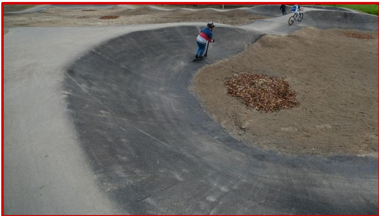
Nieprawidłowo wykonany zakręt o niejednostajnym promieniu, bez wyplaszczanej dolnej półki oraz niebędący w przekroju wycinkiem koła.
