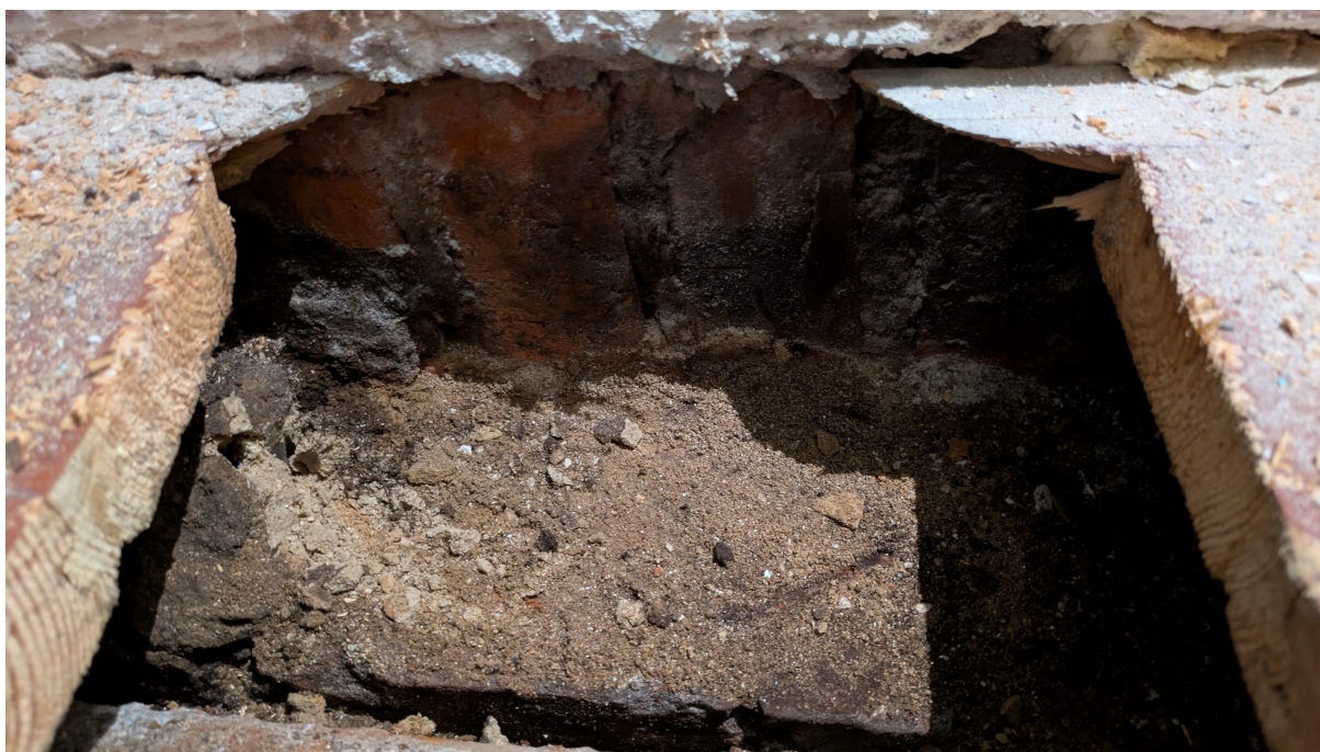
FOT. 4 Odkrywka przeprowadzona w posadzce lokalu - ślepy pułap i legary oparte ścianach ceglanych fundamentowych
