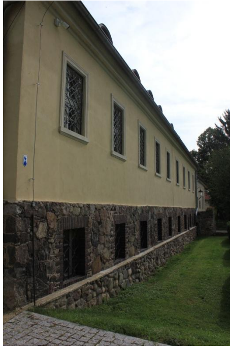
Zdjęcie miejsca wstępnie wytypowanego w którym ma być wykonana odkrywka fundamentów budynku dawnego starostwa.
