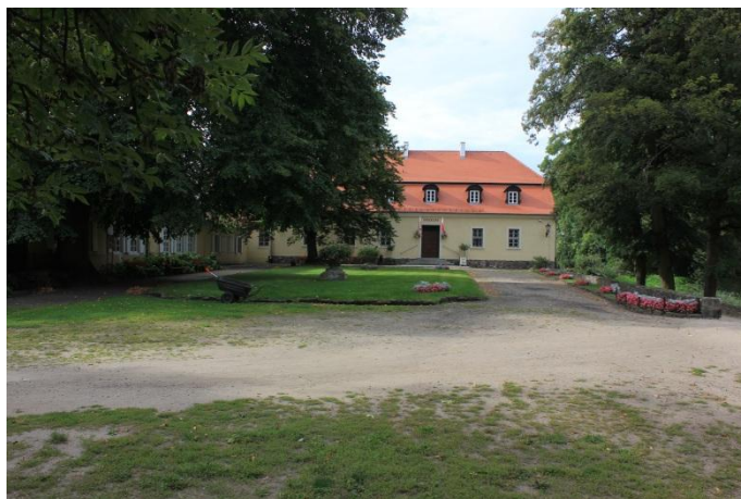
Zdjęcie dziedzińca honorowego – terenu objętego opracowaniem zagospodarowania terenu w zakresie projektu instalacji nawadniania istniejącej zieleni oraz przebudowy istniejących ścieżek w zakresie utwardzenia ich warstwą mineralną.
