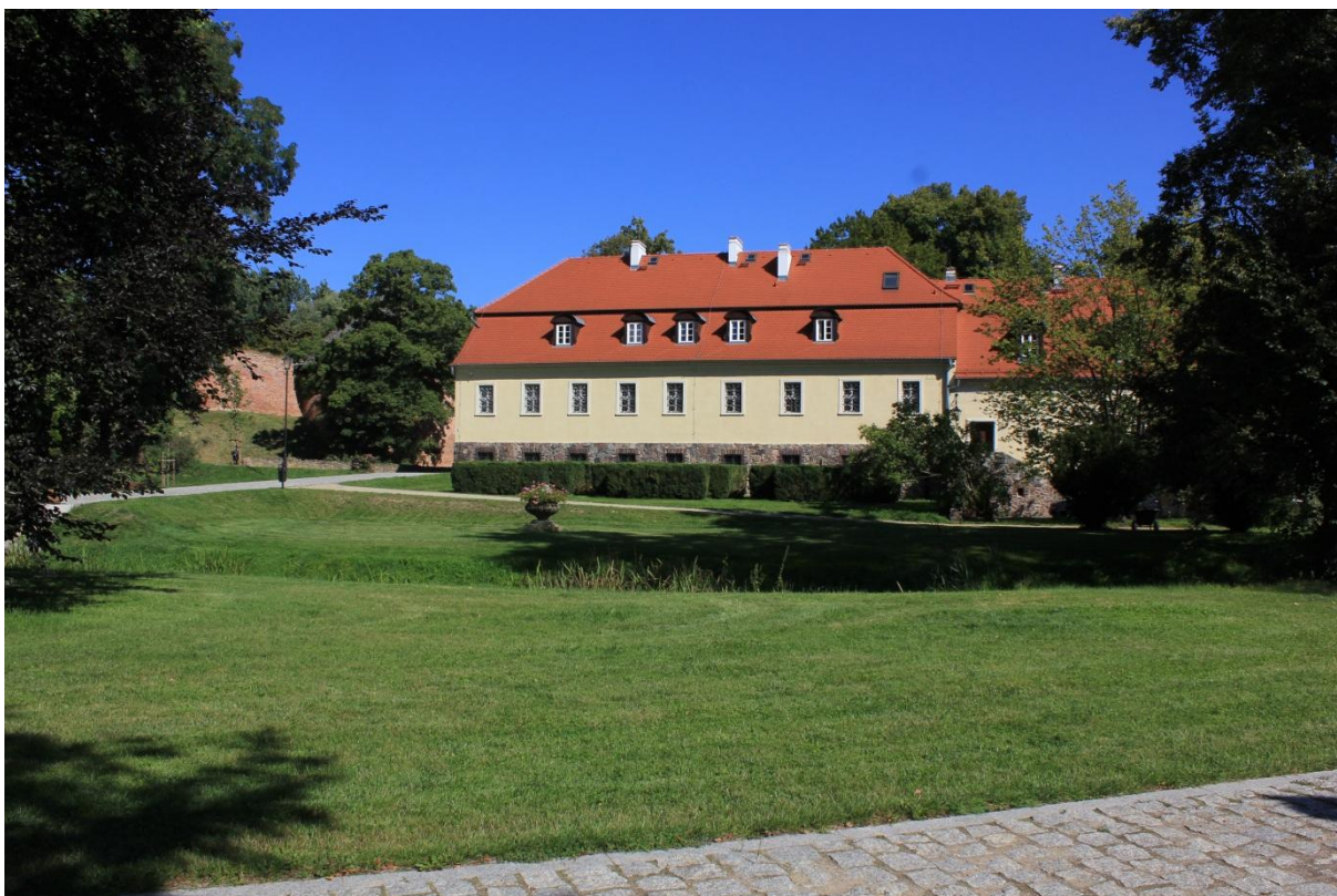
Zdjęcie istniejącej zieleni od strony południowej dawnego budynku starostwa objętej projektem systemu nawadniania.
