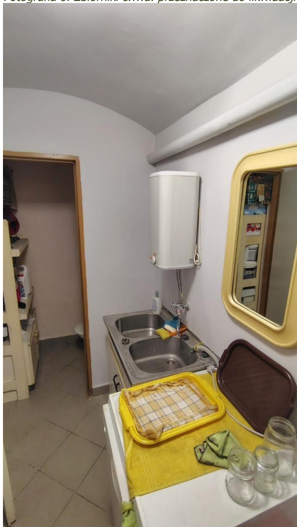
Fotografia 6. Zbiorniki c.w.u. przeznaczone do likwidacji
