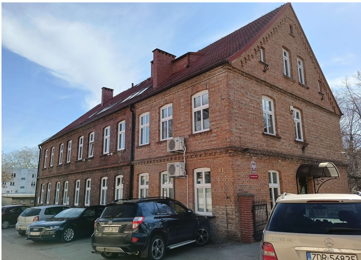
Widok elewacji północnej i zachodniej – od frontu część dobudowana, w głębi historyczna.
