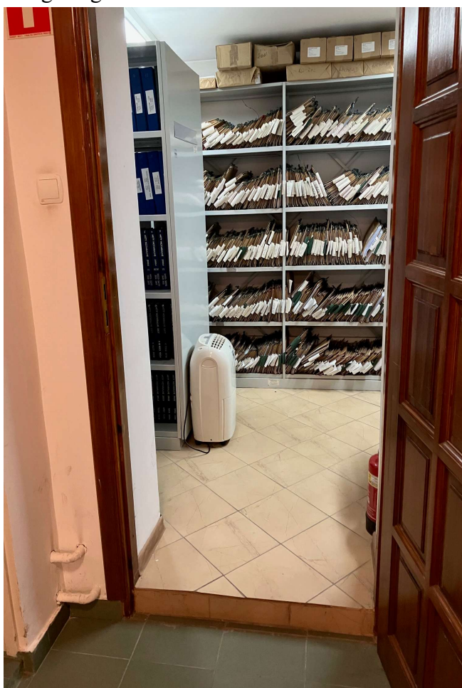
8. Piwnica – wejście do archiwum pod tarasem – drzwi z ościeżnicą do zdemontowania
