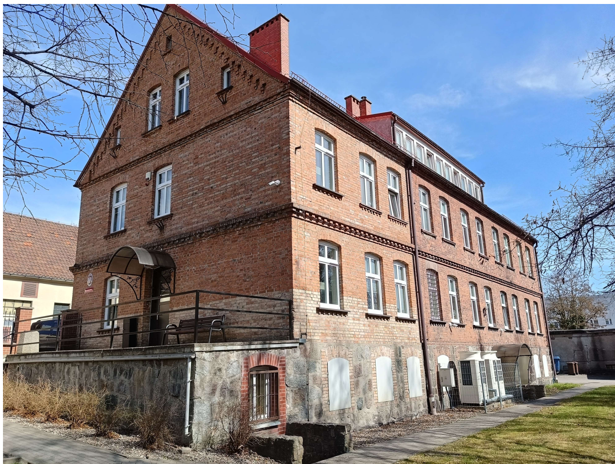
3. Elewacja południowa i zachodnia z dobudowanym tarasem wejściowym.
