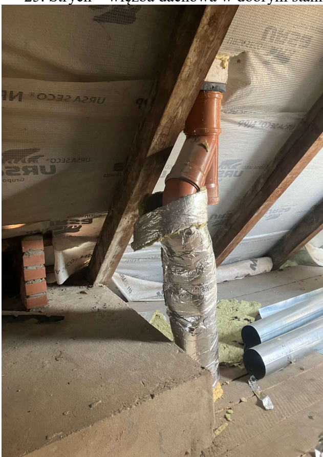
26. Strych – wentylacja grawitacyjna do wymiany.
