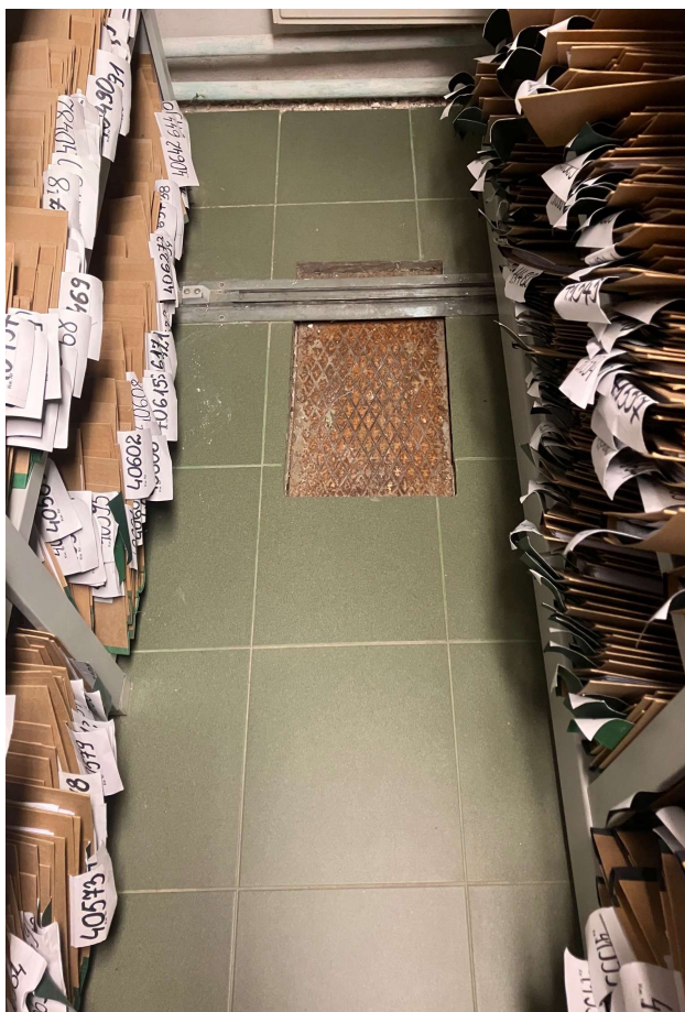
13. Piwnica – blacha zasłaniająca miejsce w którym był wpust posadzkowy.
