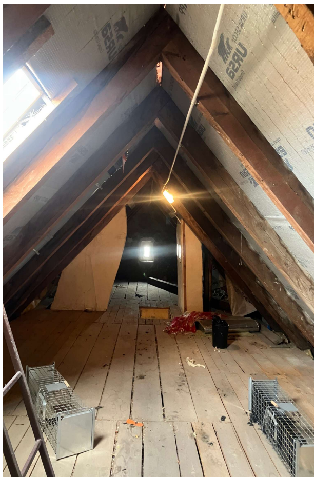
25. Strych – wieźba dachowa w dobrym stanie
