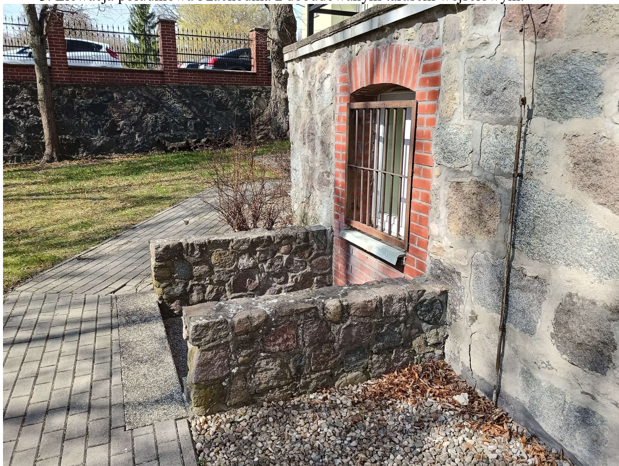
4. Nieużytkowane schody do części piwnicy.
