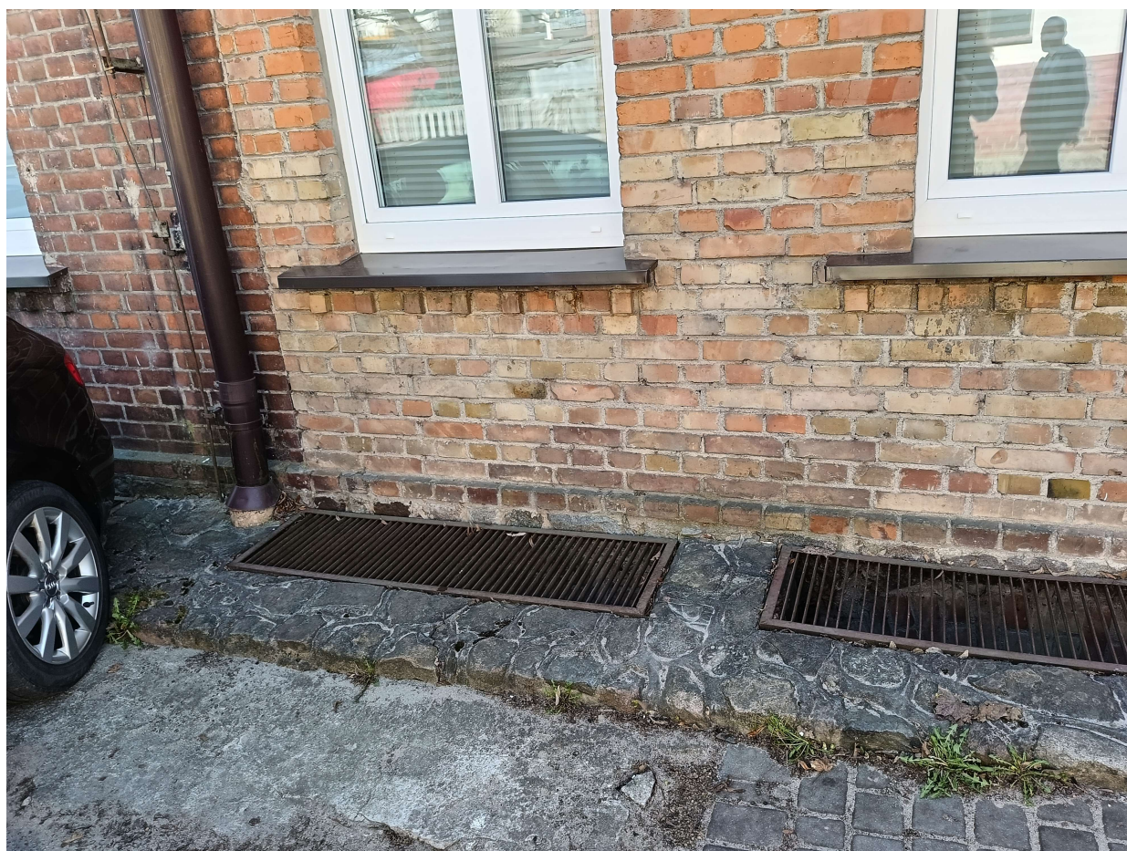
2. Obudowa studzienek okien piwnicznych
