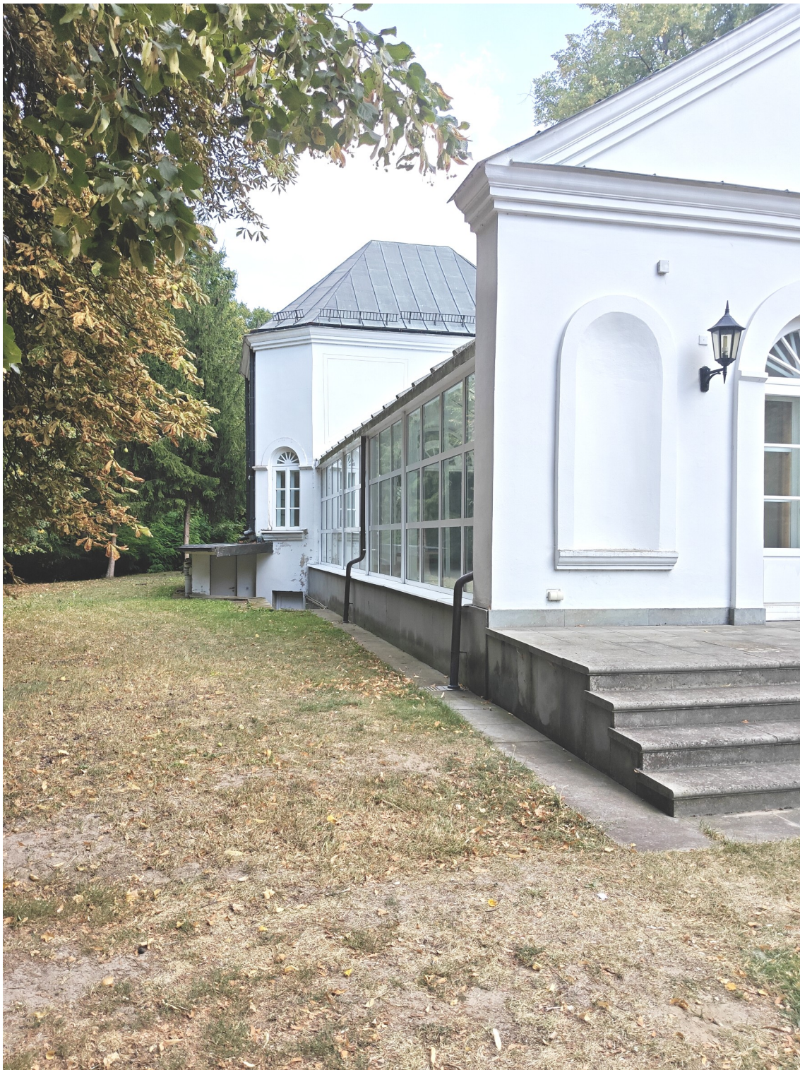
Fot. nr 8: Widok elewacji północnej (tylnej).
