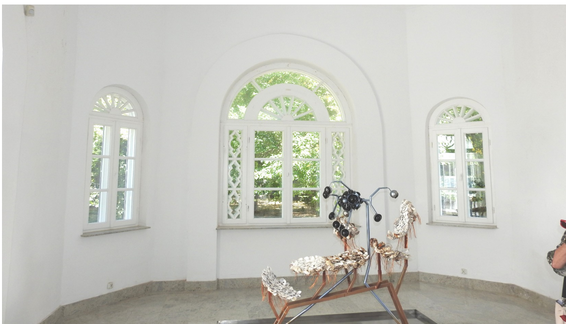
Fot. nr 18: Widok stolarki okiennej ściany północnej w strefie wejściowej.
