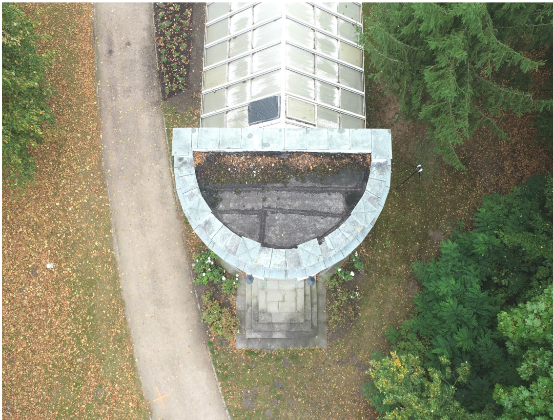
Fot. nr 4: Widok z góry strony południowo-wschodniej budynku.
