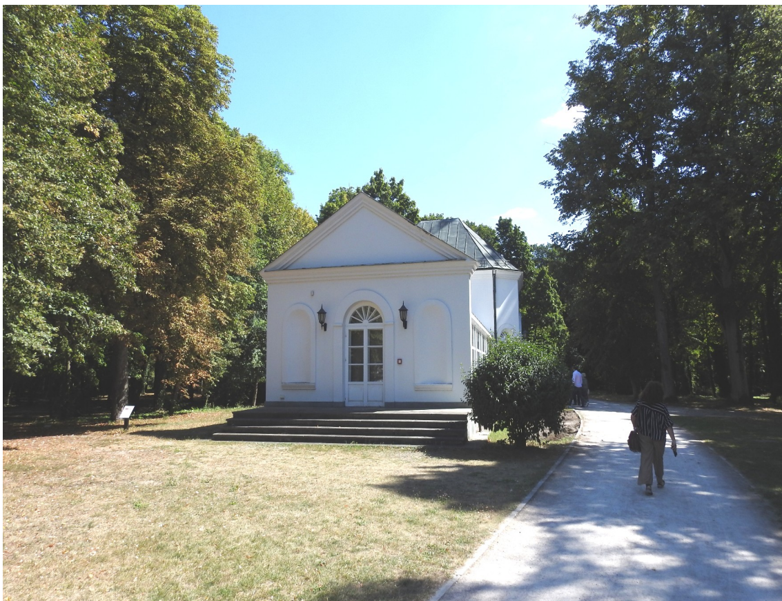
Fot. nr 7: Elewacja południowo-zachodnia.
