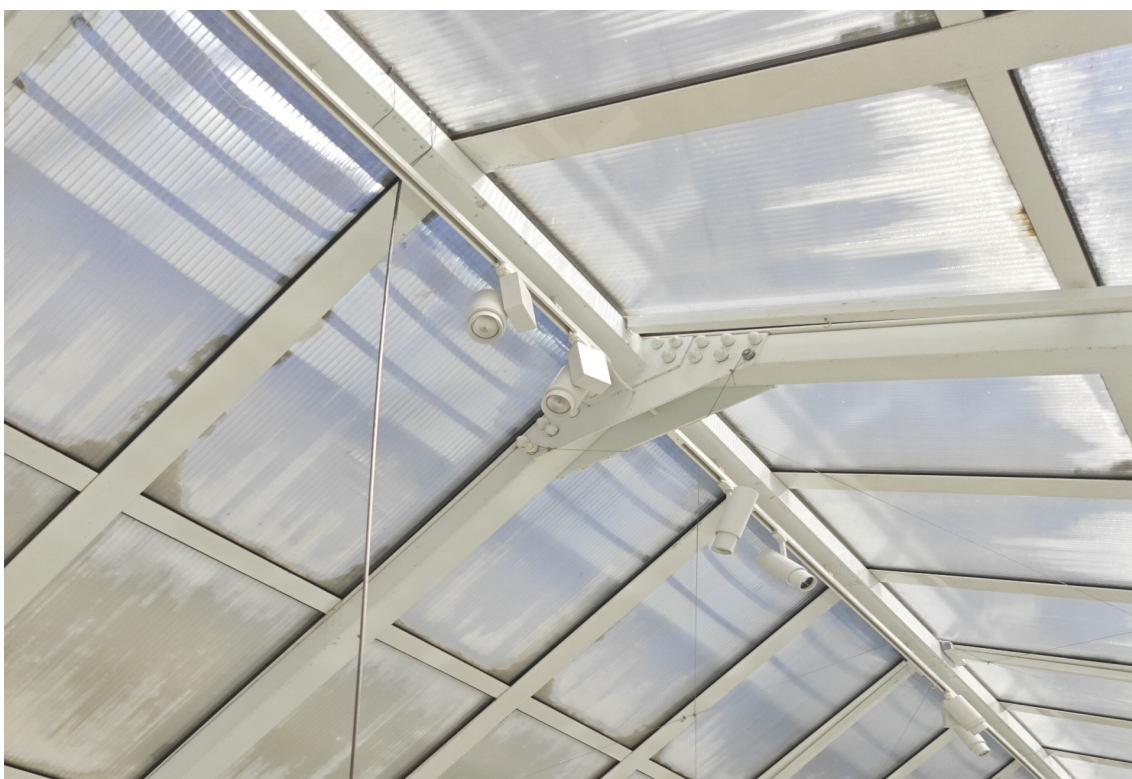
Fot. nr 20: Widok konstrukcji dachu w oranżerii – skrzydło zachodnie.
