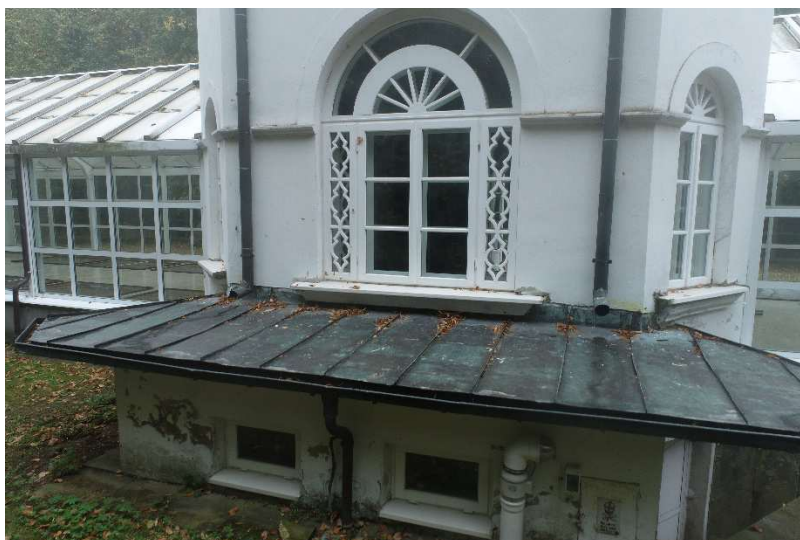
Fot 06. Widok przyziemia elewacji północno-wschodniej
