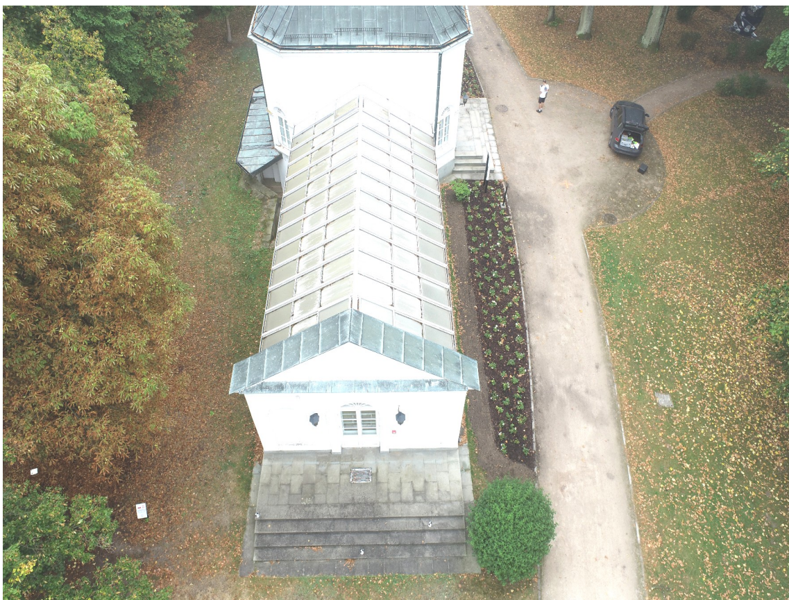
Fot. nr 2: Widok z góry strony północno-zachodniej budynku.
