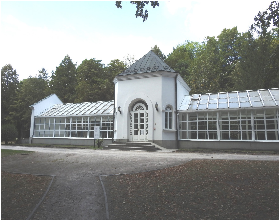
Fot. nr 6: Elewacja południowa.
