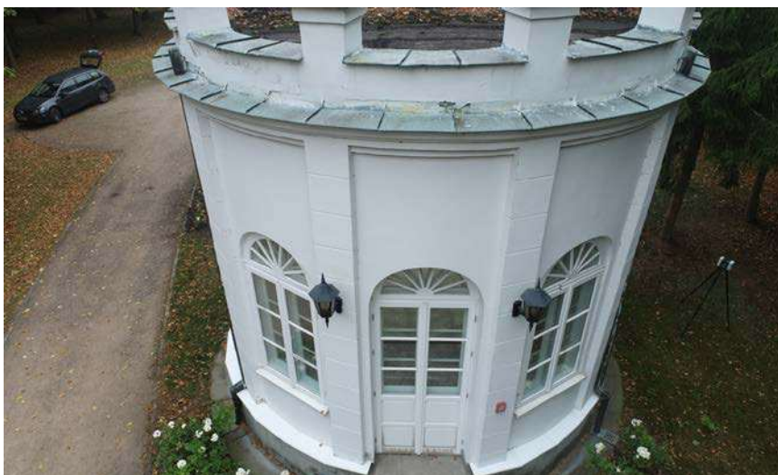
Fot 01. Elewacja południowo-wschodnia
