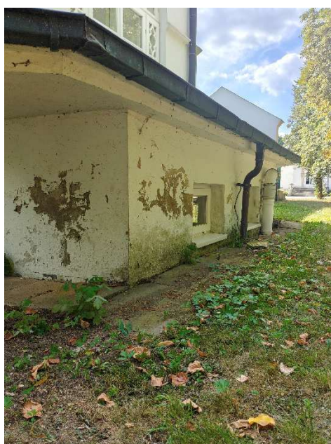
Fot 14. Odparzona farba przyziemia – po lewej widok od strony wschodniej, po prawej widok od strony północnej
