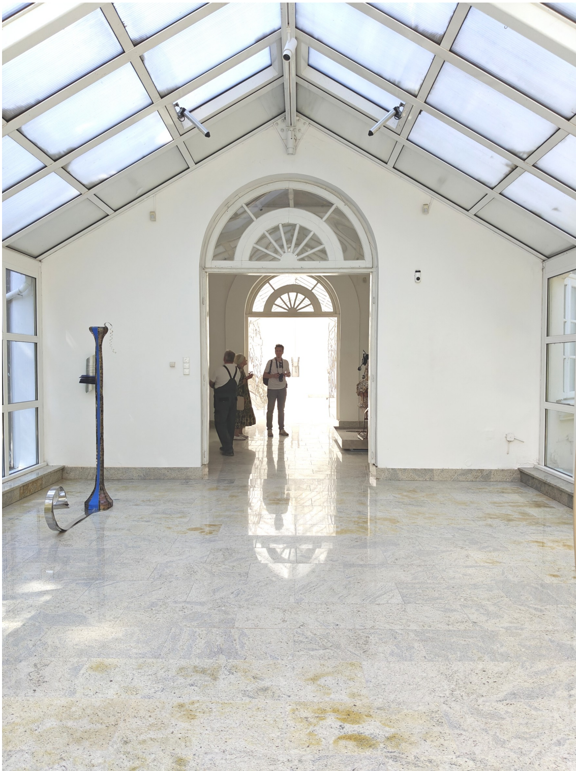
Fot. nr 16: Widok przejścia ze wschodniego skrzydła oranżerii do centralnej części budynku.
