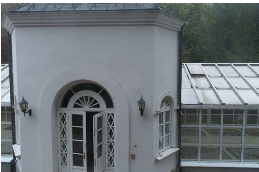
Fot 02. Wejście główne od strony południowo-zachodniej
