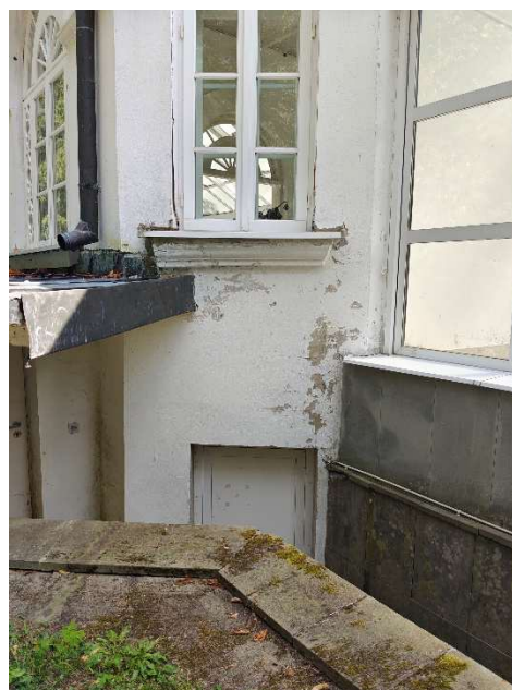
Fot 14. Odparzona farba przyziemia – po lewej widok od strony wschodniej, po prawej widok od strony północnej
