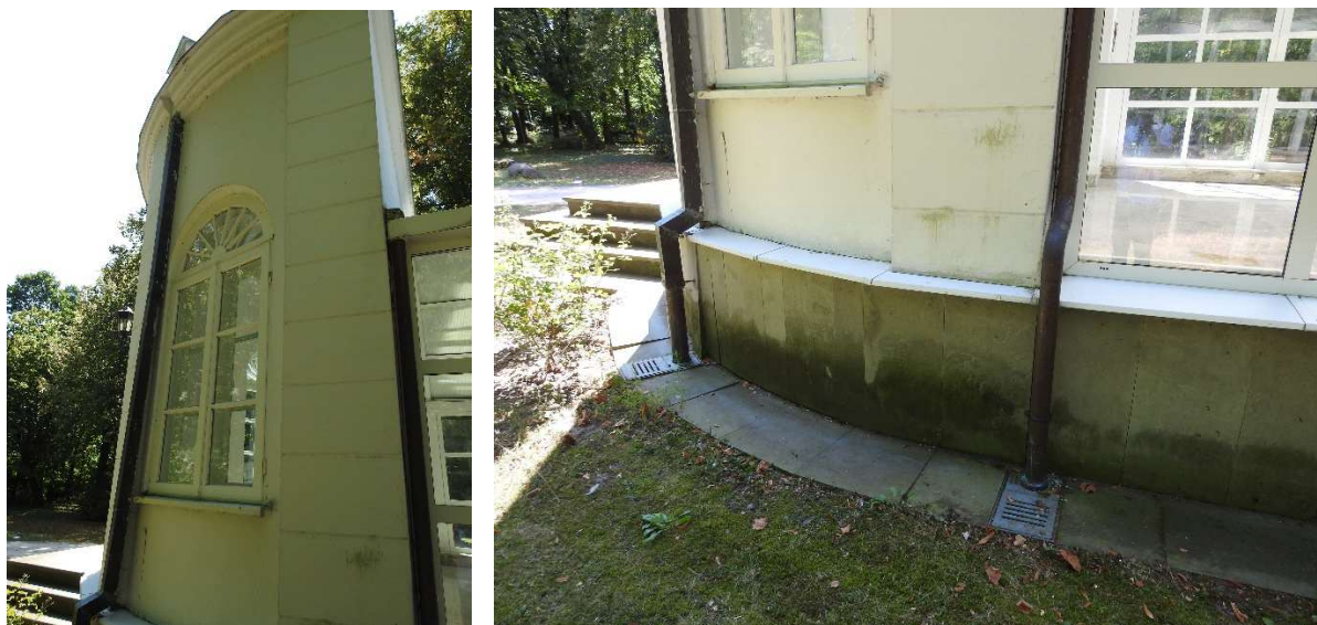
Fot 10. Odwodnienie – po lewej rury spustowe, po prawej i wpusty, widok od strony północnej.
