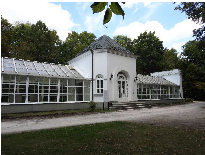
Fot 01. Elewacja południowo-zachodnia
