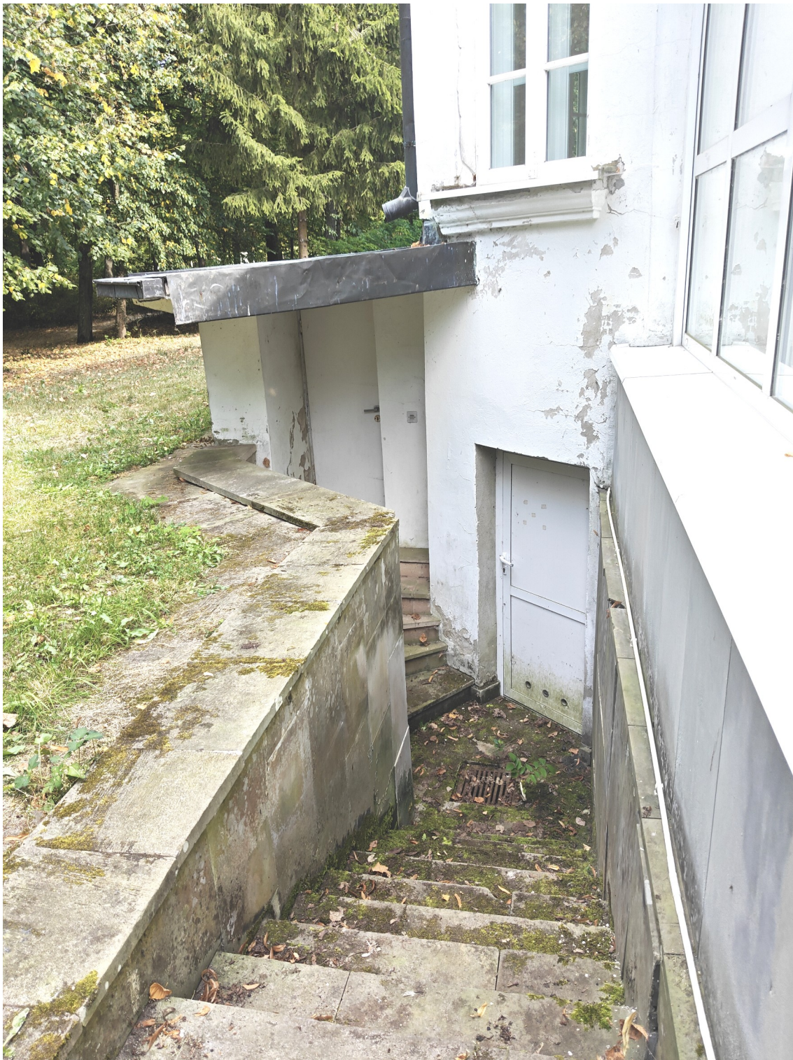
Fot. nr 9: Widok schodów do piwnicy.
