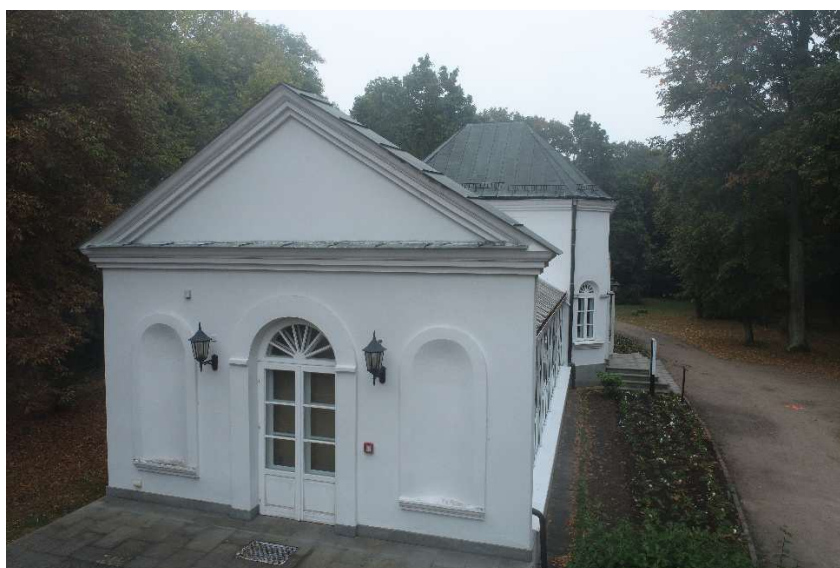
Fot 05. Elewacja północno-zachodnia
