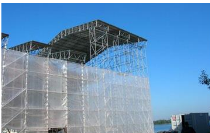
Rys. 1 Widok przykładowego zabezpieczenia budynku przed zalaniem podczas remontu dachu
