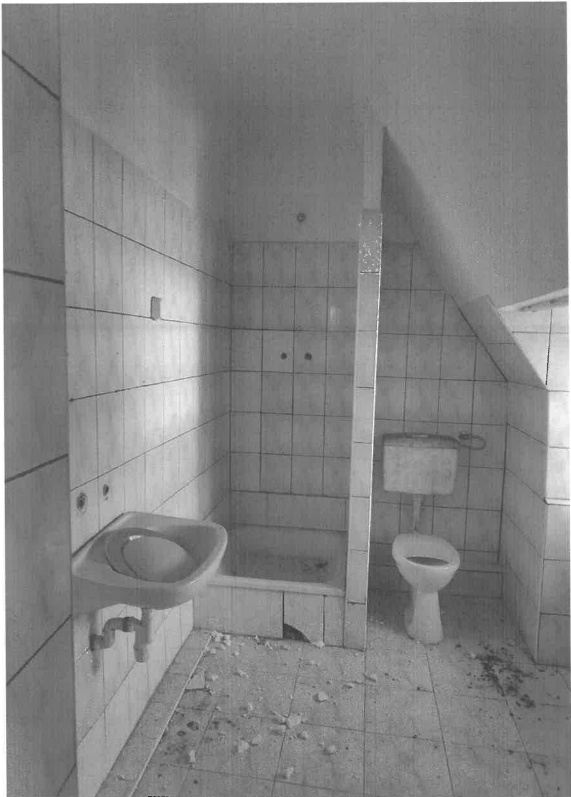
Budynek „Syrenka” - wnętrze, poddasze.
