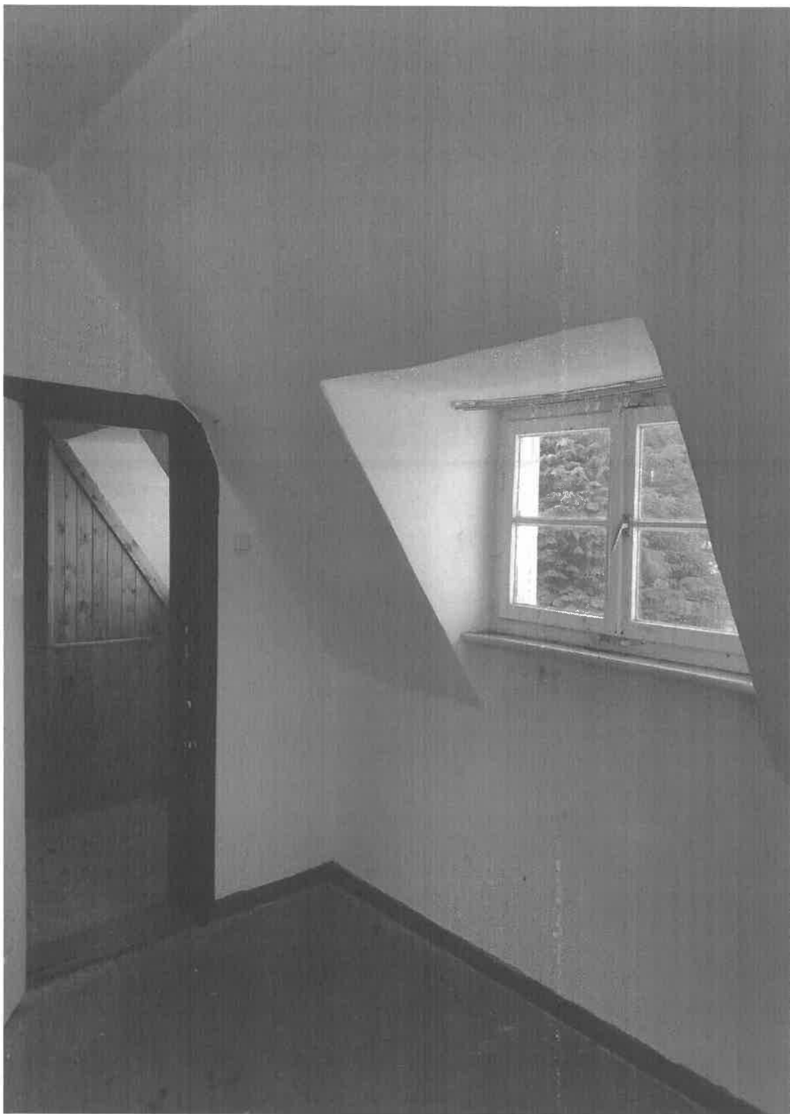
Budynek „Syrenka” - wnętrze, poddasze.
