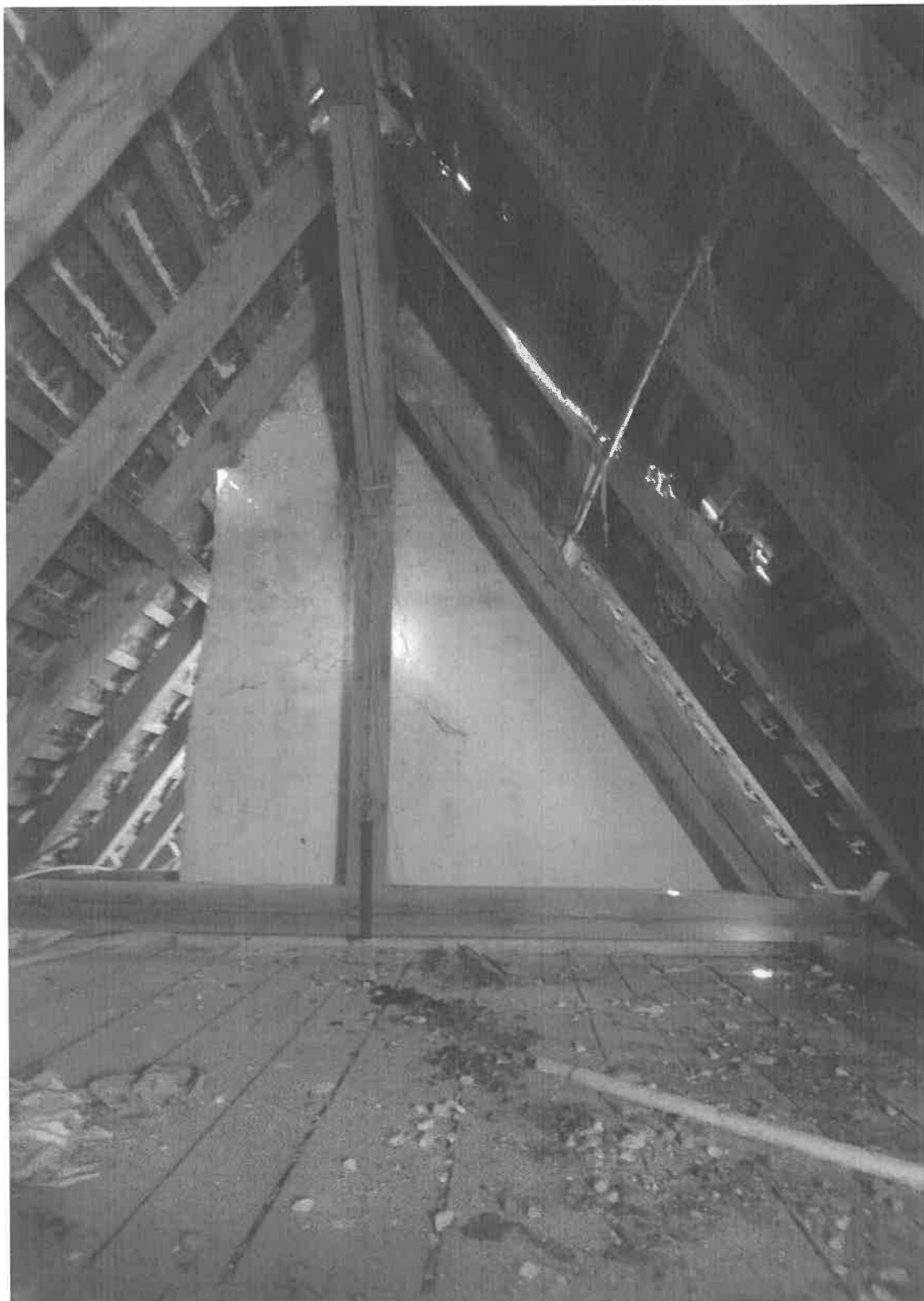
Budynek „Syrenka” - wnętrze, przestrzeń nieużytkowa poddasza.
