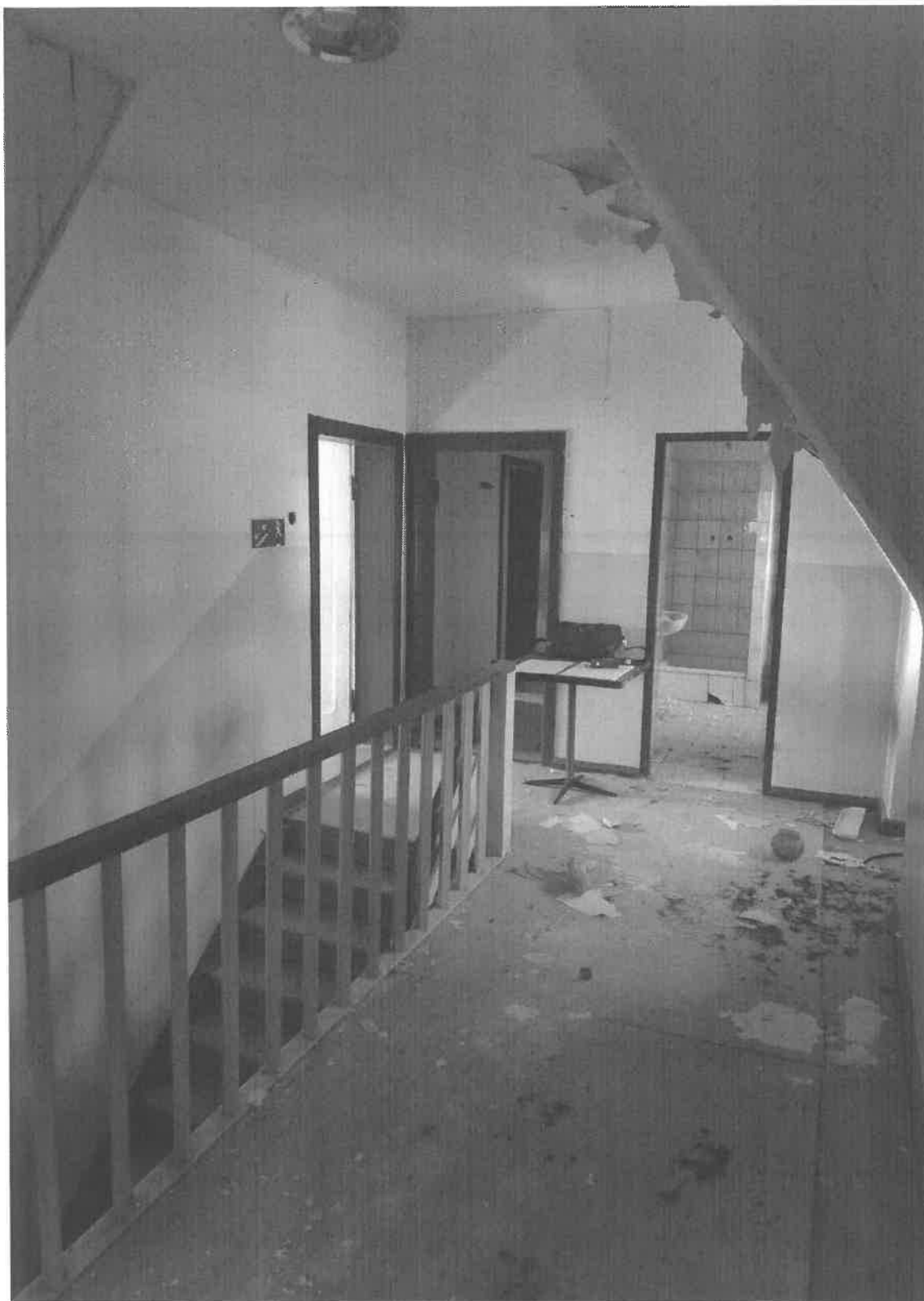
Budynek „Syrenka” - wnętrze, poddasze.
