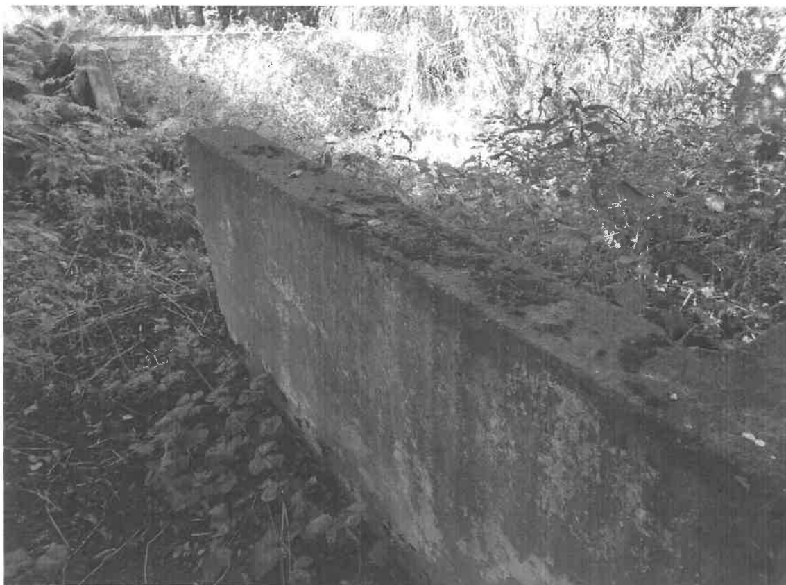
Mury przy budynku „Kopciuszek”.
