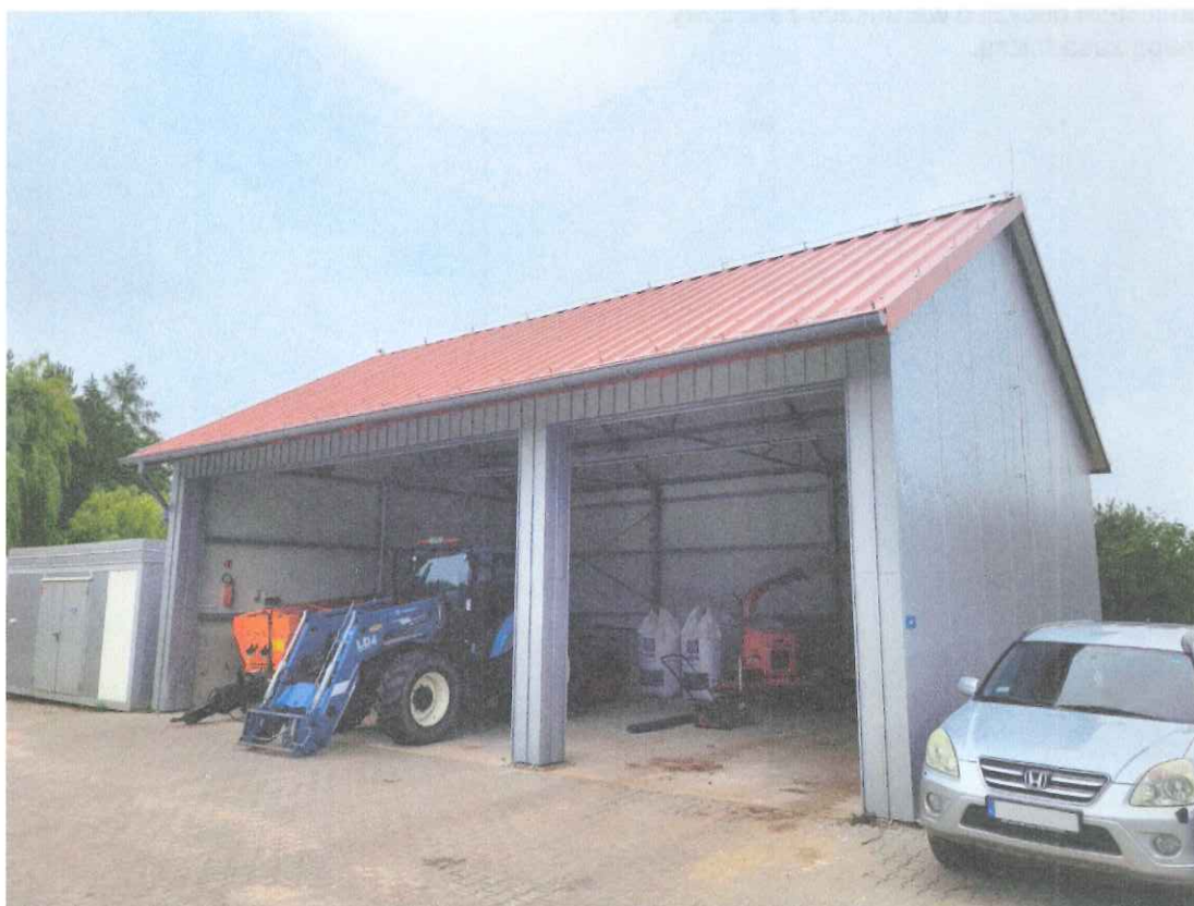
Fot. Widok istniejącej wiaty garażowej która będzie sąsiadować z nową halą magazynową
