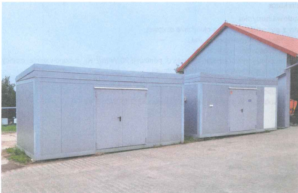
Fot. Widok na miejsce lokalizacji nowej hali magazynowej
