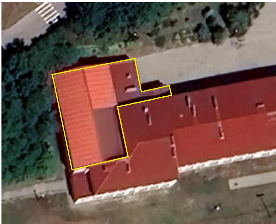
Widok dachu sali sportowej Szkoły Podstawowej w Słupnie wraz z zaznaczonym zakresem prac remontowych
